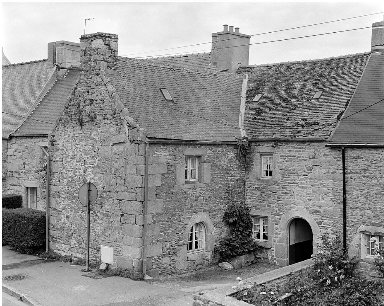
Elévation sud, vue générale
