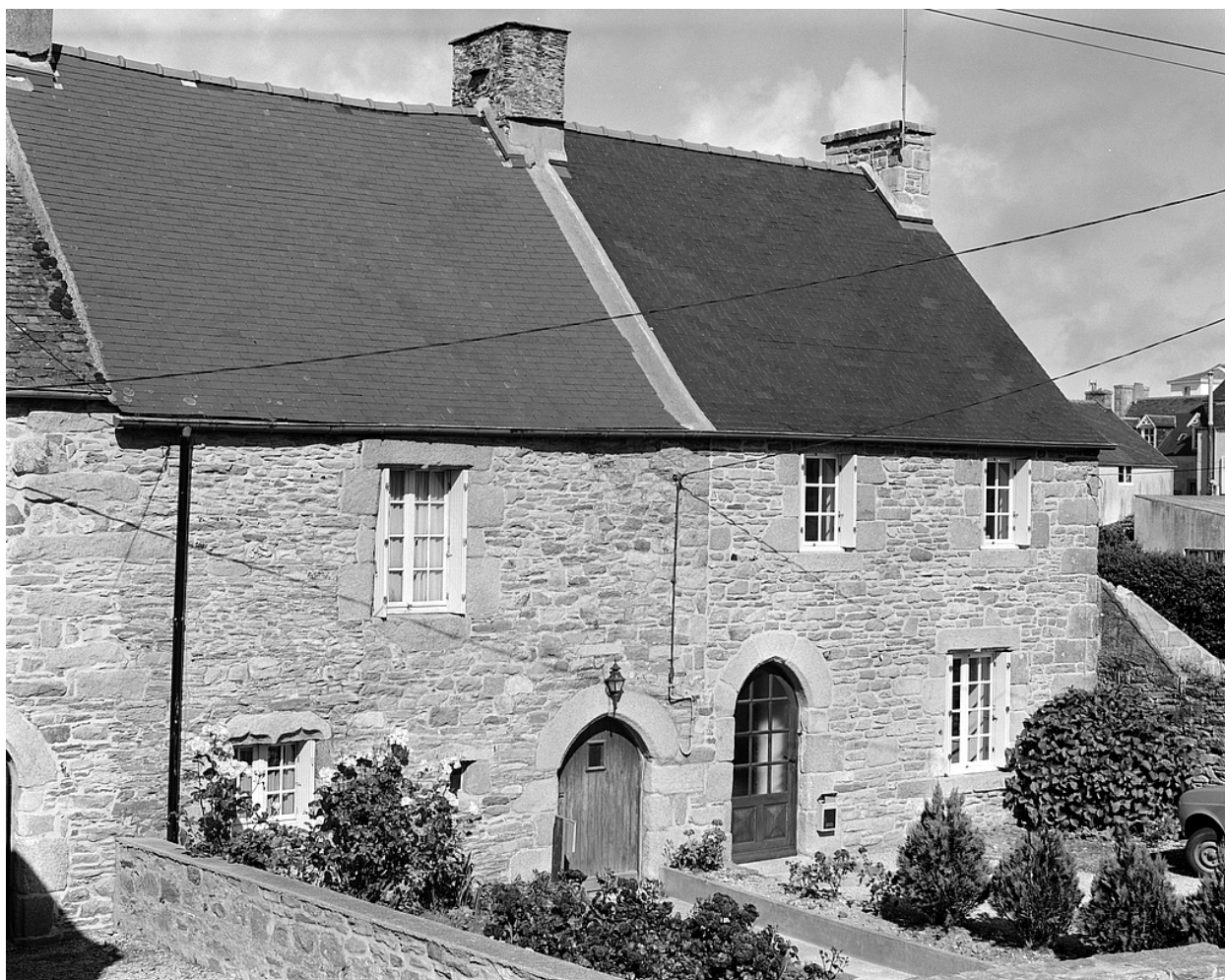
Pignon sud-ouest, vue générale
