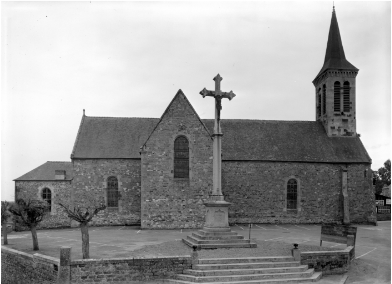
Elévation Est : vue générale
