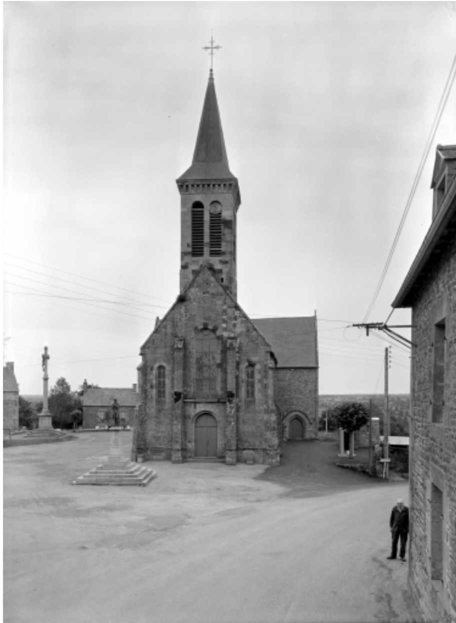
Elévation Nord : vue générale
