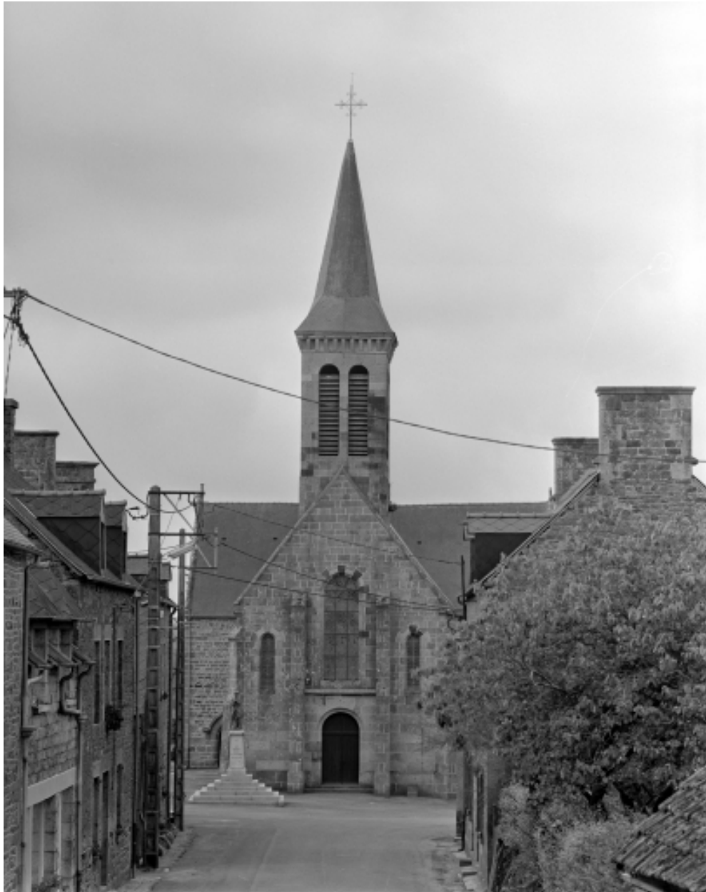
Elévation Nord : vue générale
