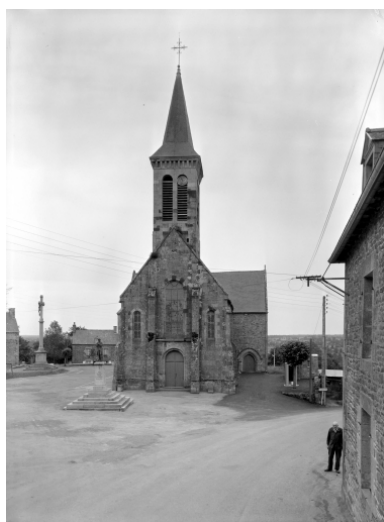
Elévation Nord : vue générale Phot. Guy Artur, Phot. Norbert Lambart IVR53_19773500376V
