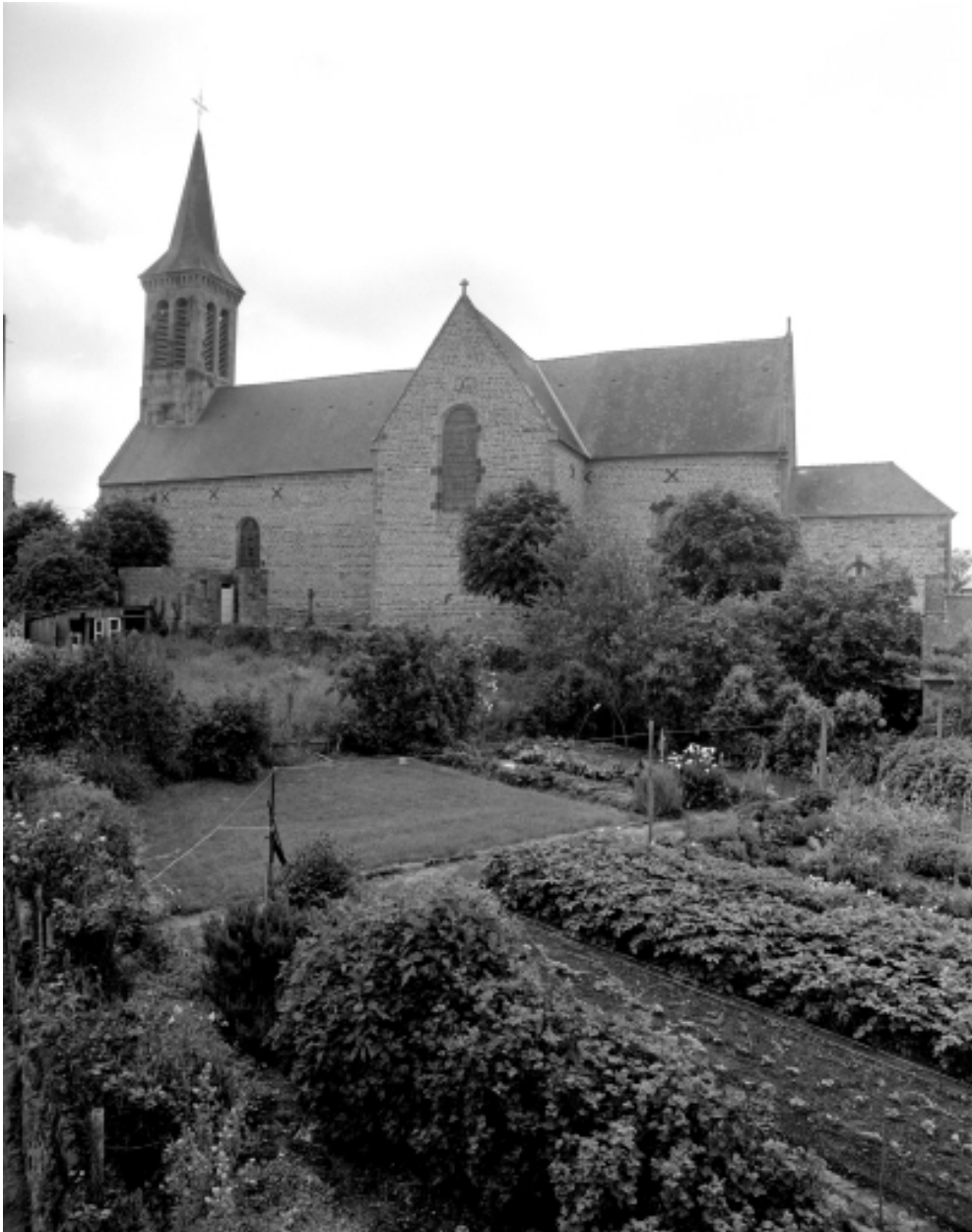
Elévation Ouest : vue générale
