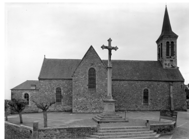
Elévation Est : vue générale Phot. Guy Artur, Phot. Norbert Lambart IVR53_19773500375V
