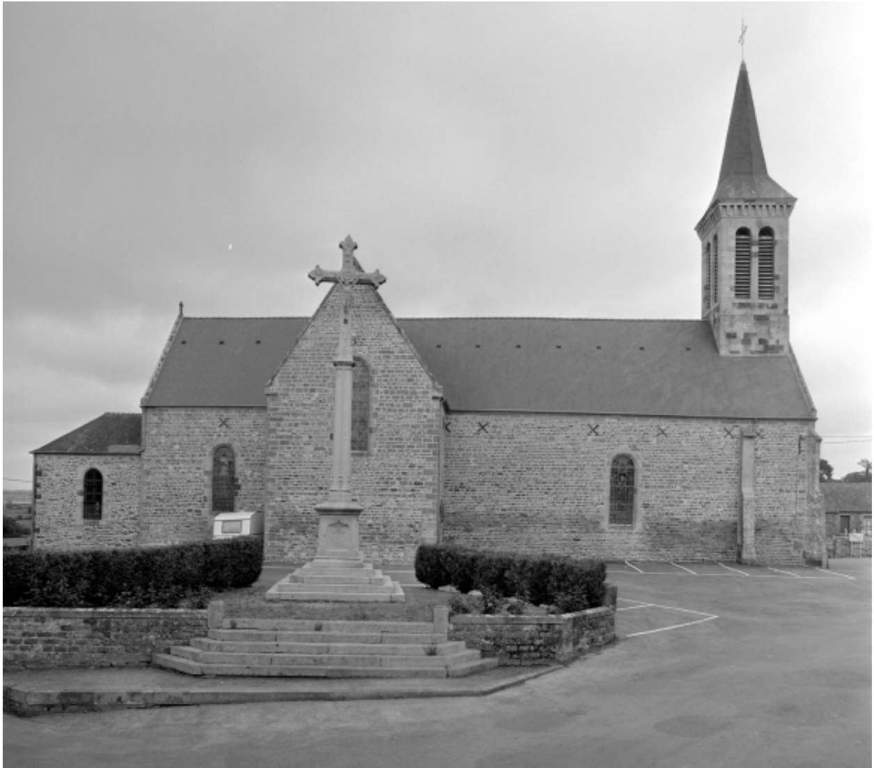
Elévation Est : vue générale
