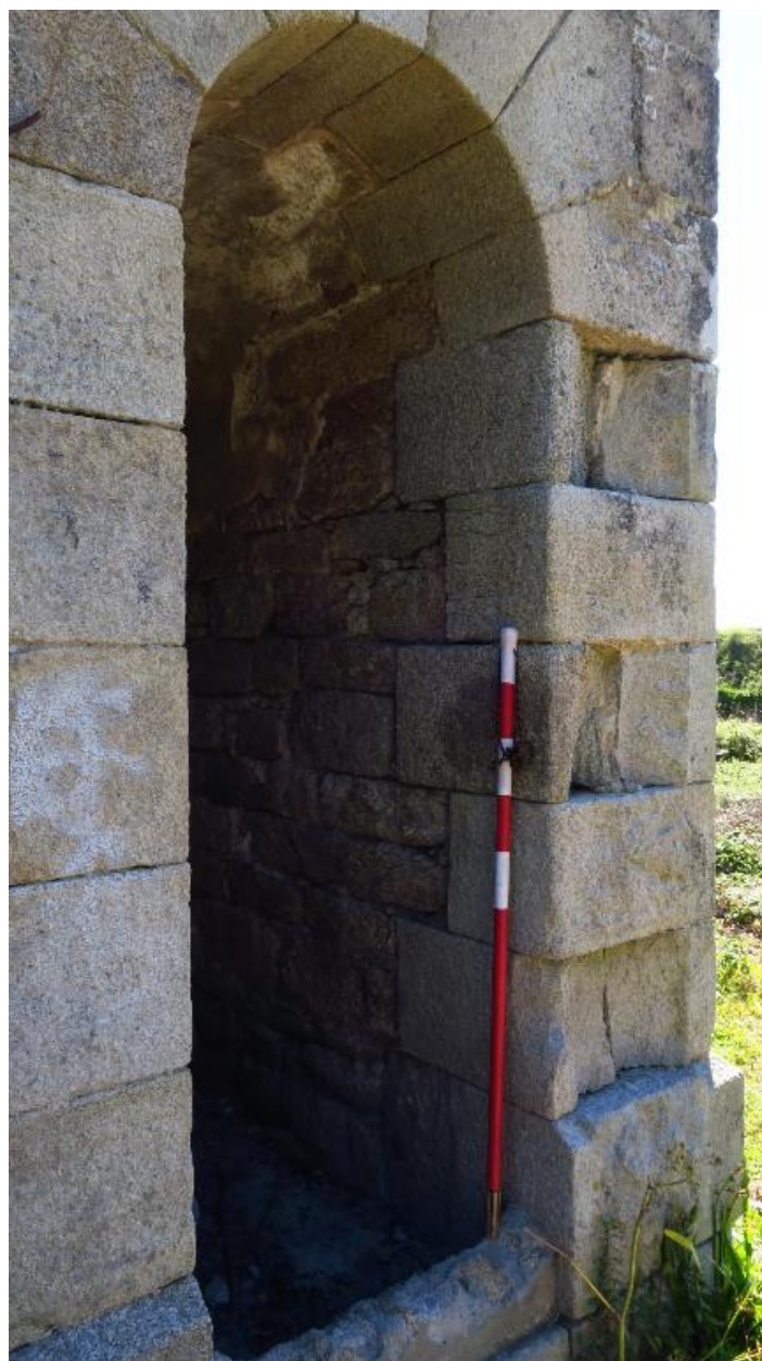
Fort central, Île-d'Houat. Magasin à poudre, entrée nord de la gaine latérale ouest
