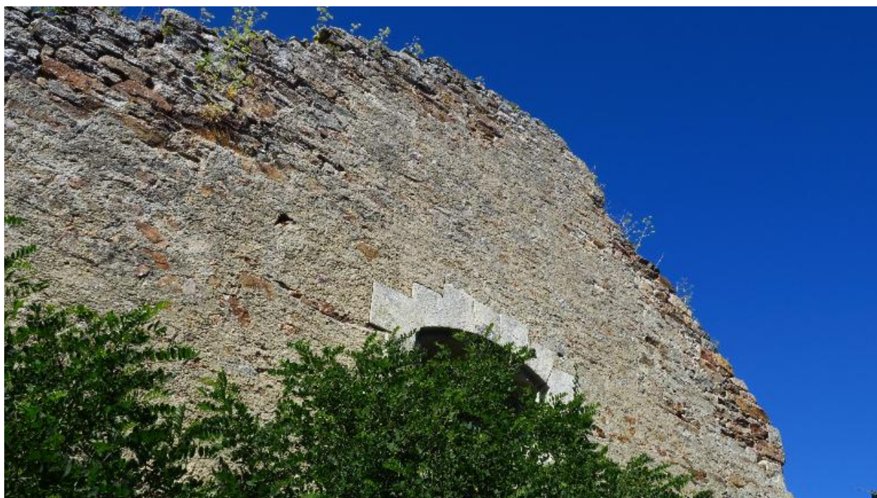
Fort central, Île-d'Houat. Magasin à poudre, détail de la façade sud
