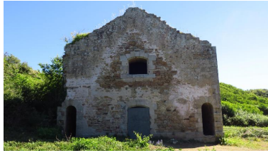
Fort central, Île-d'Houat. Magasin à poudre, façade nord Phot. Lionel Duigou IVR53_20165606097NUCA
