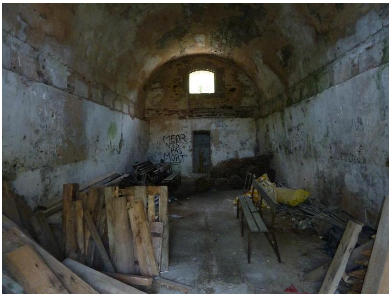
Fort central, Île-d'Houat. Magasin à poudre, intérieur
