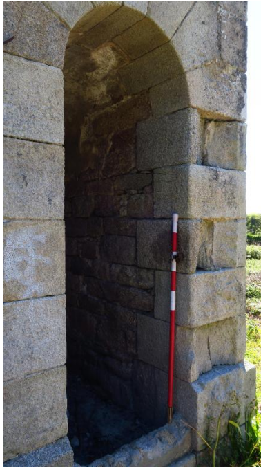
Fort central, Île-d'Houat. Magasin à poudre, entrée nord de la gaine latérale ouest Phot. Lionel Duigou IVR53_20165606103NUCA
