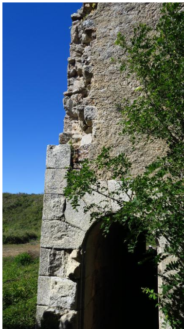
Fort central, Île-d'Houat. Magasin à poudre, détail de la façade sud Phot. Lionel Duigou IVR53_20165606100NUCA
