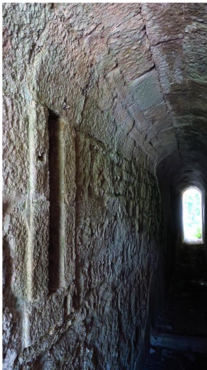
Fort central, Île-d'Houat. Magasin à poudre, évent dans la gaine latérale ouest
