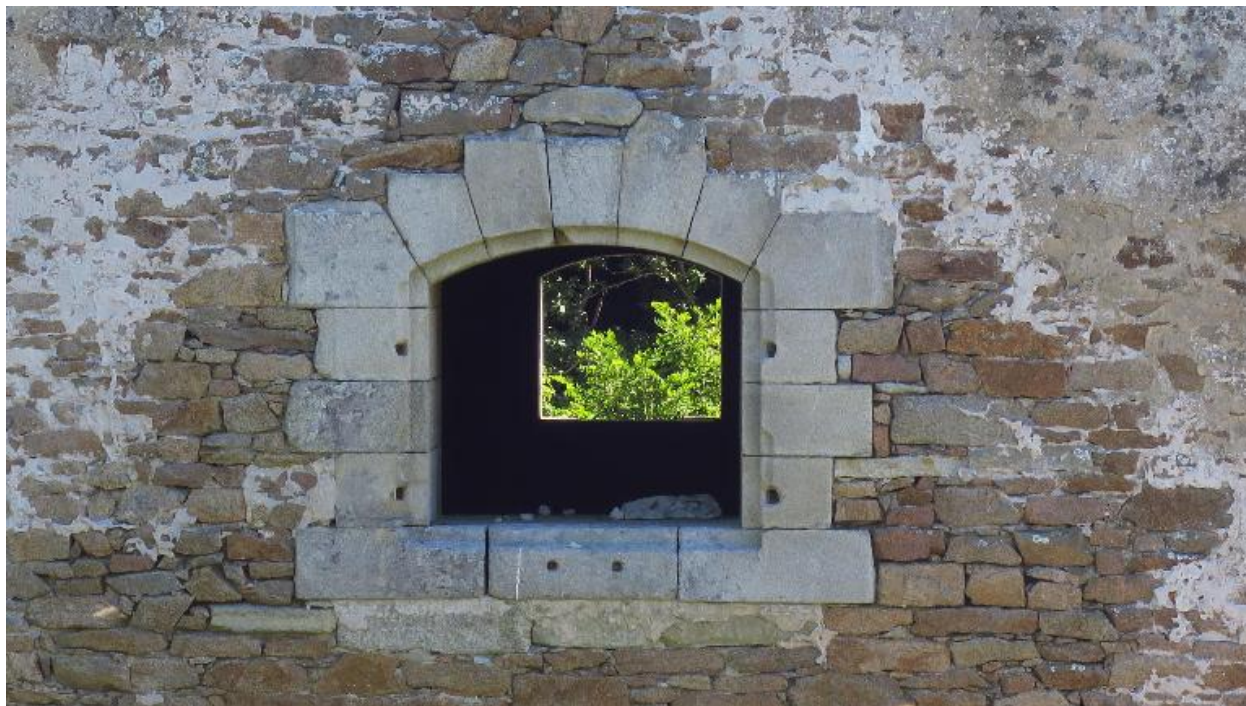
Fort central, Île-d'Houat. Magasin à poudre, détail de la fenêtre de la façade nord
