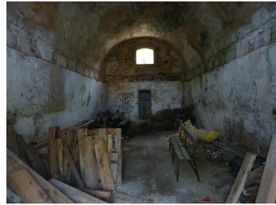
Fort central, Île-d'Houat. Magasin à poudre, intérieur Phot. Patrick Jadé IVR53_20165606104NUCA
