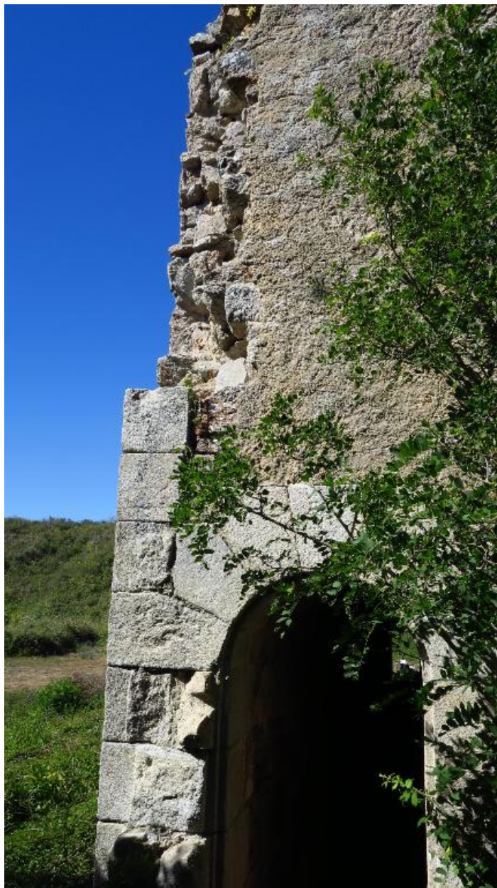
Fort central, Île-d'Houat. Magasin à poudre, détail de la façade sud
