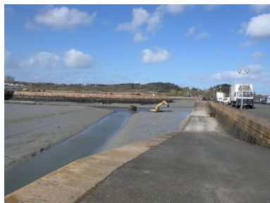
Vue des deux cales de Kernoa, vaigrées en ciment et du mur de quai intérieur en moellons de granite, en face des enrochements de Kerpallud Phot. Guy Prigent IVR53_20092212833NUCA
