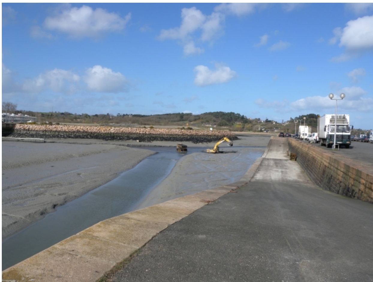
Vue des deux cales de Kerno, vaigrées en ciment et du mur de quai intérieur en moellons de granite, en face des enrochements de Kerpallud
