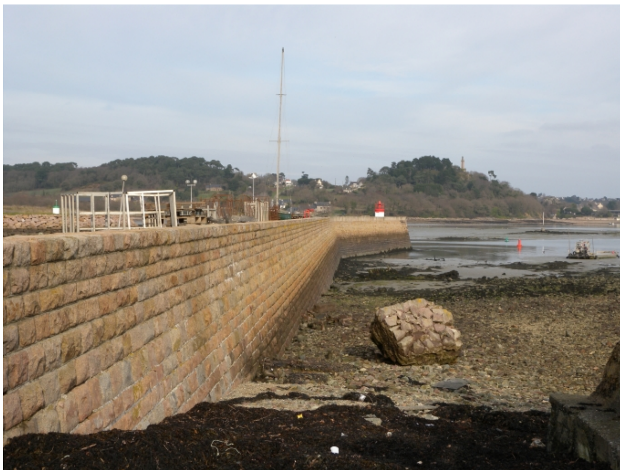
Vue du mur et quai de la jetée de Kerno
