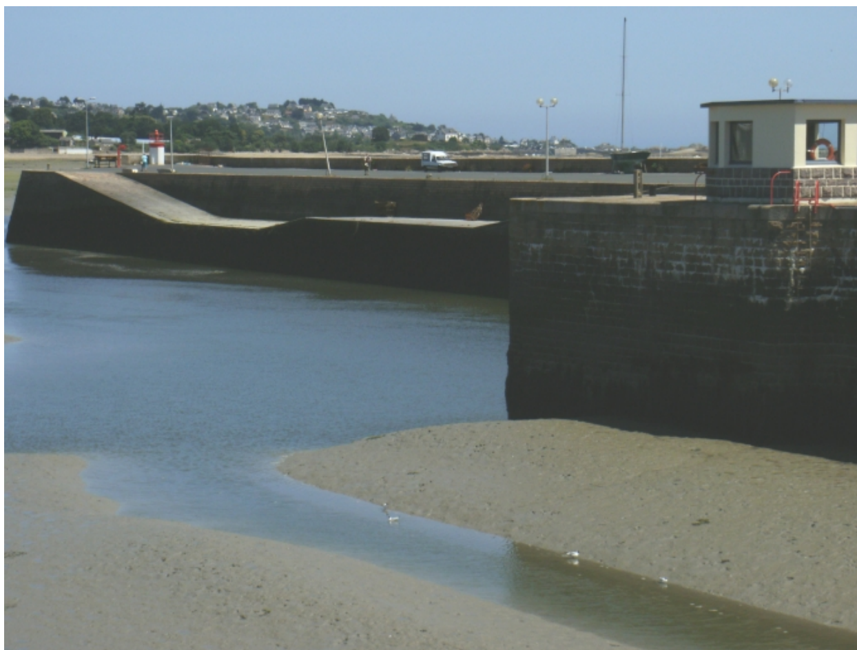
Vue générale de la jetée et des deux cales depuis le quai des Bréhatins
