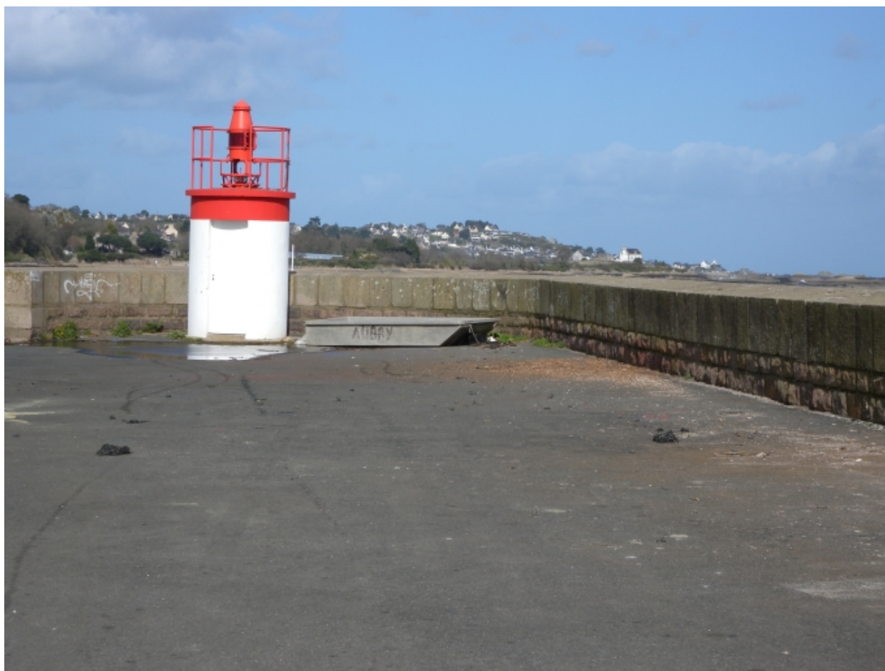
Vue du feu d'entrée de port sur le musoir de la jetée
