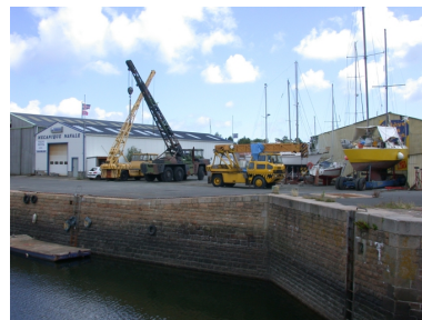
Vue des quais de Kernoa et de la zone artisanale maritime Phot. Guy Prigent IVR53_20092212835NUCA
