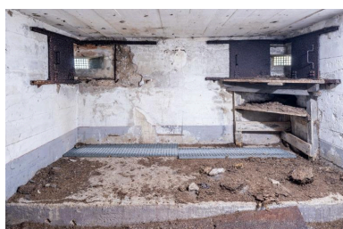
Vue intérieure : ouvertures de tir avec double volet blindé et support d'affût en bois pour mitrailleuse (état en 2026). Au niveau du sol : ouverture de tir rappelant les mâchicoulis Phot. Charlotte Barraud IVR53_20262900206NUCA
