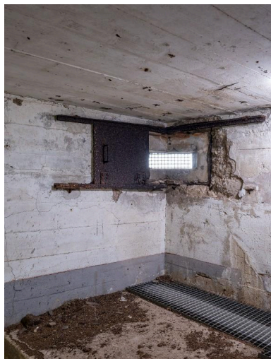
Vue intérieure : ouverture de tir avec double volet blindé (état en 2026). Au niveau du sol : ouverture de tir rappelant les mâchicoulis Phot. Charlotte Barraud IVR53_20262900204NUCA
