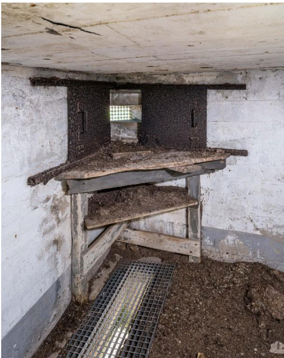
Vue intérieure : ouverture de tir avec double volet blindé et support d'affût en bois pour mitrailleuse (état en 2026). Au niveau du sol : ouverture de tir rappelant les mâchicoulis
