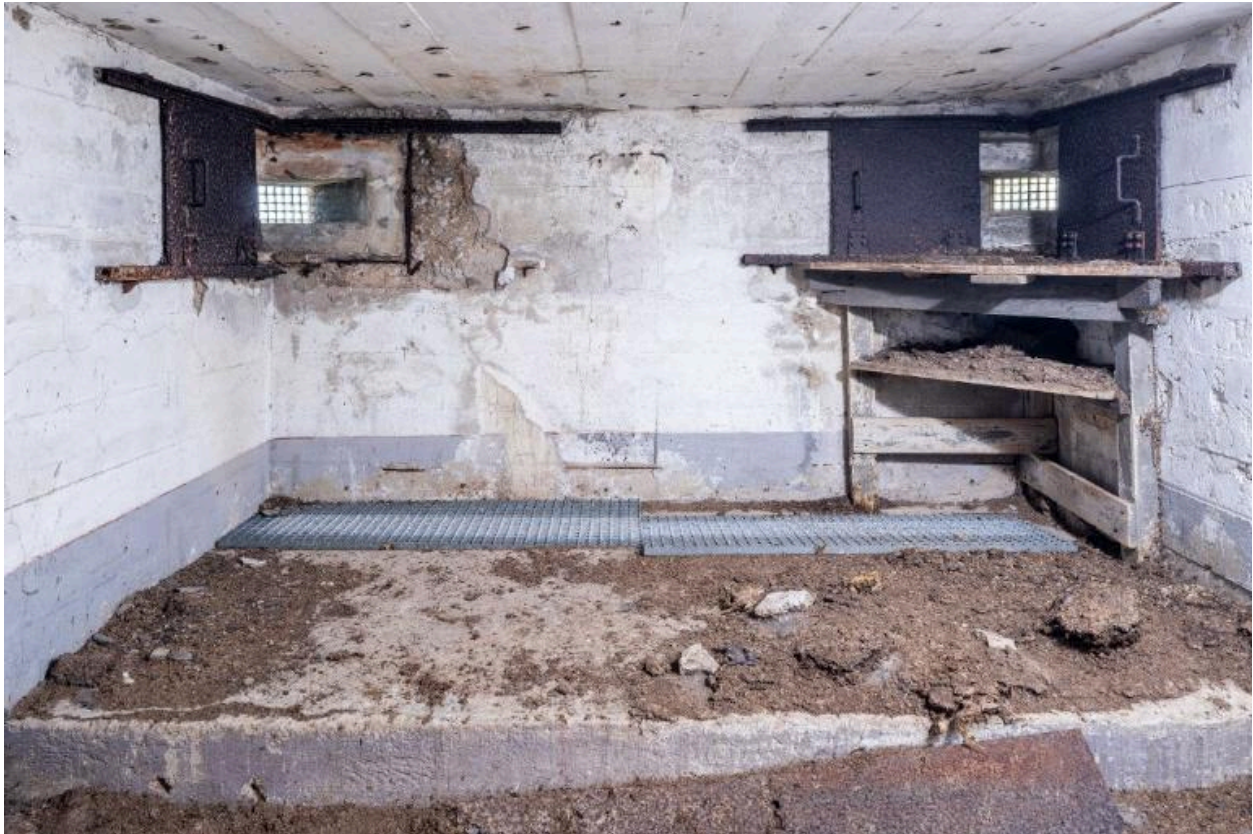
Vue intérieure : ouvertures de tir avec double volet blindé et support d'affût en bois pour mitrailleuse (état en 2026). Au niveau du sol : ouverture de tir rappelant les mâchicoulis
