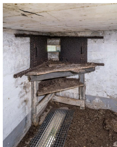
Vue intérieure : ouverture de tir avec double volet blindé et support d'affût en bois pour mitrailleuse (état en 2026). Au niveau du sol : ouverture de tir rappelant les mâchicoulis Phot. Charlotte Barraud IVR53_20262900205NUCA
