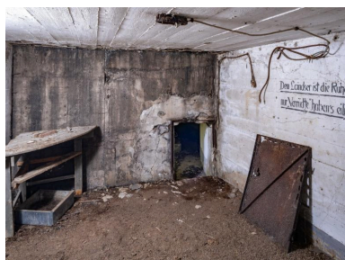
Vue intérieure : entrée avec sa porte déposée (état en 2026). A droite : peinture de propagande. A gauche, déplacé, support d'affût en bois pour mitrailleuse de l'ouverture de tir. Sur le mur et au plafond, le câblage électrique du plafonnier Phot. Charlotte Barraud IVR53_20262900207NUCA
