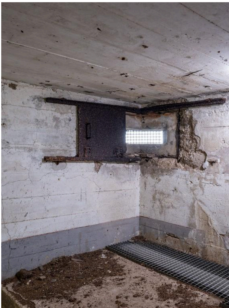
Vue intérieure : ouverture de tir avec double volet blindé (état en 2026). Au niveau du sol : ouverture de tir rappelant les mâchicoulis
