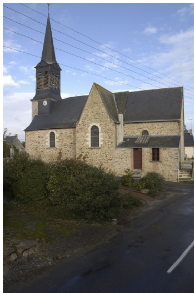
Vue générale sud de l'église Phot. Alain Dagorn IVR53_20043502186NUCA
