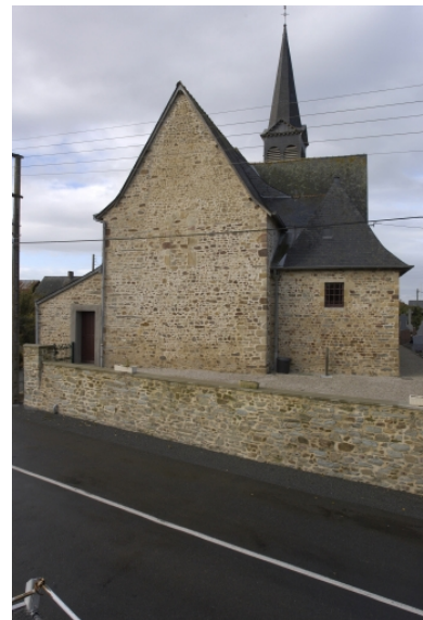
Vue est de l'église Phot. Alain Dagorn IVR53_20043502187NUCA
