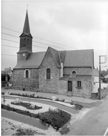
Élévation sud : vue générale Phot. Guy Artur, Phot. Norbert Lambart IVR53_19943501505X
