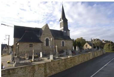
Vue générale nord-est Phot. Alain Dagorn IVR53_20043502185NUCA
