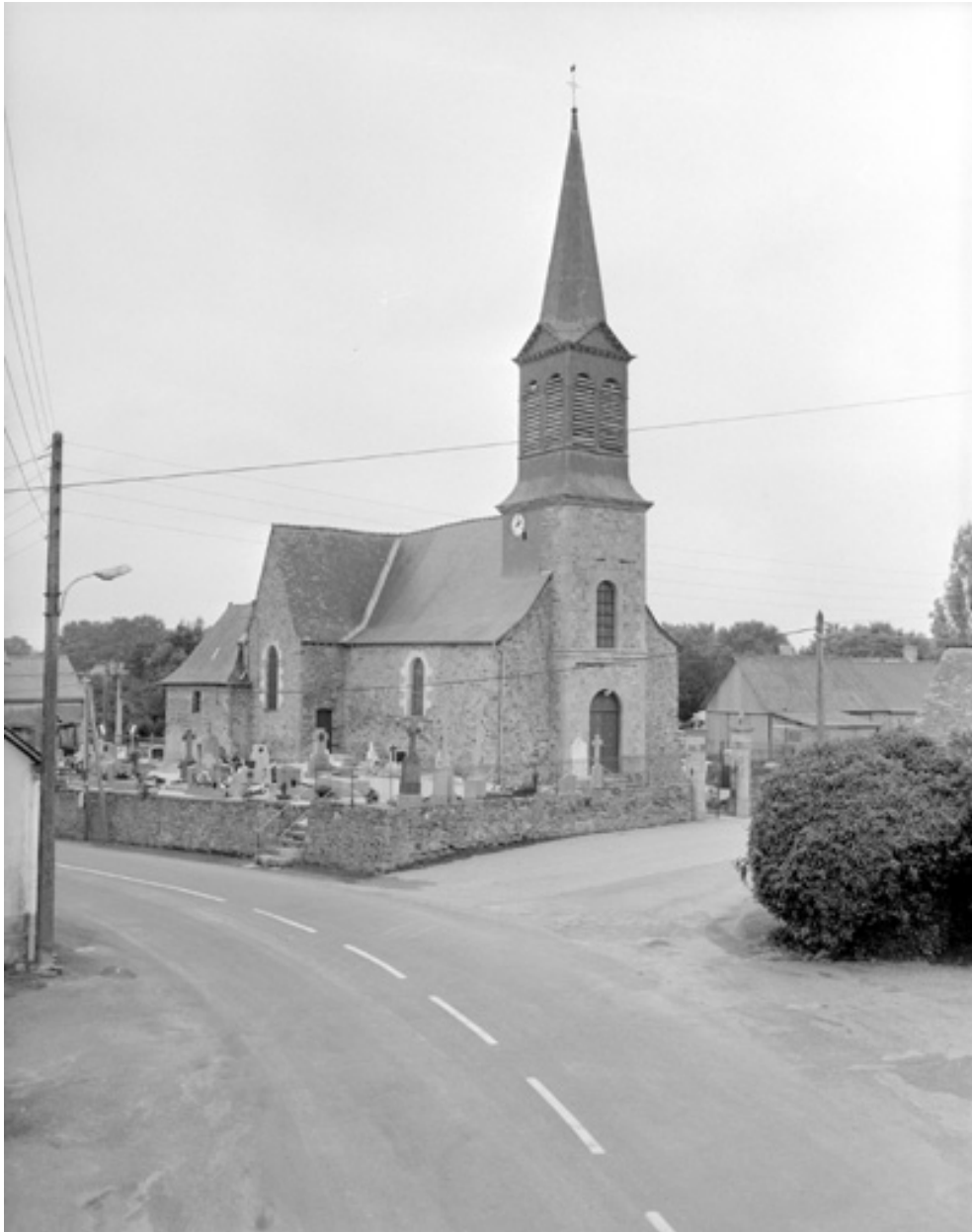
Élévation nord-ouest : vue générale
