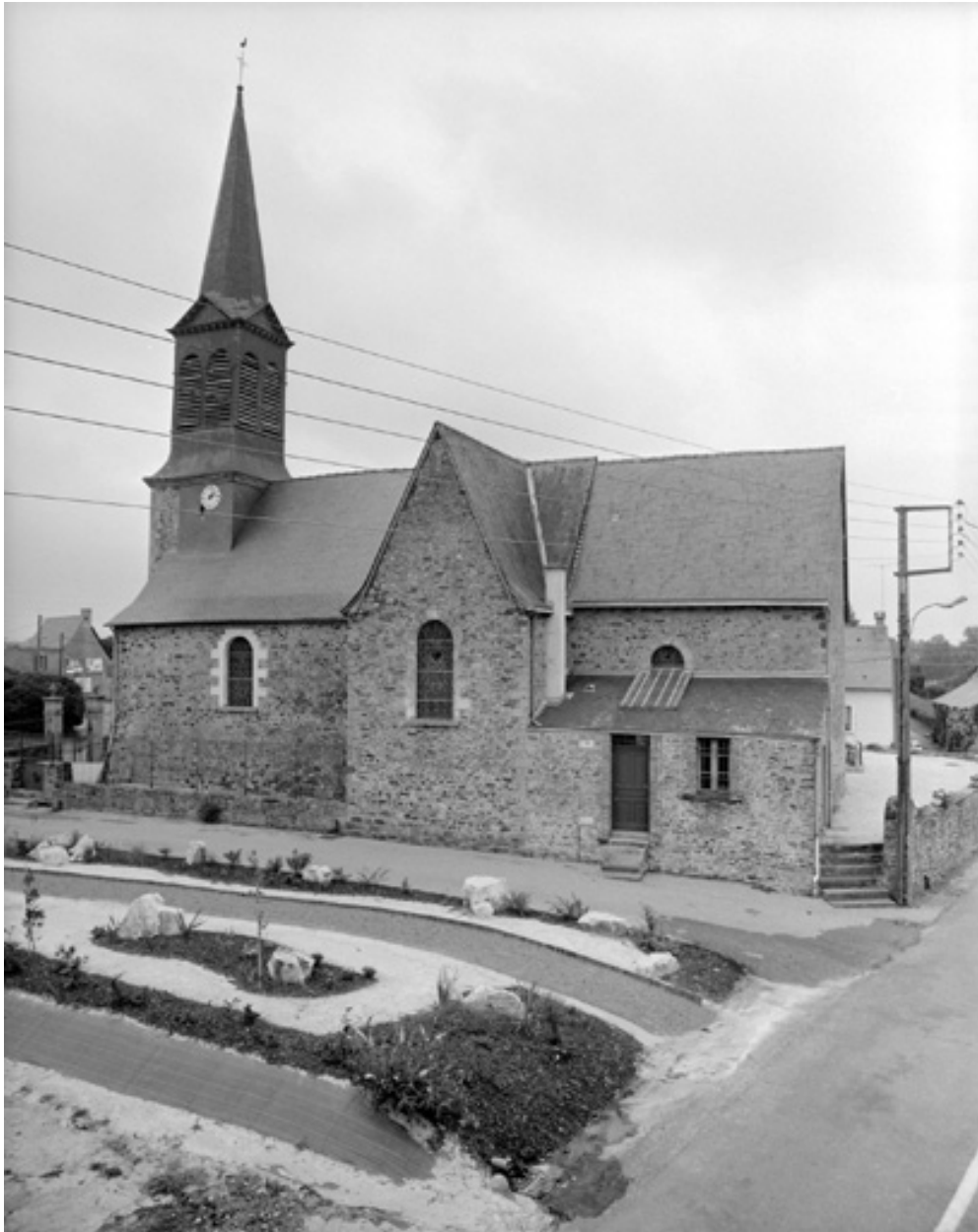
Élévation sud : vue générale
