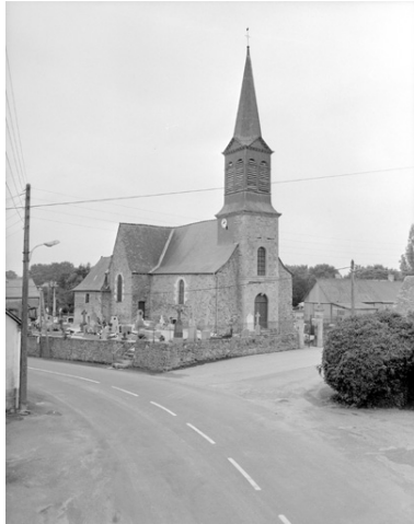
Élévation nord-ouest : vue générale Phot. Guy Artur, Phot. Norbert Lambart IVR53_19943501504X
