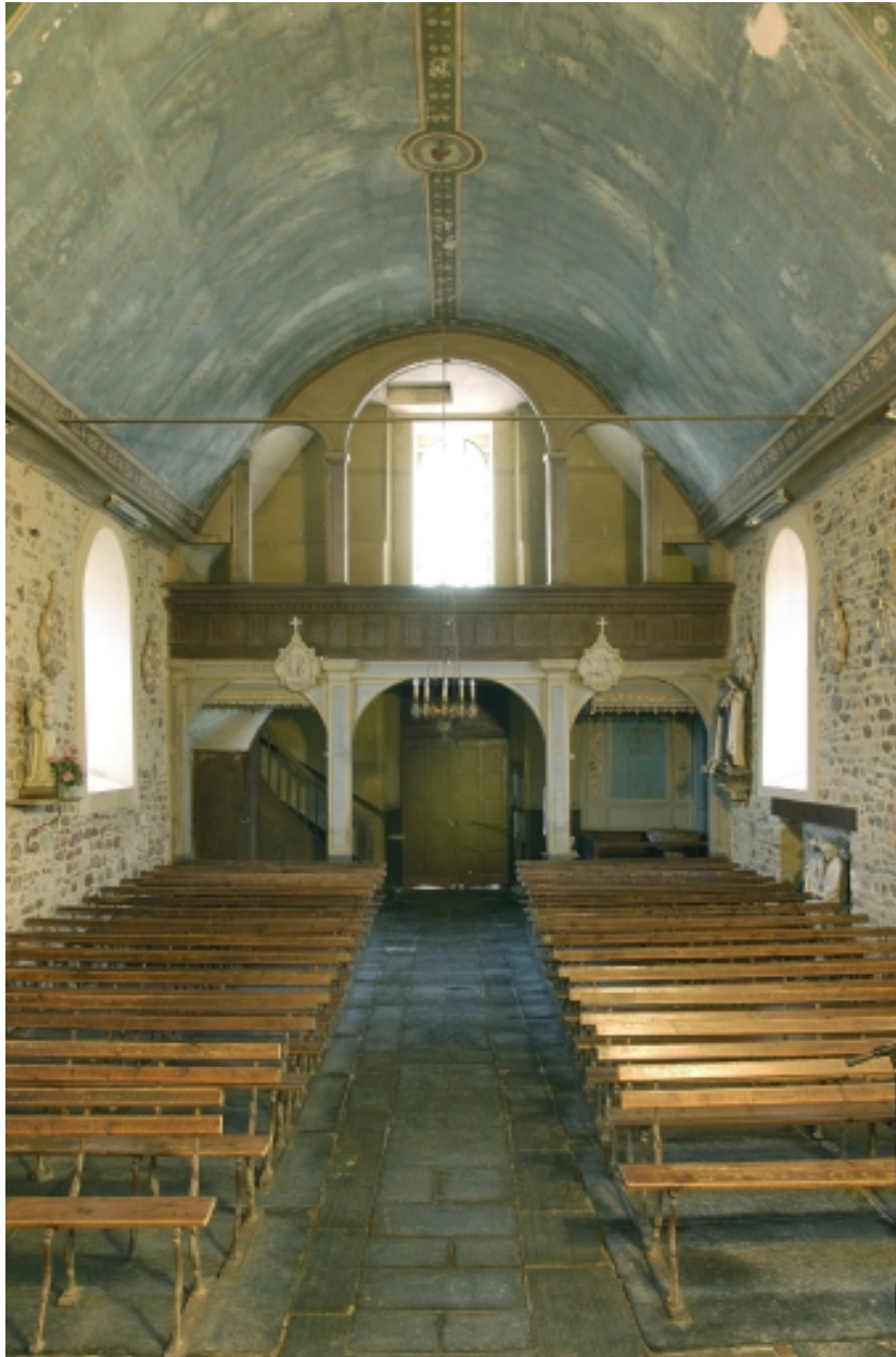
Vue intérieure prise du chœur vers la nef
