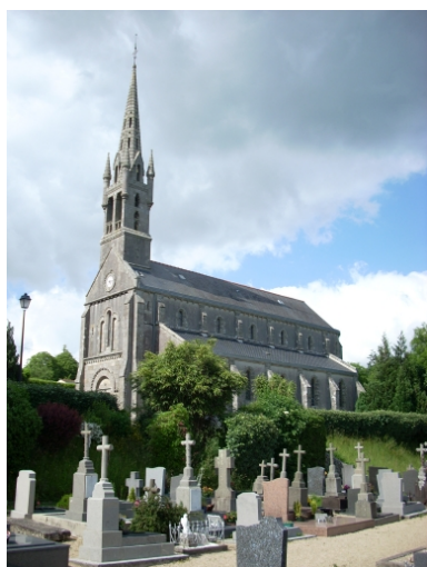
Eglise paroissiale Saint-Thénéan : vue générale sud-ouest Phot. Gwénaél Fauchille IVR53_20082906054NUCA
