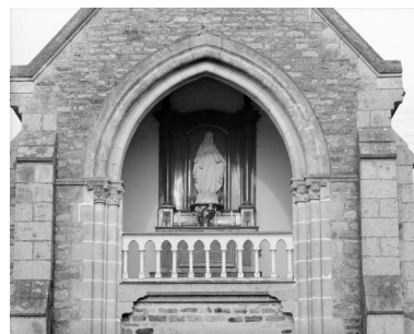
Elévation ouest, détail de la tribune Phot. Guy Artur, Phot. Norbert Lambart IVR53_19933500125X
