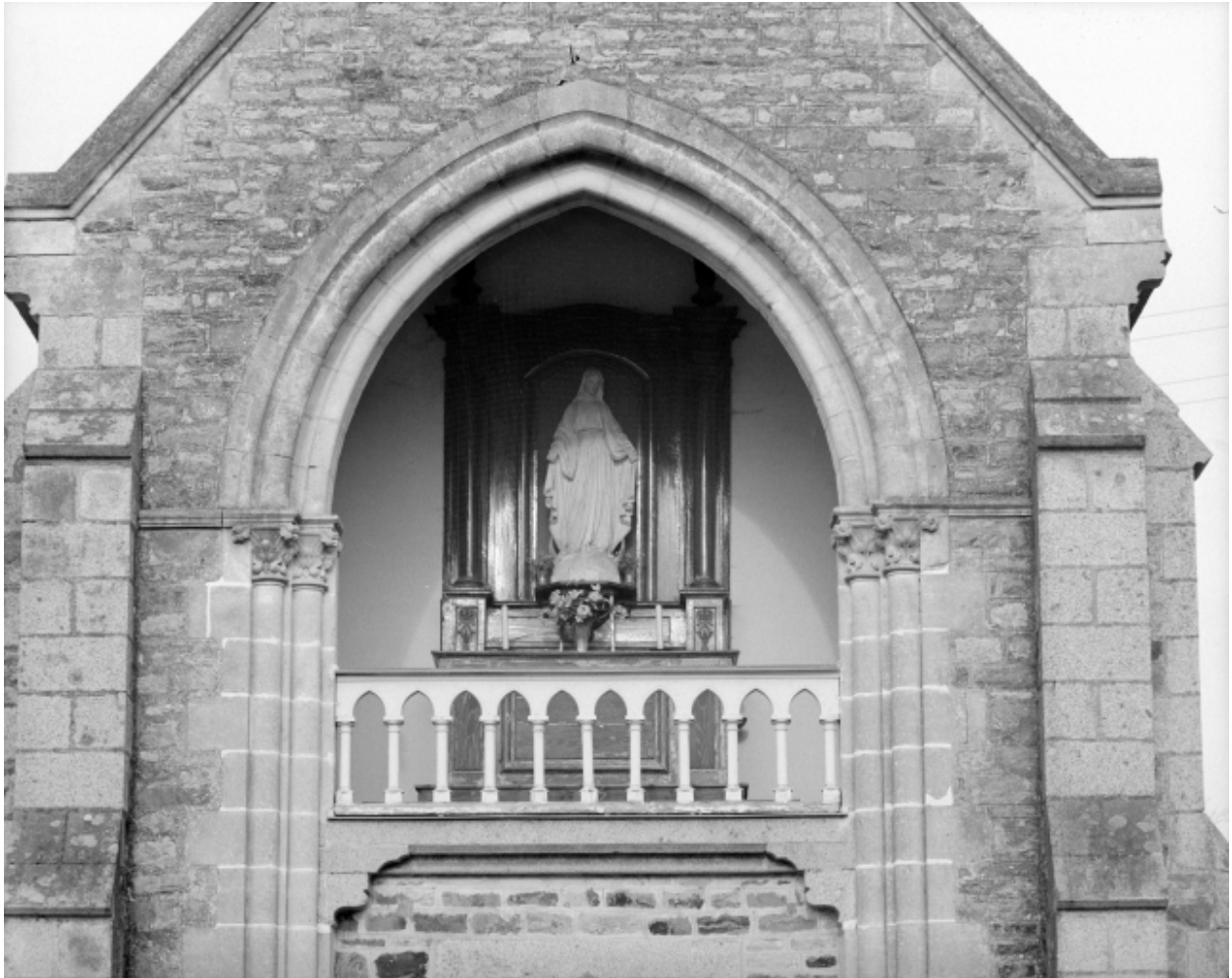
Elévation ouest, détail de la tribune
