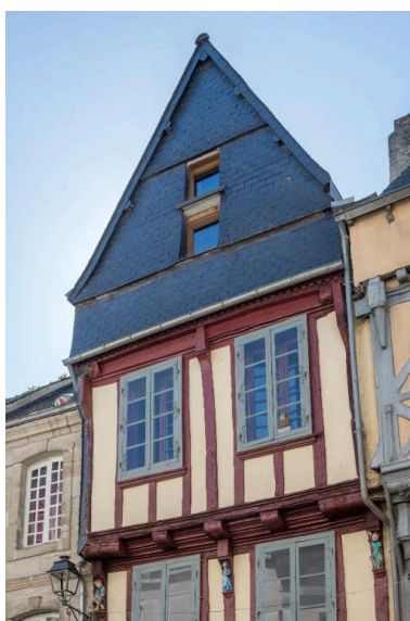
Deuxième étage contreventé en grille et pignon essenté d'ardoises. Phot. Charlotte Barraud IVR53_20252900726NUCA
