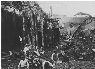
Vue de l'arsenal de Brest entre 1899 à 1902 : travaux d'agrandissement des formes de construction, bassins de radoub de Pontaniou dits formes de Pontaniou. Passage de quatre petites formes à deux grandes Repro. Archives municipales et communautaires. Brest Métropole Océane, Phot. Guillaume (retouche) Lécueillier, Autr. Auteur inconnu IVR53_20082908767NUC
