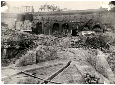
Vue de l'arsenal de Brest entre 1899 à 1902 : travaux d'agrandissement des formes de construction, bassins de radoub de Pontaniou dits formes de Pontaniou. Passage de quatre petites formes à deux grandes Repro. Archives municipales et communautaires. Brest Métropole Océane, Phot. Guillaume (retouche) Lécueillier, Autr. Auteur inconnu IVR53_20082908764NUC
