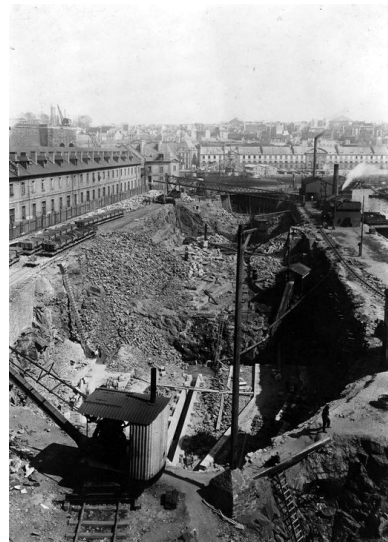
Vue de l'arsenal de Brest entre 1899 à 1902 : travaux d'agrandissement des formes de construction, bassins de radoub de Pontaniou dits formes de Pontaniou. Passage de quatre petites formes à deux grandes Repro. Archives municipales et communautaires. Brest Métropole Océane, Phot. Guillaume (retouche) Lécueillier, Autr. Auteur inconnu IVR53_20082908766NUC
