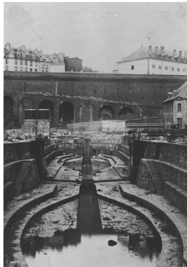
Vue de l'arsenal de Brest entre 1899 à 1902 : travaux d'agrandissement des formes de construction, bassins de radoub de Pontaniou dits formes de Pontaniou. Passage de quatre petites formes à deux grandes Repro. Archives municipales et communautaires. Brest Métropole Océane, Phot. Guillaume (retouche) Lécueillier, Autr. Auteur inconnu IVR53_20082908765NUC
