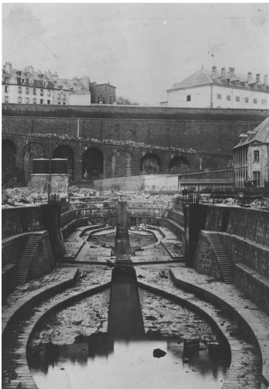
Vue de l'arsenal de Brest entre 1899 à 1902 : travaux d'agrandissement des formes de construction, bassins de radoub de Pontaniou dits formes de Pontaniou. Passage de quatre petites formes à deux grandes
