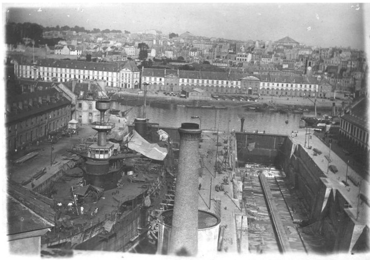
Vue de l'arsenal de Brest vers 1900 : formes de construction, bassins de radoub de Pontaniou dits formes de Pontaniou. Au deuxième plan sur l'autre rive de la Penfeld : le Magasin Général
