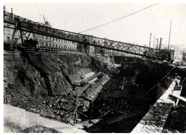
Vue de l'arsenal de Brest entre 1899 à 1902 : travaux d'agrandissement des formes de construction, bassins de radoub de Pontaniou dits formes de Pontaniou. Passage de quatre petites formes à deux grandes Repro. Archives municipales et communautaires. Brest Métropole Océane, Phot. Guillaume (retouche) Lécueillier, Autr. Auteur inconnu IVR53_20082908768NUC
