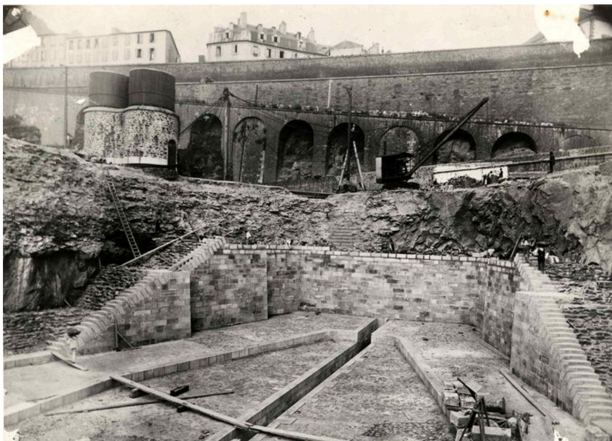
Vue de l'arsenal de Brest entre 1899 à 1902 : travaux d'agrandissement des formes de construction, bassins de radoub de Pontaniou dits formes de Pontaniou. Passage de quatre petites formes à deux grandes
