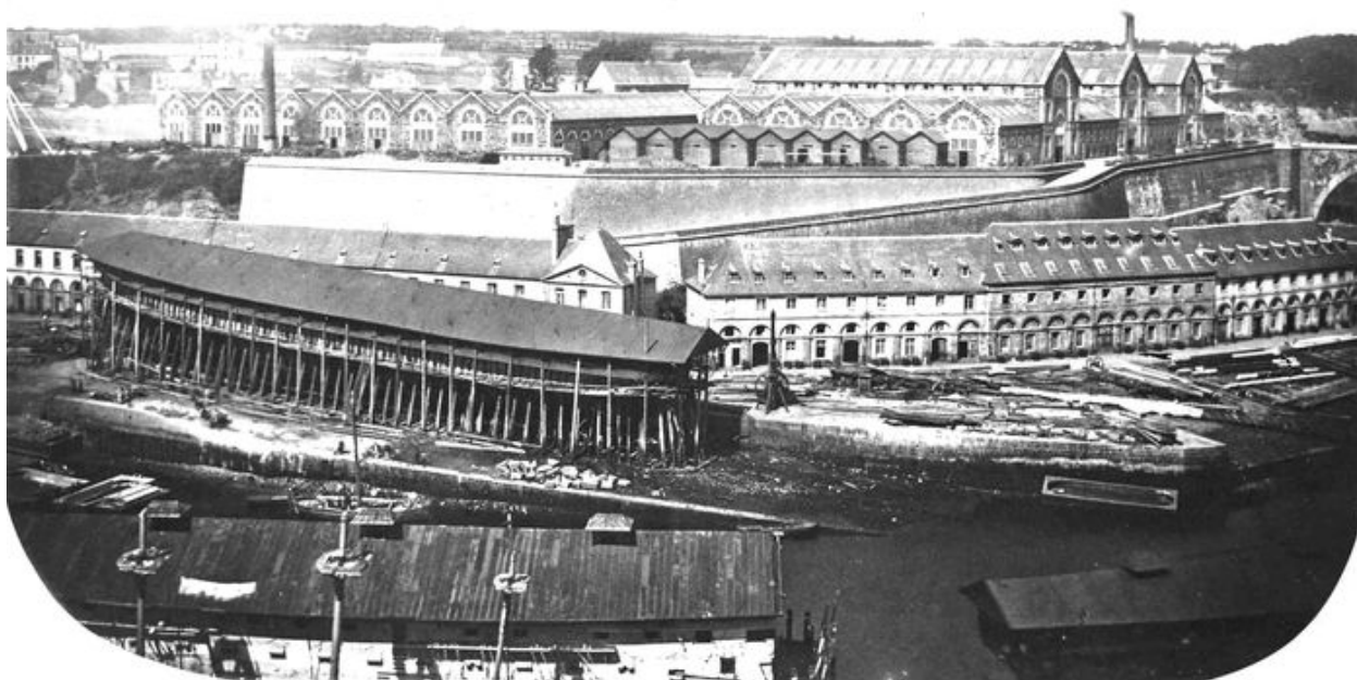
Vue de l'arsenal de Brest entre 1852-1870 : formes de construction, bassins de radoub de Pontaniou dits formes de Pontaniou. Au deuxième plan : les ateliers du plateau des Capucins
