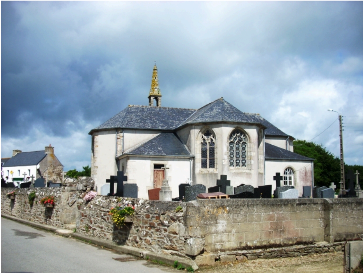
Saint-Derrien, église paroissiale Saint-Derrien : vue générale sud-est
