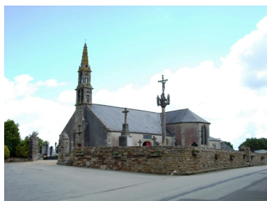
Saint-Derrien, église paroissiale Saint-Derrien : vue générale sud-ouest Phot. Gwénaél Fauchille IVR53_20082906468NUCA
