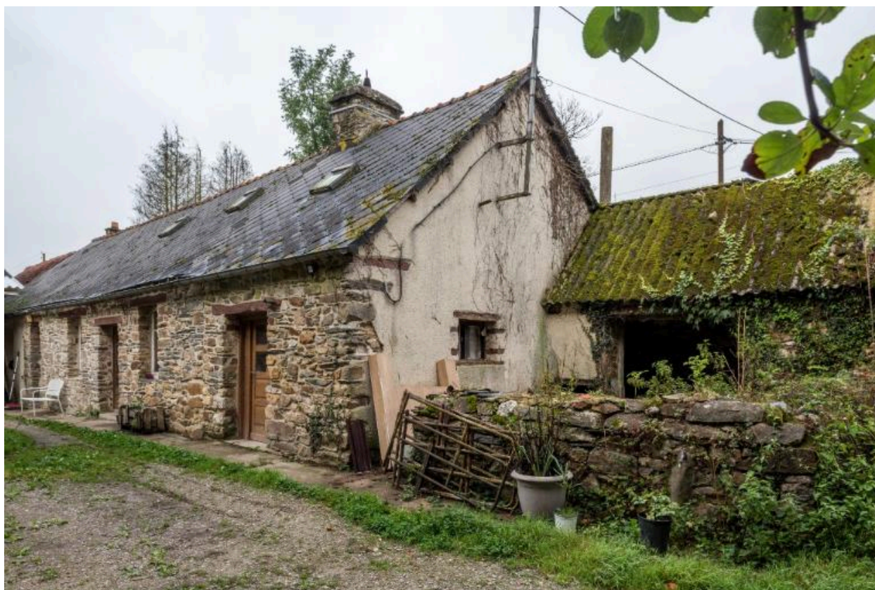
Maison de blanchisseurs, 18e siècle. Vue générale nord-est
