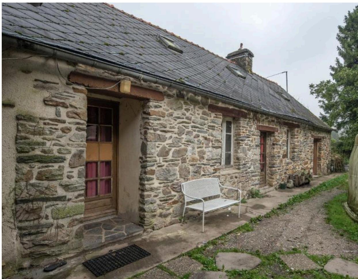
Maison de blanchisseurs, 18e siècle. Vue sud-est
