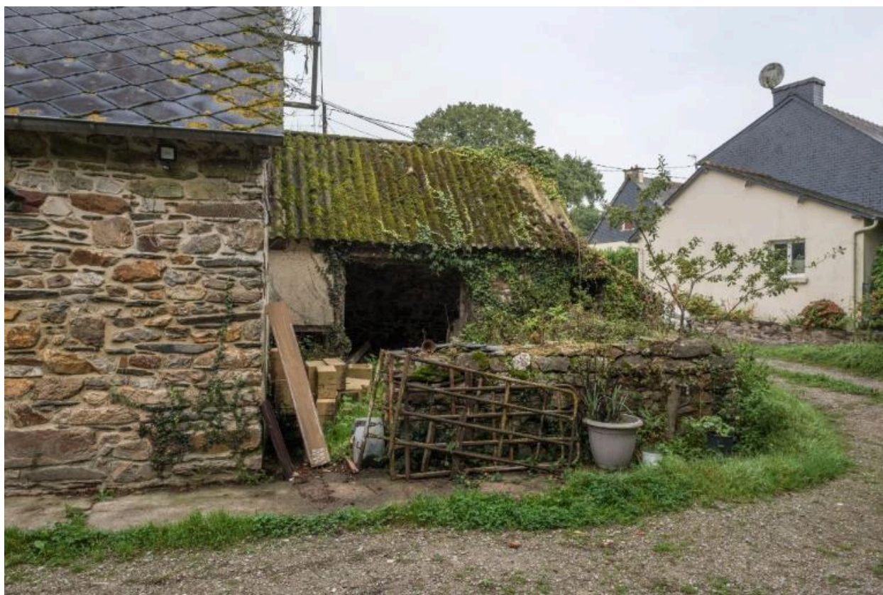
Soue à cochons et son enclos, 19e siècle, remaniée au 20e siècle. Vue est
