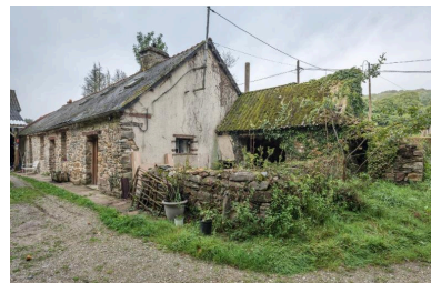
Maison de blanchisseurs, 18e siècle et soue à cochons avec son enclos, 19e siècle. Vue nord-est Phot. Barraud Charlotte IVR53_20232200984NUCA
