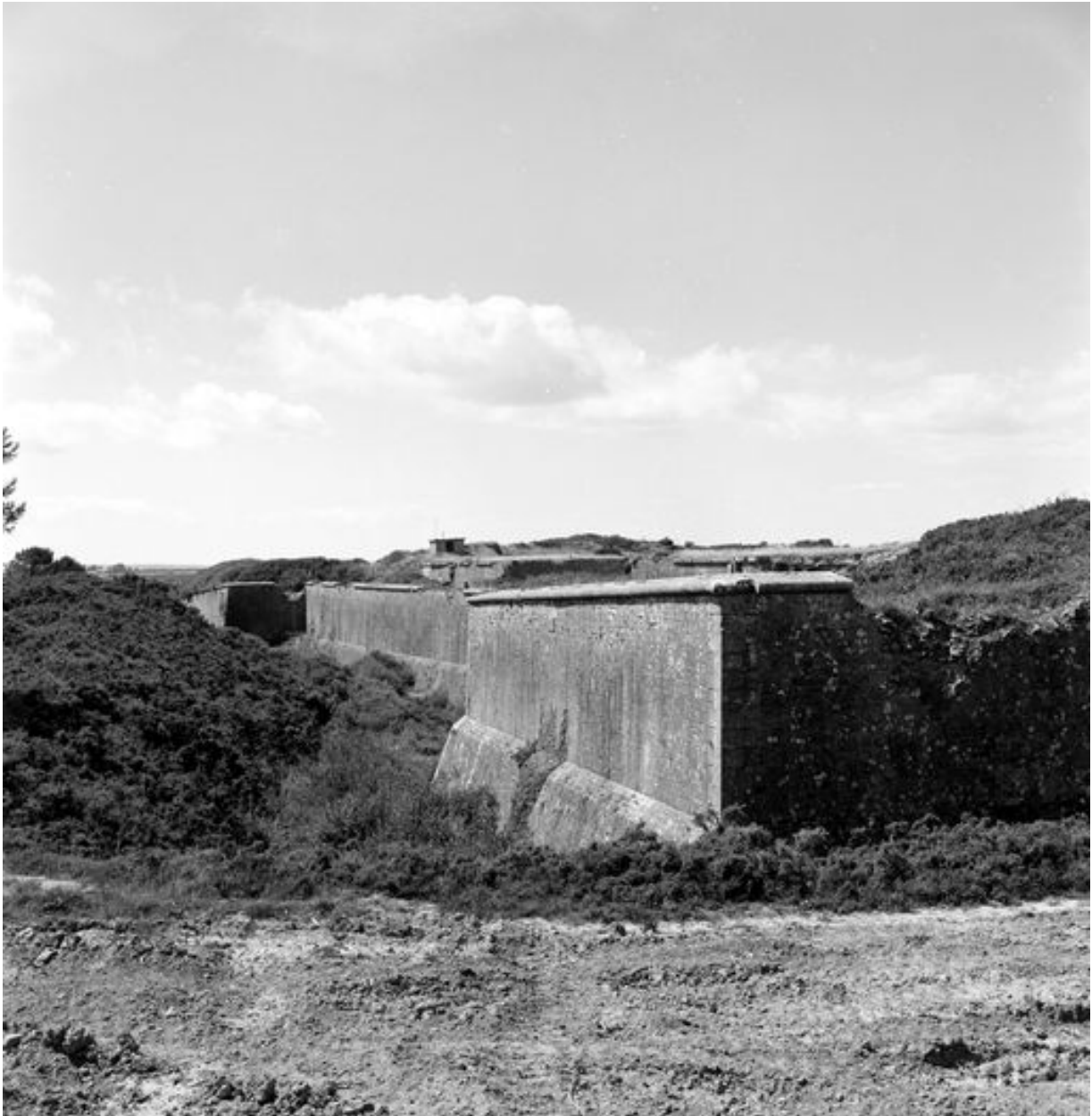
Vue du réduit de Quéléren en 1969 : front sud-ouest. Au premier plan : le bastion 101. Arrière plan : le bastion 104
