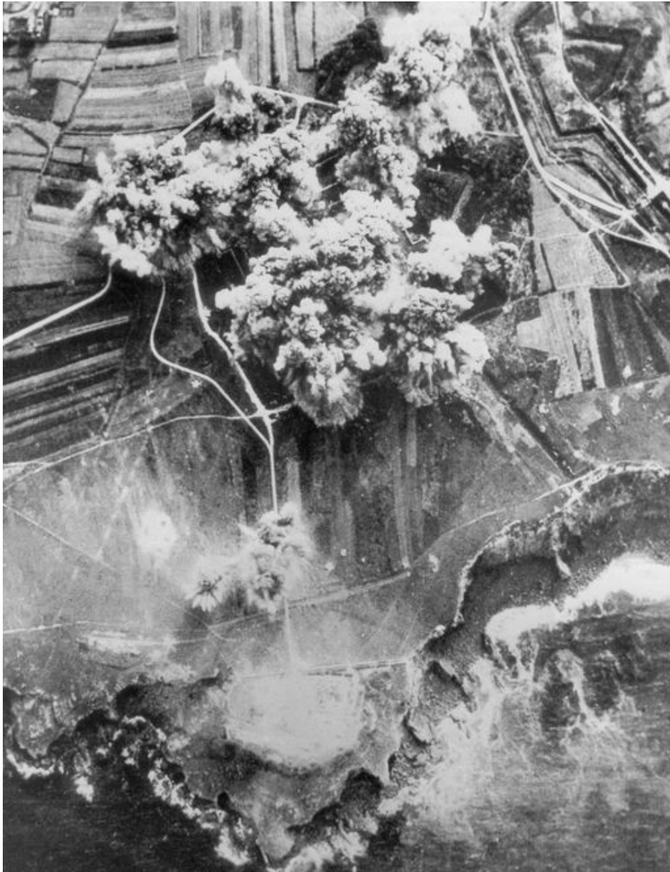
Vue aérienne verticale des bombardements du réduit de Quéléren, 3 septembre 1944
