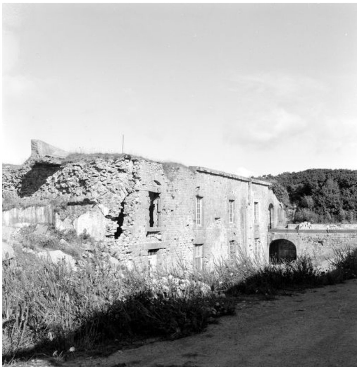
Vue du réduit de Quéléren en 1969 : caserne casematée depuis le nord
