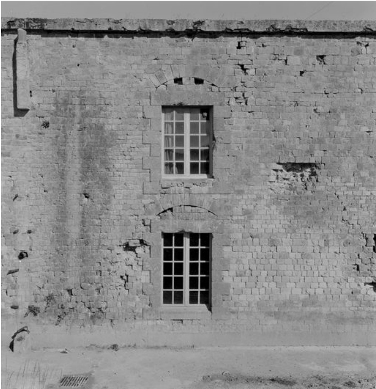
Vue du réduit de Quéléren en 1969 : détail de la façade de la caserne casematée. Baies encadrées de pierres de taille et arcs de décharge
