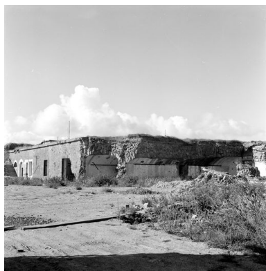
Vue du réduit de Quéléren en 1969 : extrémité sud de la caserne casematée en partie détruite par les bombardements de 1944. Au premier plan : deux casemates éventrées Phot. Guy Artur IVR53_19692900168X
