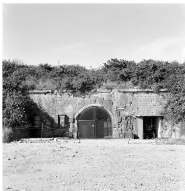
Vue du réduit de Quéléren en 1969 : passage couvert du front nord depuis l'intérieur de la cour Phot. Guy Artur IVR53_19692900163X
