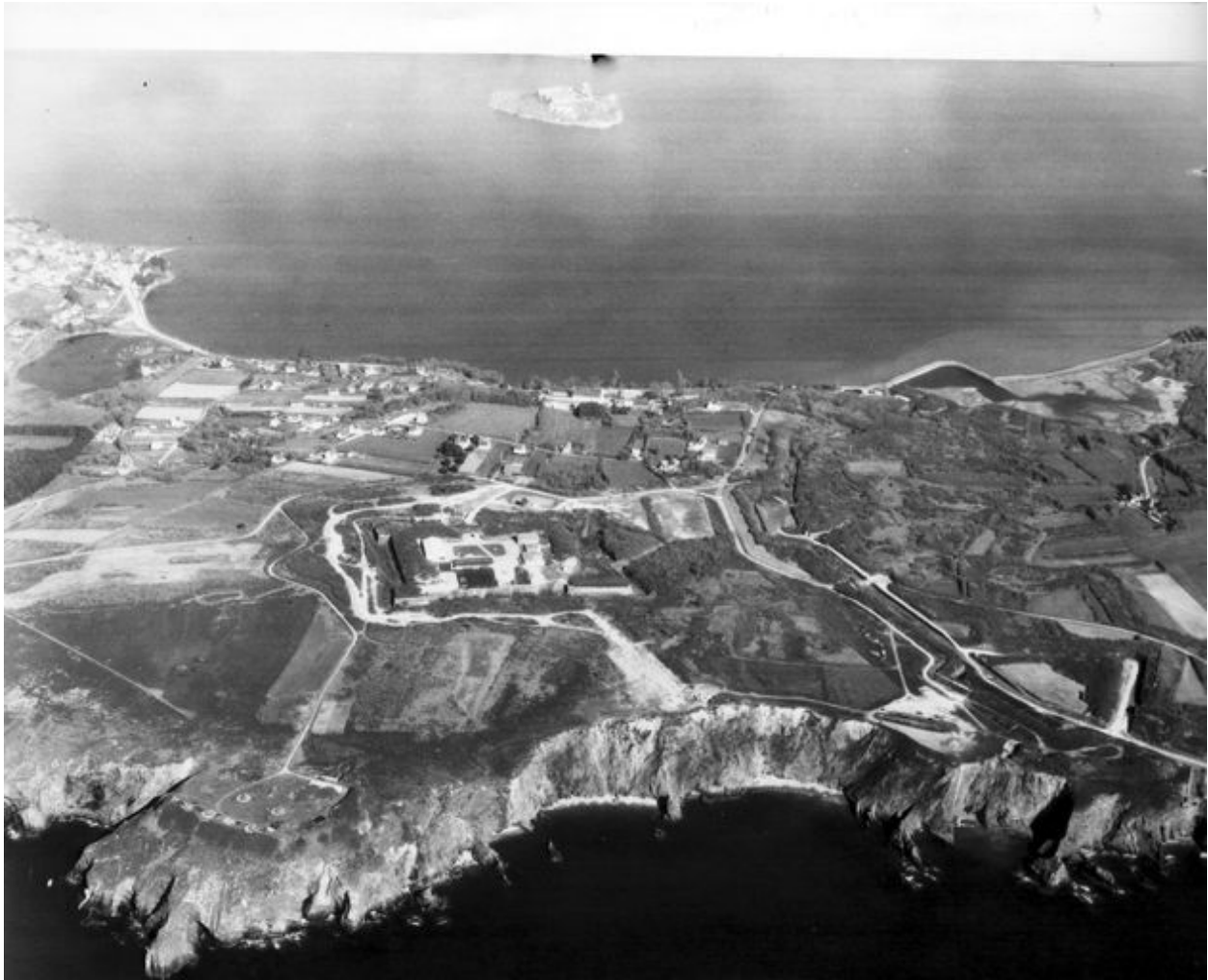
Vue aérienne générale des fortifications de Quéléren : batteries, réduit, lignes de Quéléren
