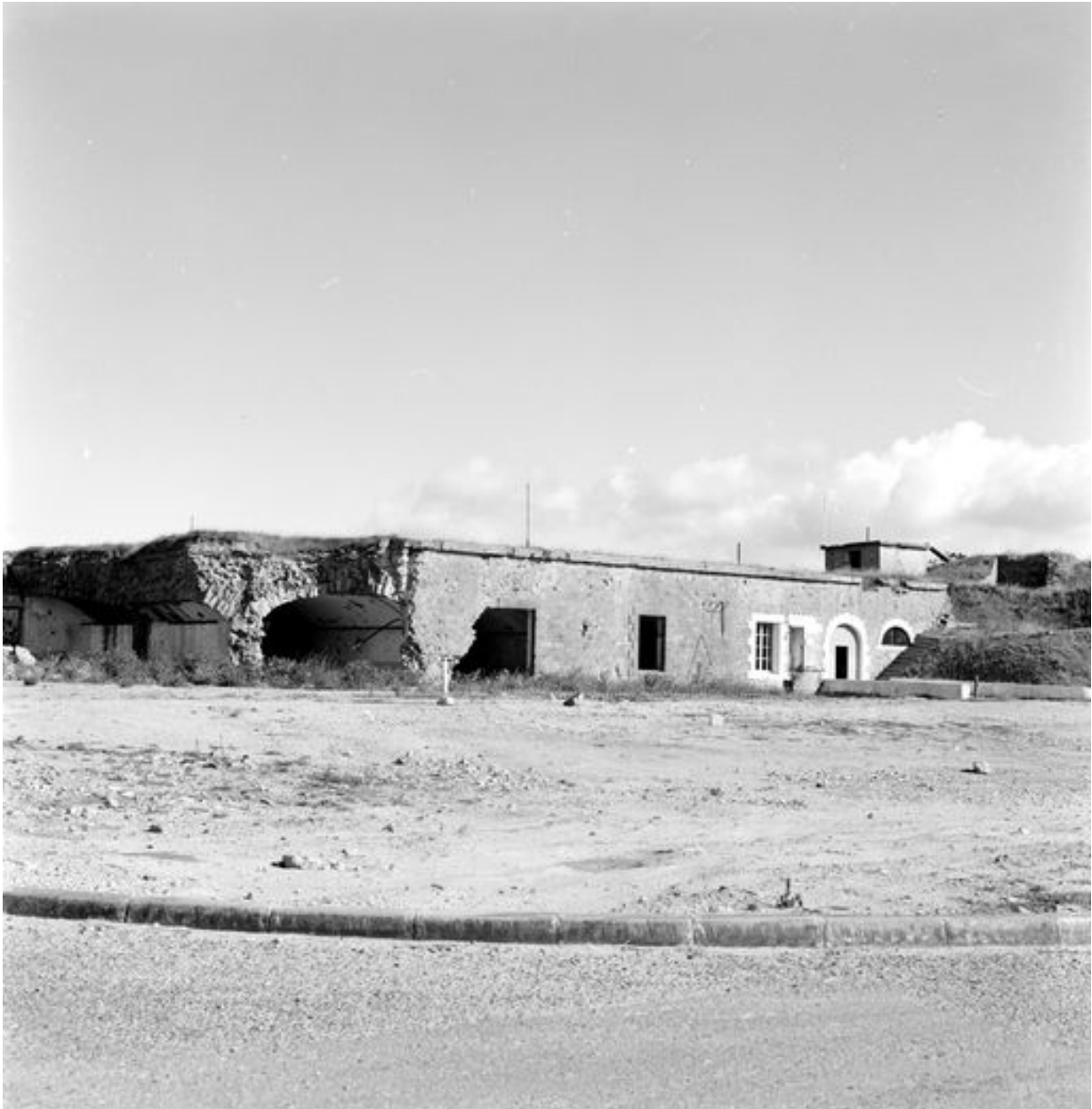
Vue du réduit de Quéléren en 1969 : extrémité nord de la caserne casematée en partie détruite par les bombardements de 1944
