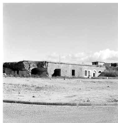
Vue du réduit de Quéléren en 1969 : extrémité nord de la caserne casematée en partie détruite par les bombardements de 1944 Phot. Guy Artur IVR53_19692900165X
