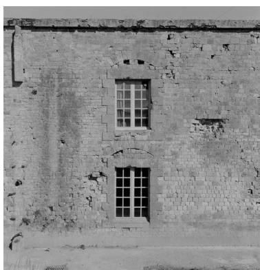
Vue du réduit de Quéléren en 1969 : détail de la façade de la caserne casematée. Baies encadrées de pierres de taille et arcs de décharge Phot. Guy Artur IVR53_19692900169X
