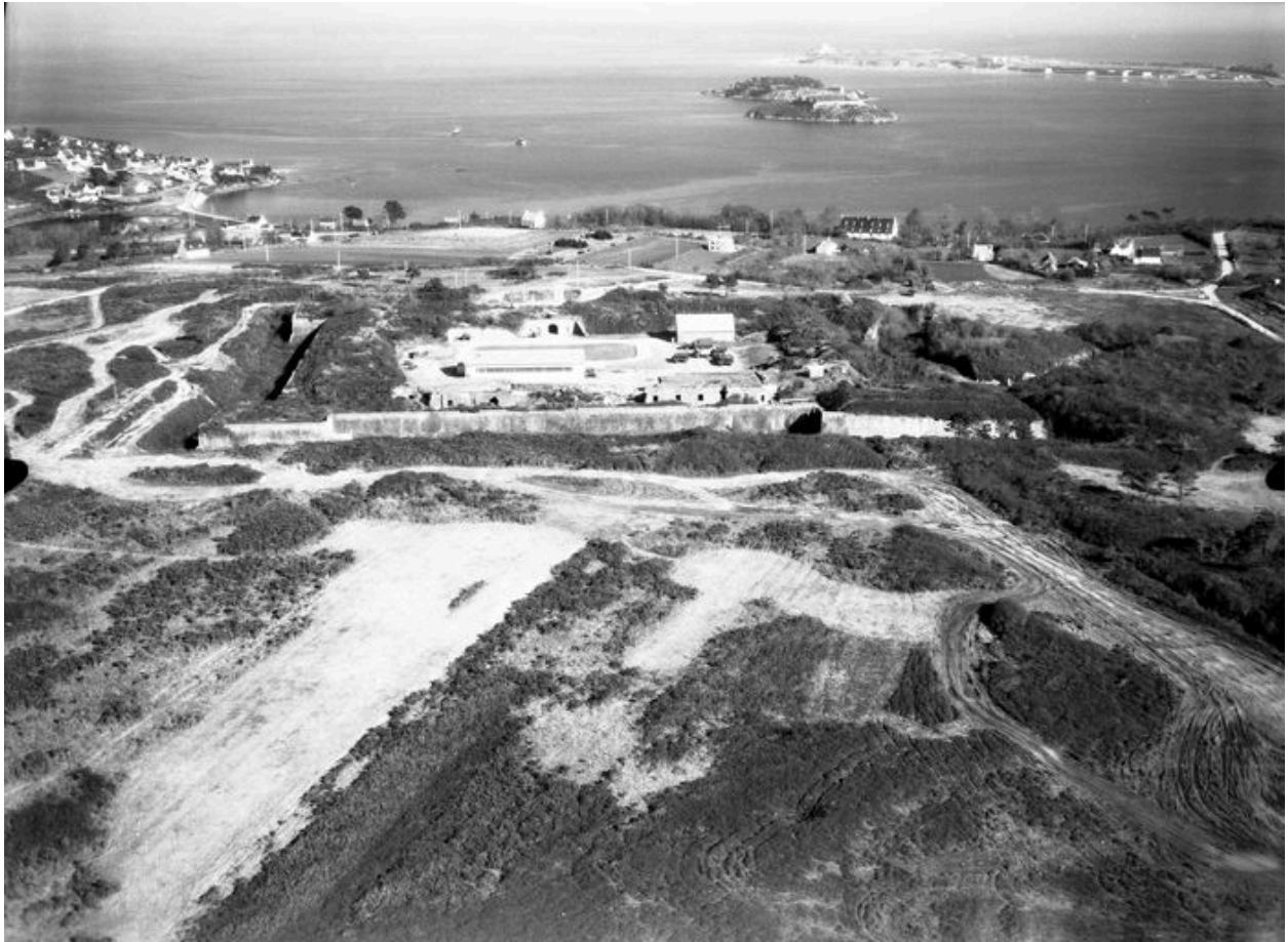
Vue aérienne du réduit de Quéléren en 1971 prise dans l'alignement des anciennes lignes de Vauban. En arrière-plan : la caserne Sourdès
