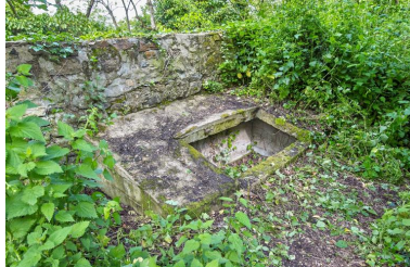
Vue générale. La niche à munitions est adossée au parapet du mur ceinturant le Domaine de Cesson. Elle était vraisemblablement fermée par un battant vertical dont subsistent les gonds Phot. Bernard Bègne IVR53_20232200310NUCA
