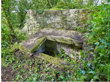
Vue générale. La niche à munitions est adossée au parapet du mur ceinturant le Domaine de Cesson. Elle était vraisemblablement fermée par un battant vertical dont subsistent les gonds Phot. Bernard Bègne IVR53_20232200309NUCA
