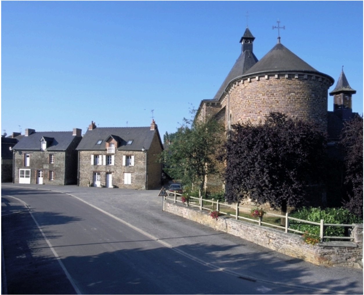
Vue de situation nord-est
