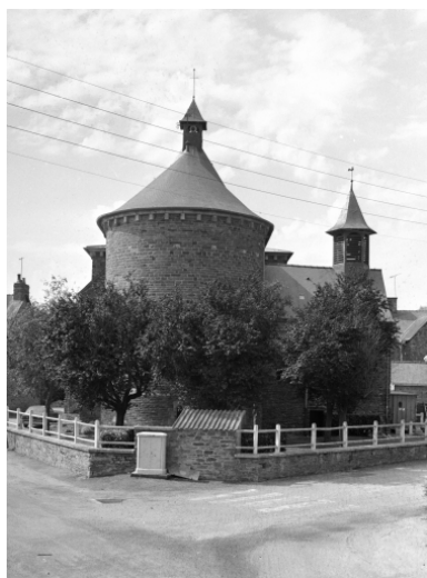
Elévation Nord : vue générale Phot. Guy Artur, Phot. Norbert Lambart IVR53_19943501764X
