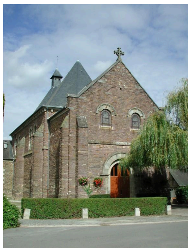
Elévation sud de l'église paroissiale Saint-André (Lohéac) Phot. Claude Quillivic IVR53_20003512277NUCA
