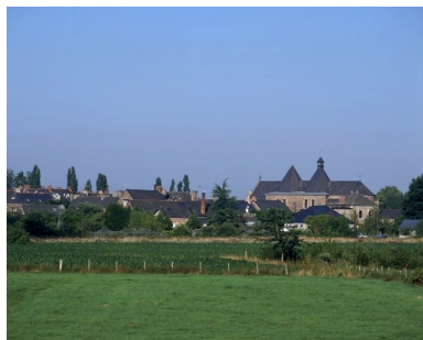
Vue de situation depuis le nord-est Phot. Guy Artur, Phot. Norbert Lambart IVR53_20003501850XA
