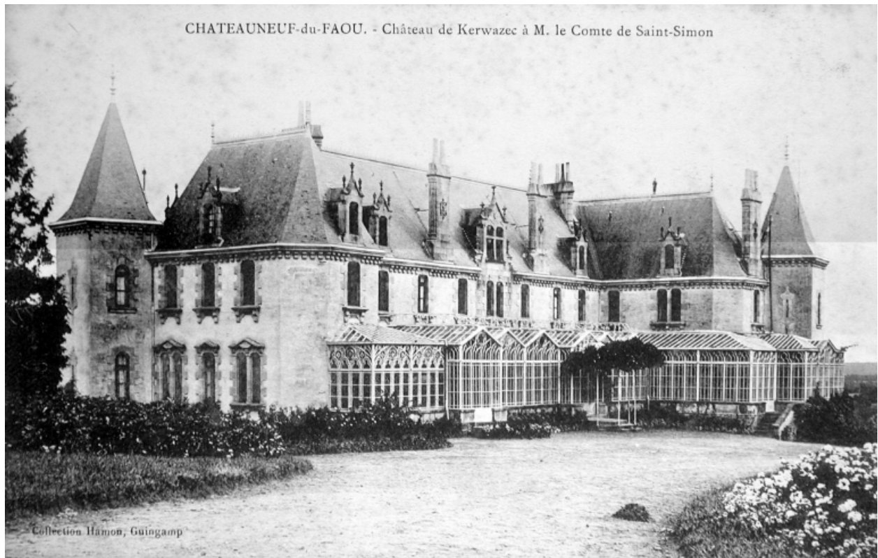
Vue de trois-quart sur la façade sur jardin (Archives départementales d'Ille-et-Vilaine, 6 Fi Saint-Goazec)
