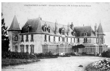
Vue de trois-quart sur la façade sur jardin (Archives départementales d'Ille-et-Vilaine, 6 Fi Saint-Goazec) Phot. Elise Lauranceau IVR53_20042905598NUCB
