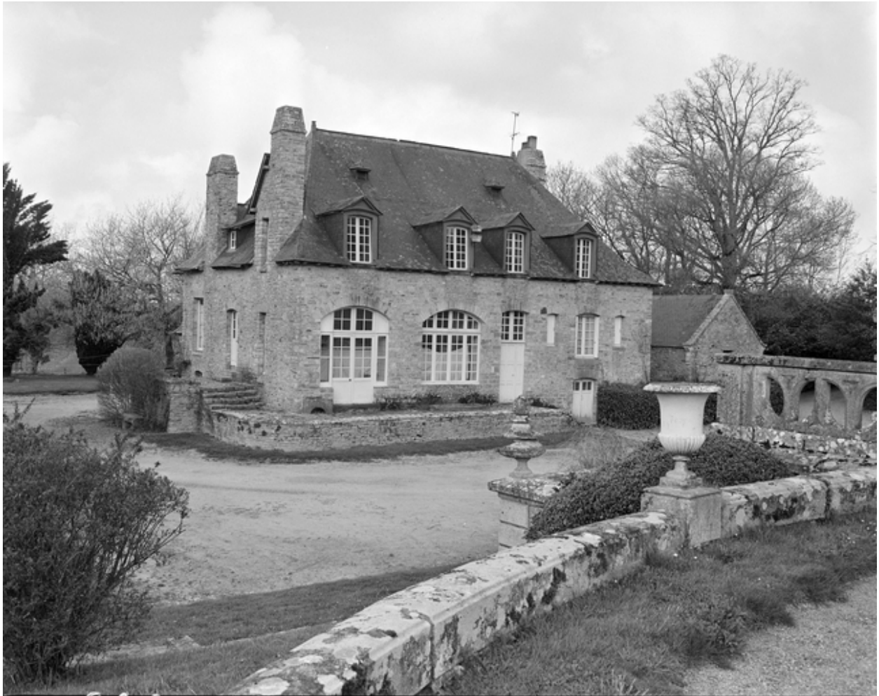
Vue générale de l'orangerie.
