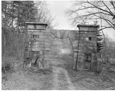
Dans le parc, remploi de la porte de l'ancienne prison Richelot à Rennes. Phot. Guy Artur, Phot. Norbert Lambart IVR53_19963500833X
