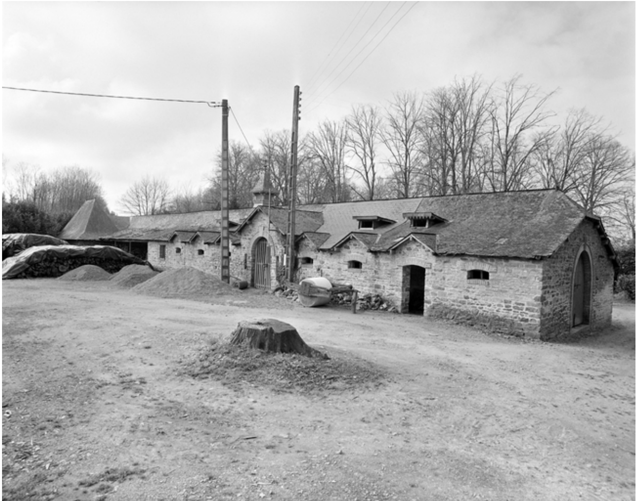
Vue générale des anciennes écuries.
