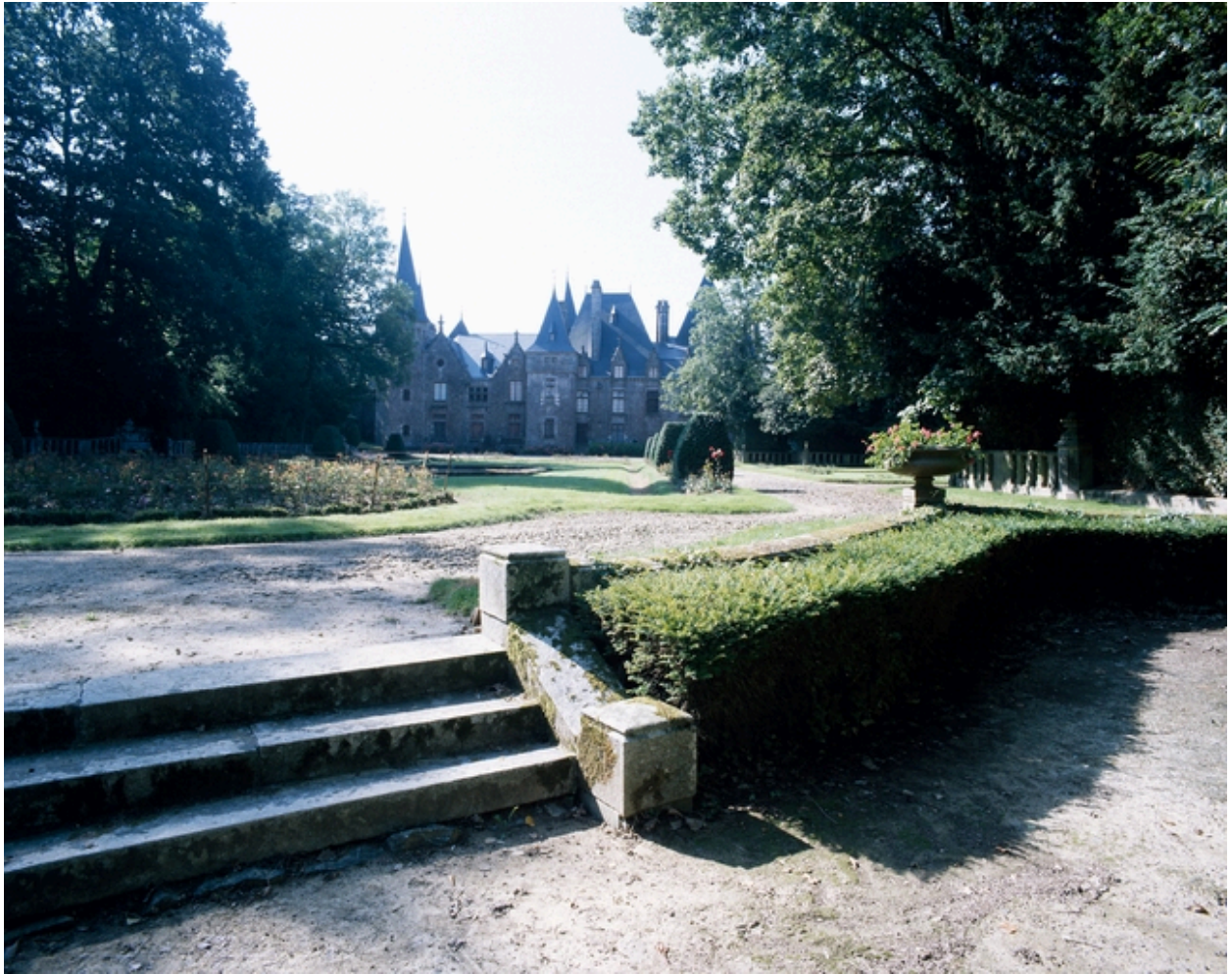
Elévation nord, vue éloignée.
