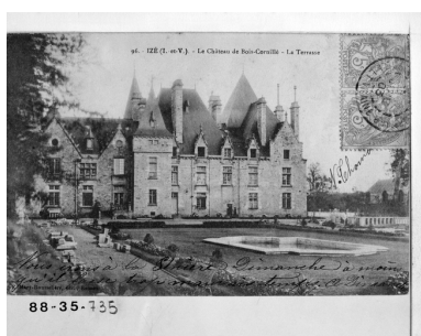
Fonds Lagrée - Carte postale ancienne - 96 - Izé (I.-et-V.) - Le château de Bois Cornillé - La terrasse. Phot. Guy Artur, Phot. Norbert Lambert IVR53_19883500735X
