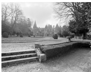
Elévation nord, vue éloignée. Phot. Guy Artur, Phot. Norbert Lambart IVR53_19963500819X
