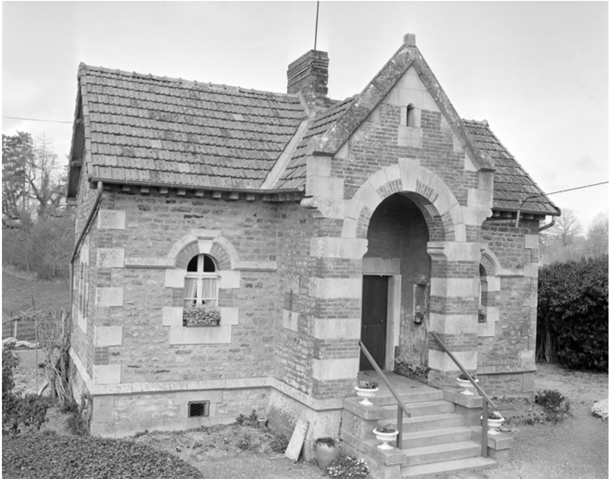
Conciergerie à l'intérieur du château, vue générale.
