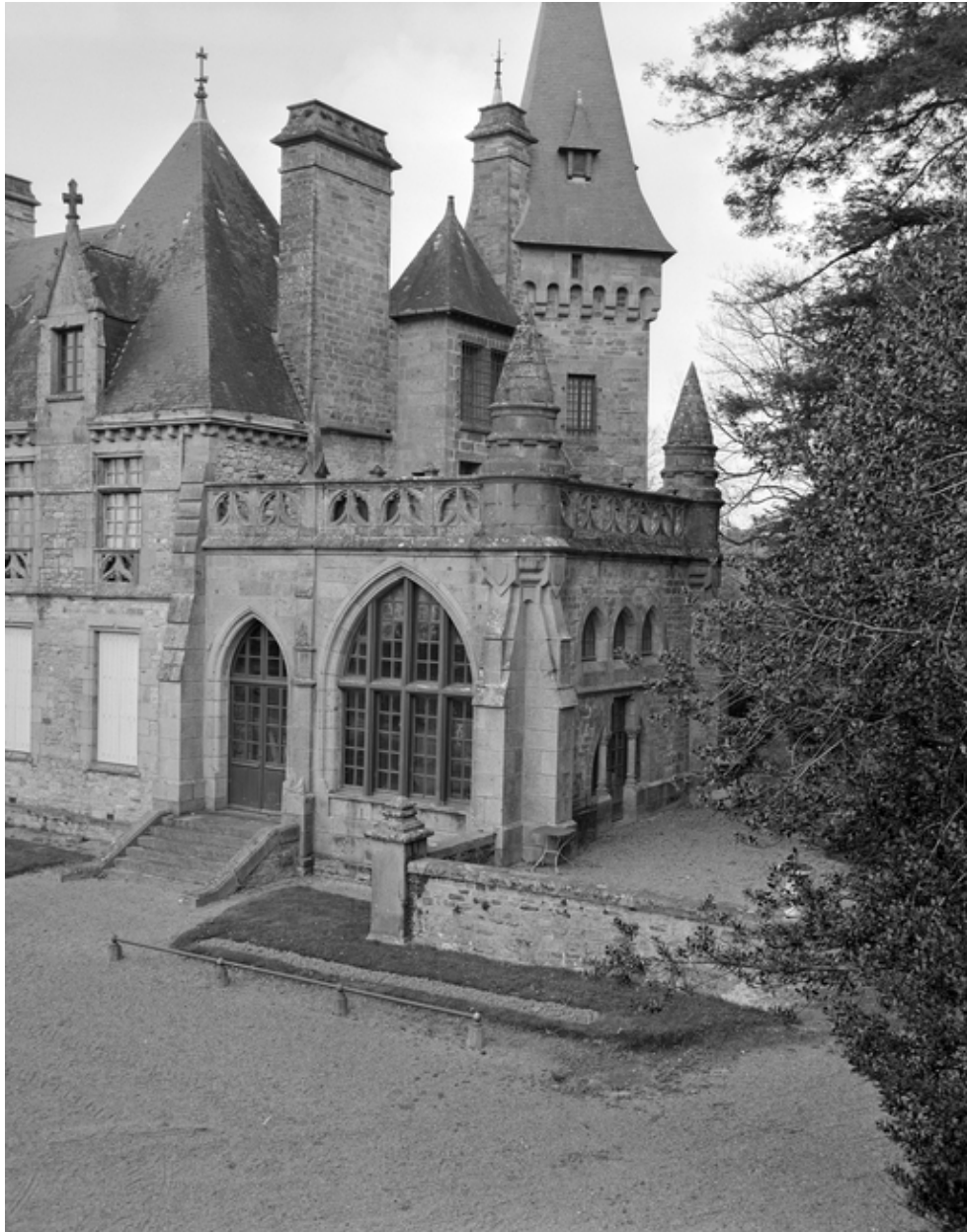
Angle sud-est du château : jardin d'hiver, vue générale.
