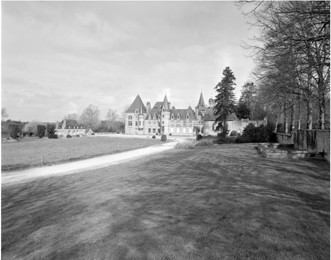
Vue de situation de l'ensemble du château avec la chapelle et l'orangerie.
