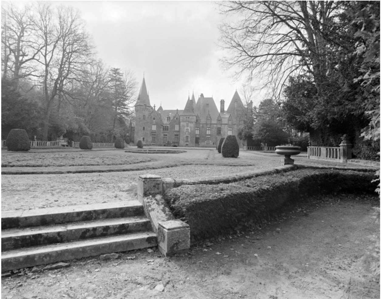
Elévation nord, vue éloignée.
