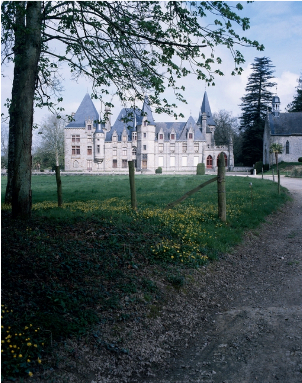
Vue générale du château.
