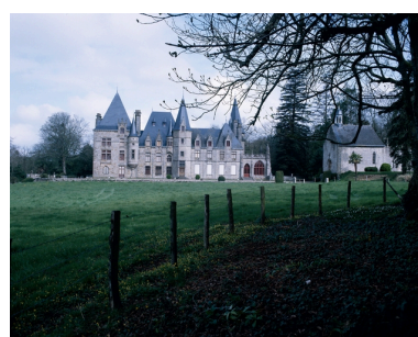
Vue générale du château. Phot. Service régional de l'Inventaire de Bretagne IVR53_19963500837XA
