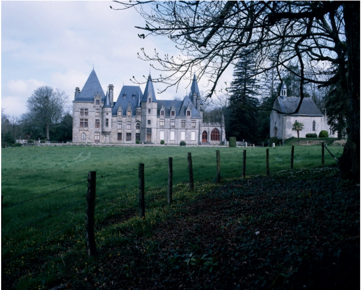
Vue générale du château.
