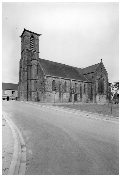
Vue générale du sud-ouest Phot. Guy Artur IVR53_19682201295V
