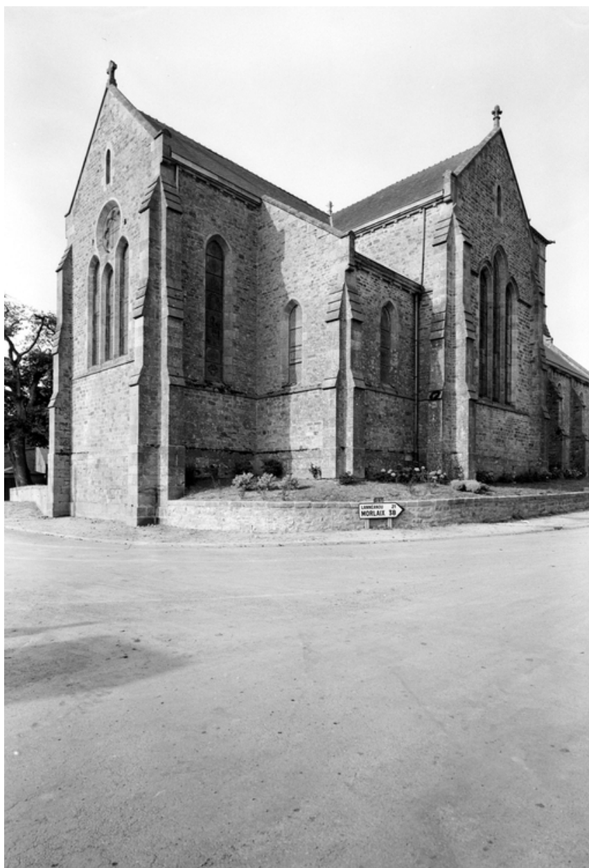
Vue générale de l'angle nord-est
