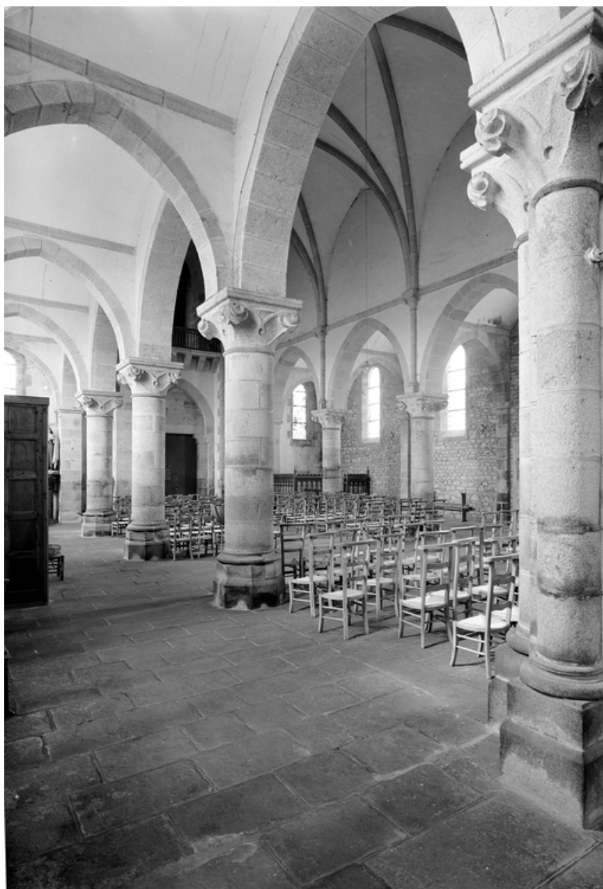
Vue transversale de la nef prise de l'angle sud est du bras sud
