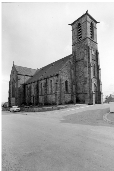
Vue générale de l'angle nord-ouest Phot. Guy Artur IVR53_19682201296V
