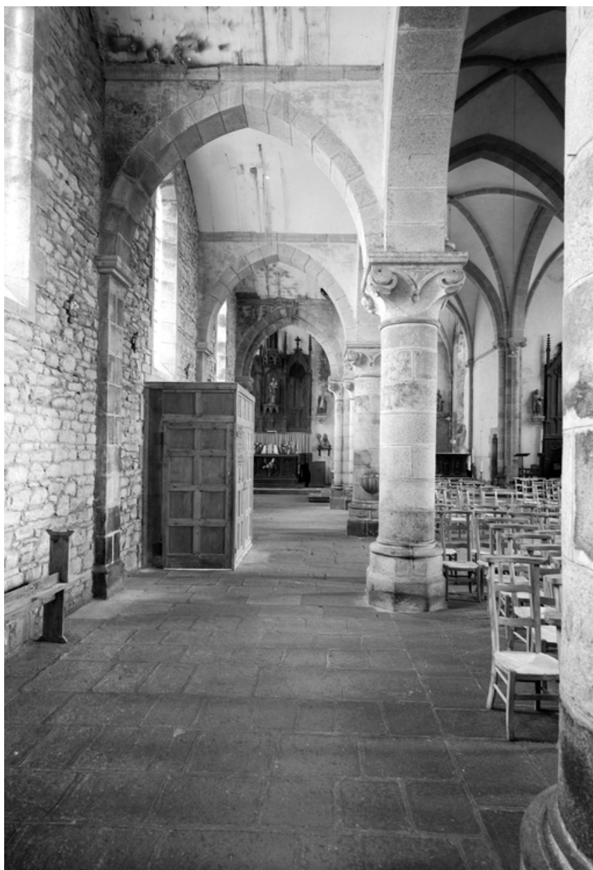
Vue axiale du bas-côté nord, d'ouest en est
