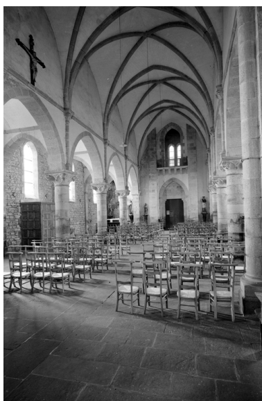
Vue générale de la nef Phot. Guy Artur IVR53_19682201246V
