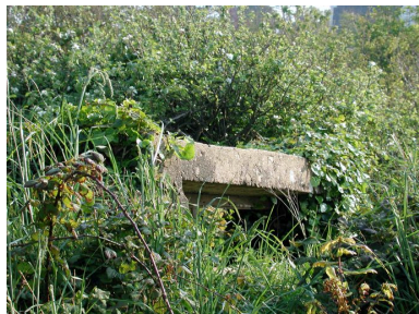
Vue générale (état en 2002) Phot. Guillaume Lécuillier IVR53_20022901910NUCA
