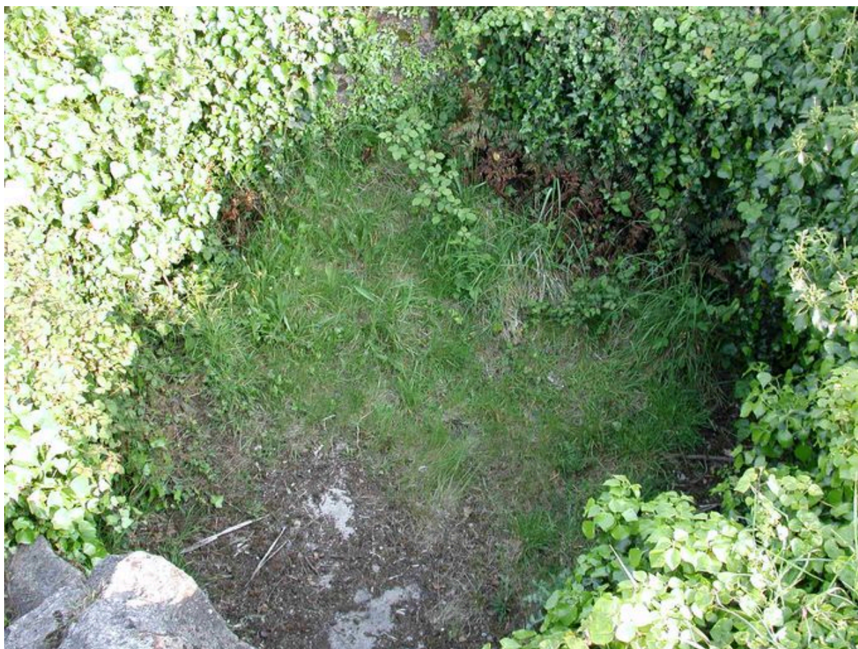
Vue générale de la cuve (état en 2002)
