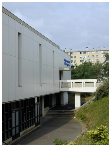
Vue de l'étage de soubassement Phot. Isabelle Barbedor IVR53_20003517840NUCA
