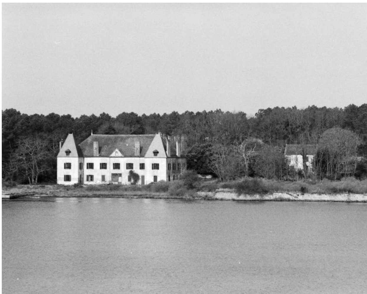
Vue de situation prise de l'est.
