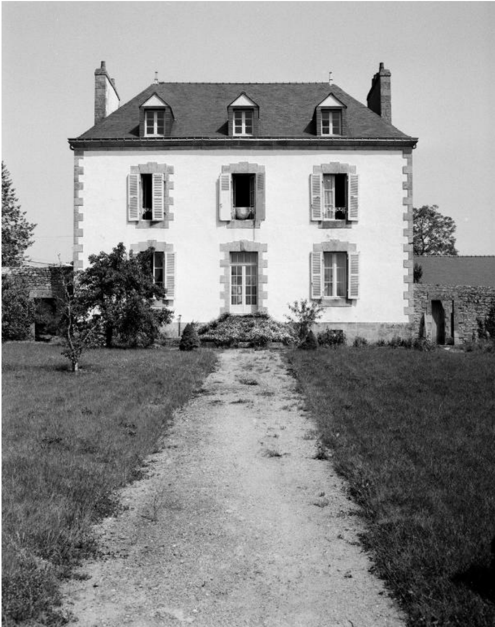
Vue de situation prise de l'est
