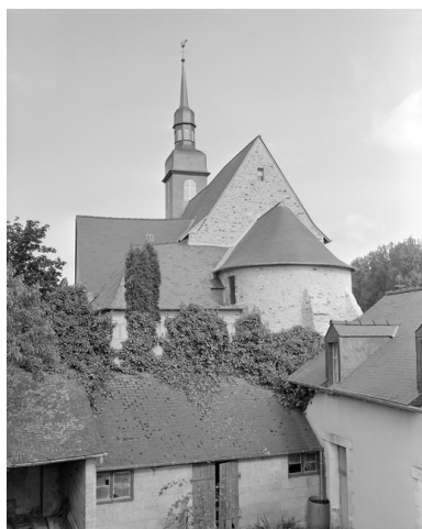
Elévation Sud-Est : vue générale Phot. Guy Artur, Phot. Norbert Lambart IVR53_19943501321X
