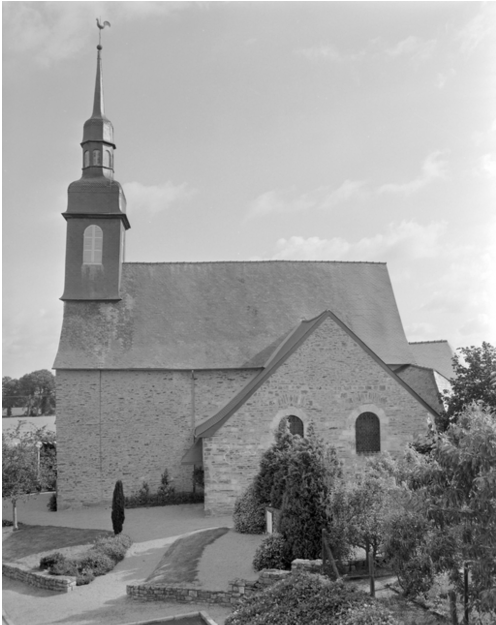
Elévation Sud : vue générale
