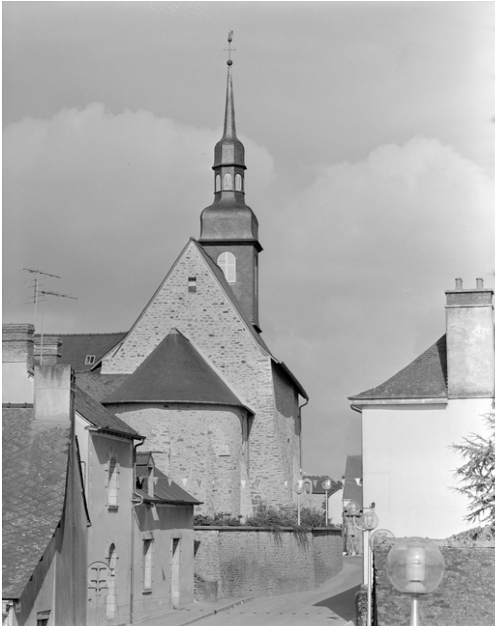
Elévation Est, partie Nord : vue générale
