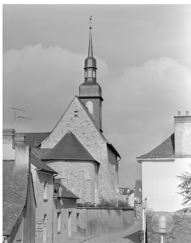
Elévation Est, partie Nord : vue générale Phot. Guy Artur, Phot. Norbert Lambart IVR53_19943501322X
