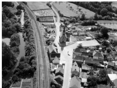
Vue aérienne de l'église. Phot. G.A.L.A.T. IVR53_19843500895V
