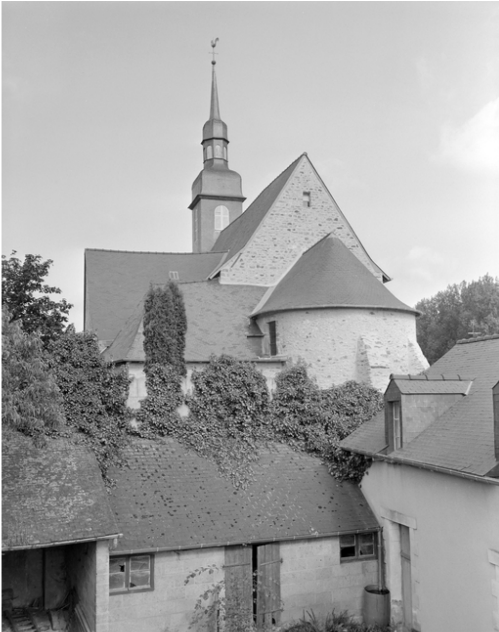
Elévation Sud-Est : vue générale
