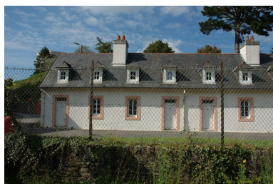
Vue du bâtiment Duplessis : élévation sud donnant sur la Penfeld (état en 2008) Phot. Guillaume Lécueillier IVR53_20082909773NUCA
