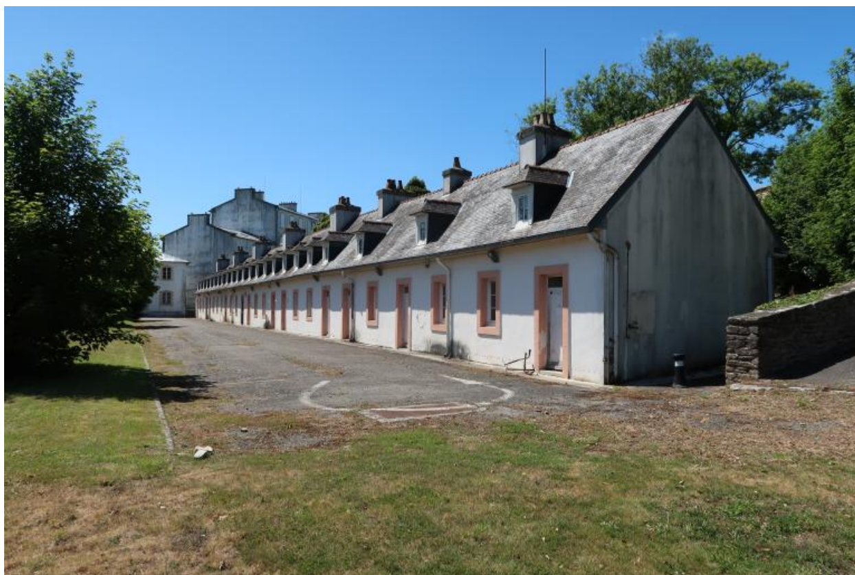
Vue générale du bâtiment Duplessis : élévation sud donnant sur la Penfeld (état en 2022)
