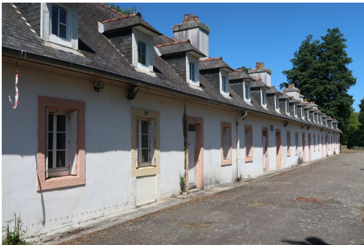
Vue du bâtiment Duplessis : élévation sud donnant sur la Penfeld (état en 2022)
