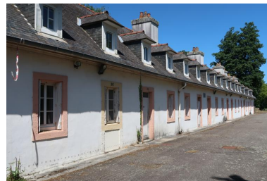
Vue du bâtiment Duplessis : élévation sud donnant sur la Penfeld (état en 2022) Phot. Guillaume Lécueillier IVR53_20222905415NUCA
