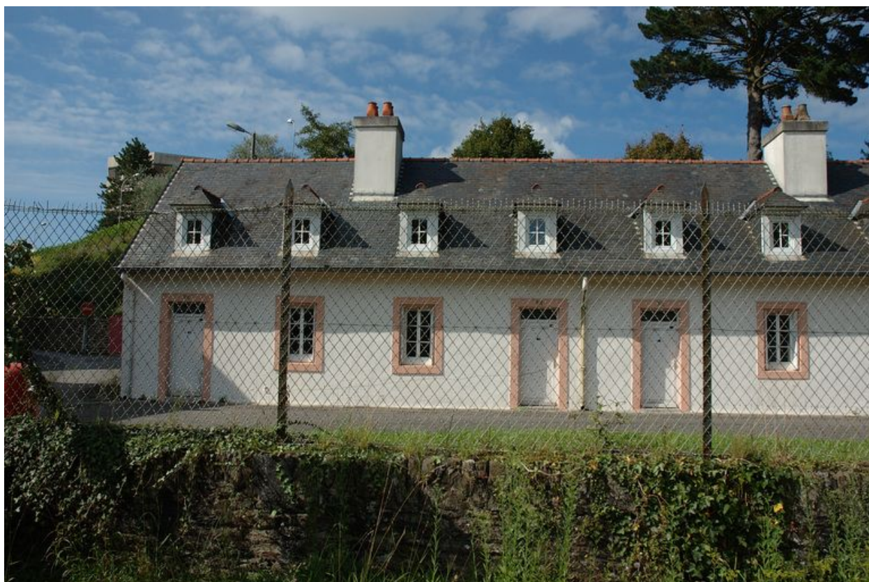
Vue du bâtiment Duplessis : élévation sud donnant sur la Penfeld (état en 2008)
