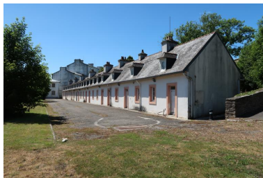
Vue générale du bâtiment Duplessis : élévation sud donnant sur la Penfeld (état en 2022) Phot. Guillaume Lécueillier IVR53_20222905416NUCA
