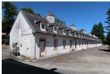
Vue générale du bâtiment Duplessis : élévation sud donnant sur la Penfeld (état en 2022) Phot. Guillaume Lécueillier IVR53_20222905414NUCA
