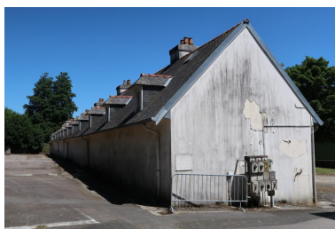
Vue du bâtiment Duplessis : pignon ouest (état en 2022) Phot. Guillaume Lécueillier IVR53_20222905417NUCA
