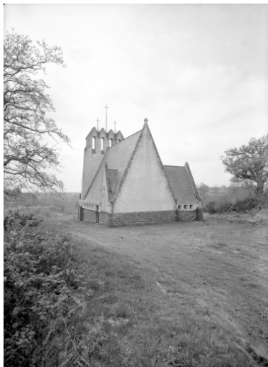
Elévation Est : vue générale Phot. Guy Artur IVR53_19683500403V
