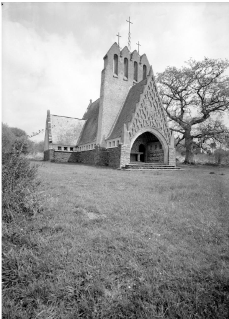
Elévation Nord-Ouest : vue générale
