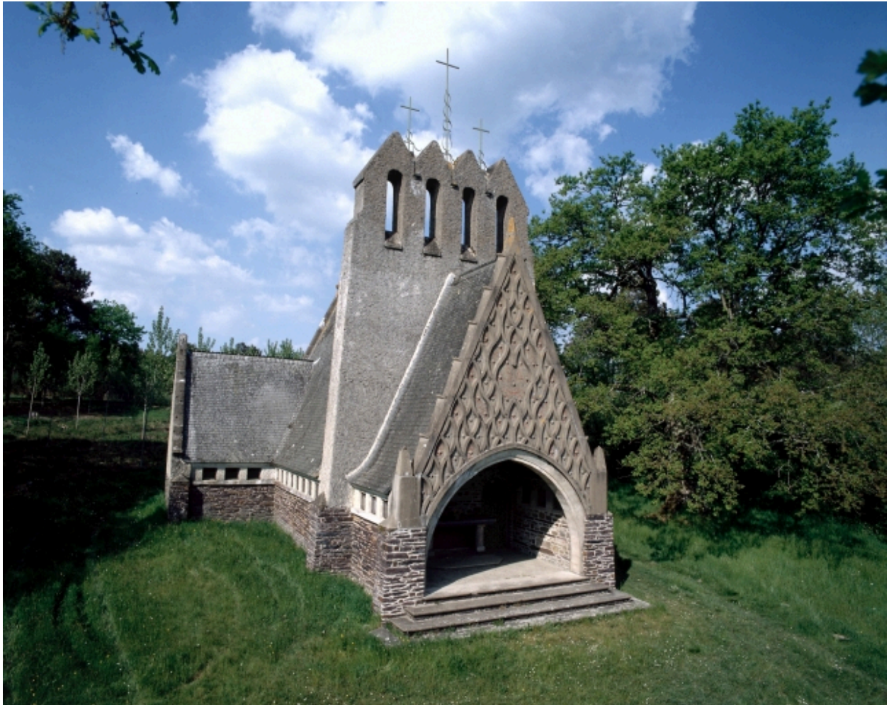
Elévation Nord-Ouest : vue générale
