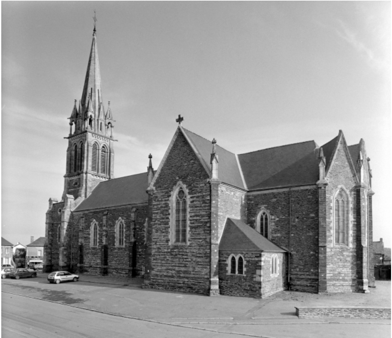
Elévation Sud : vue générale
