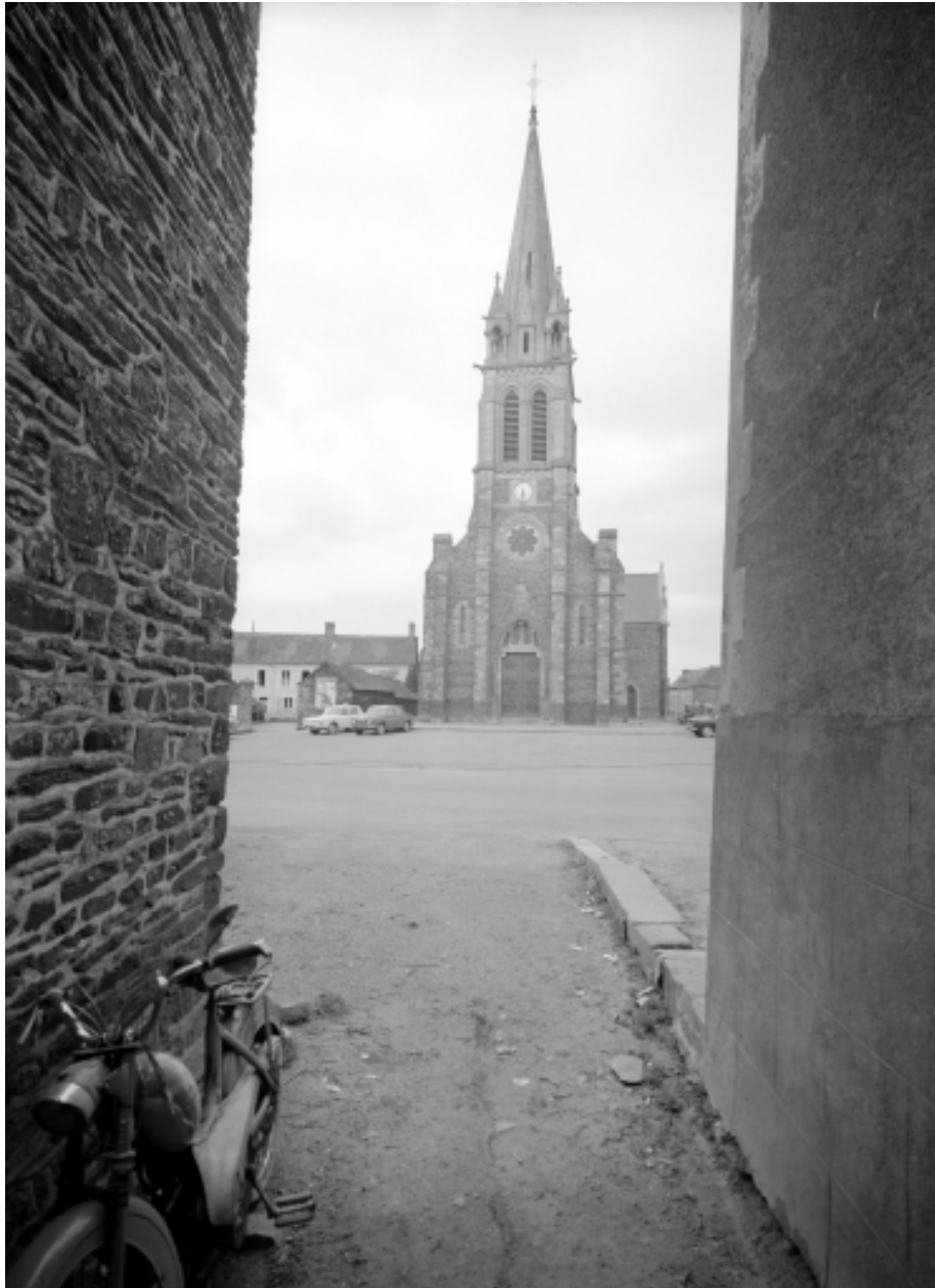
Elévation Ouest : vue générale
