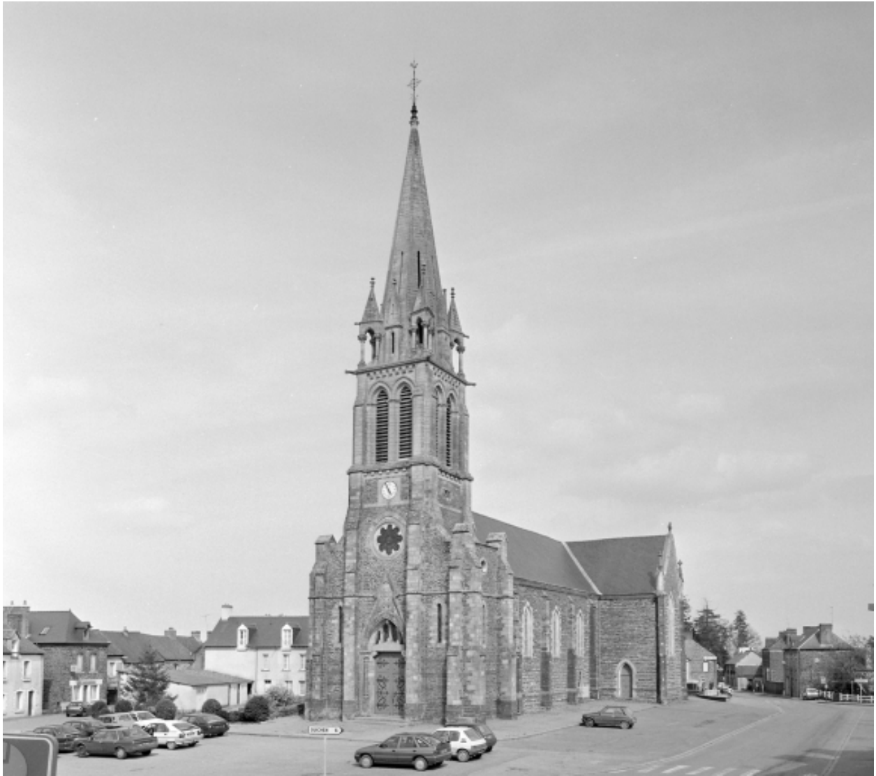
Elévation Ouest : vue générale
