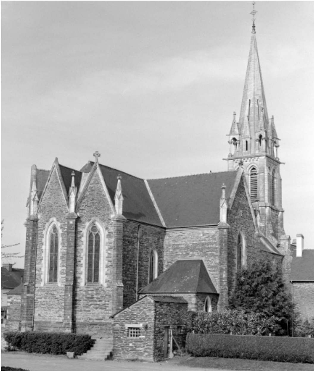
Elévation Nord-Est : vue générale
