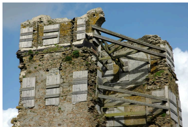
Vue du donjon : niveaux supérieurs (consolidation par étaieement mise en place en 2000) Phot. Guillaume Lécueillier IVR53_20062904213NUCA
