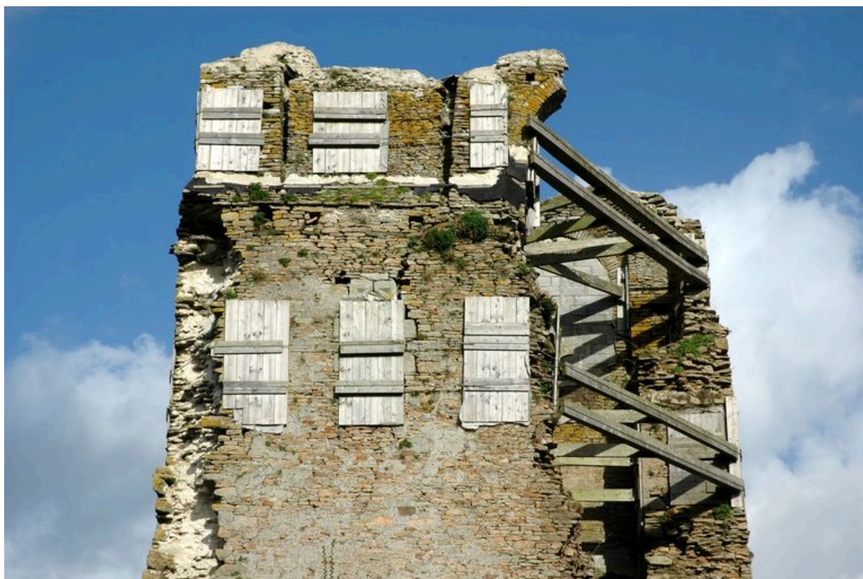
Vue du donjon : niveaux supérieurs (consolidation par étaieement mise en place en 2000)
