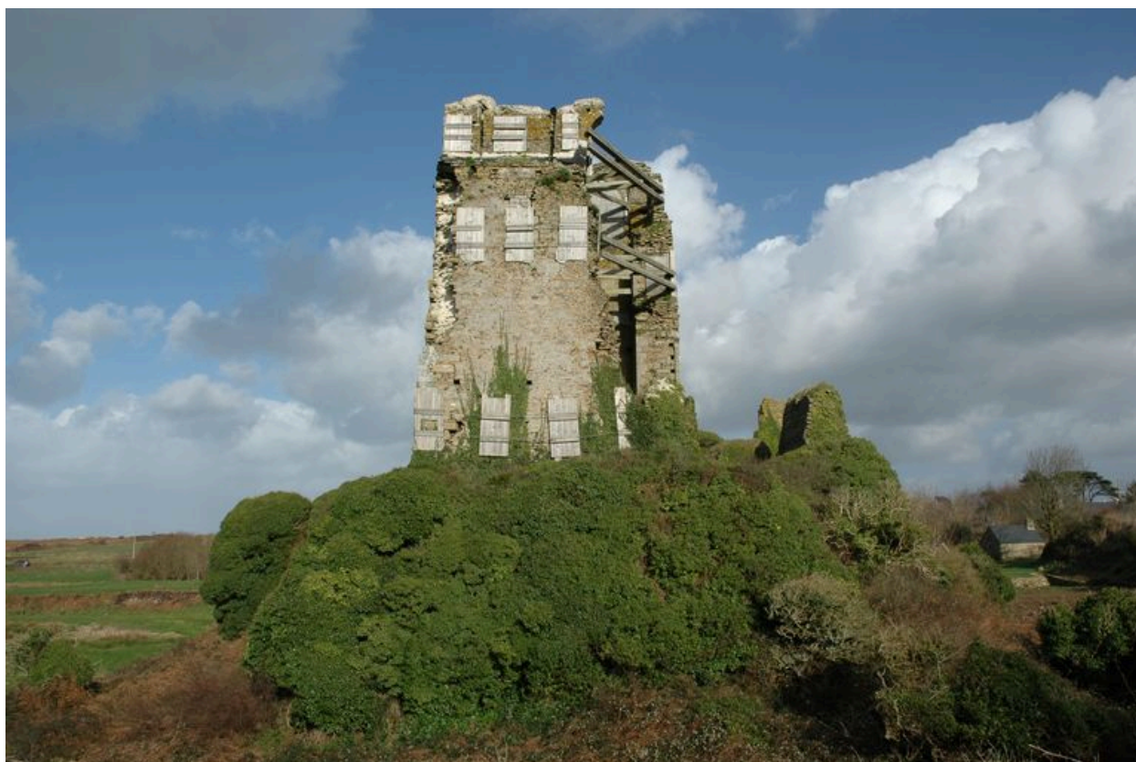
Vue générale du donjon partiellement envahi par la végétation
