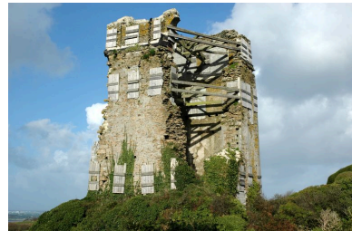
Vue générale du donjon (consolidation par étaieement mise en place en 2000) Phot. Guillaume Lécueillier IVR53_20062904211NUCA
