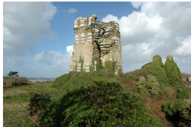
Vue générale du château fort de Trémazan Phot. Guillaume Lécueillier IVR53_20062904209NUCA
