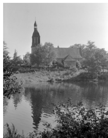
Elévation sud, partie ouest : vue générale Phot. Guy Artur, Phot. Norbert Lambart IVR53_19943500955X
