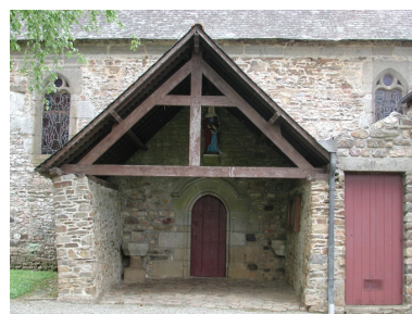
Façade sud : détail du porche Phot. Elise Lauranceau IVR53_20053514508NUCA
