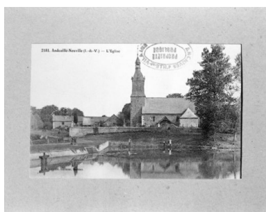
Elévation sud : vue de situation sur une carte postale ancienne Phot. Guy Artur, Phot. Norbert Lambart IVR53_19933500723XB
