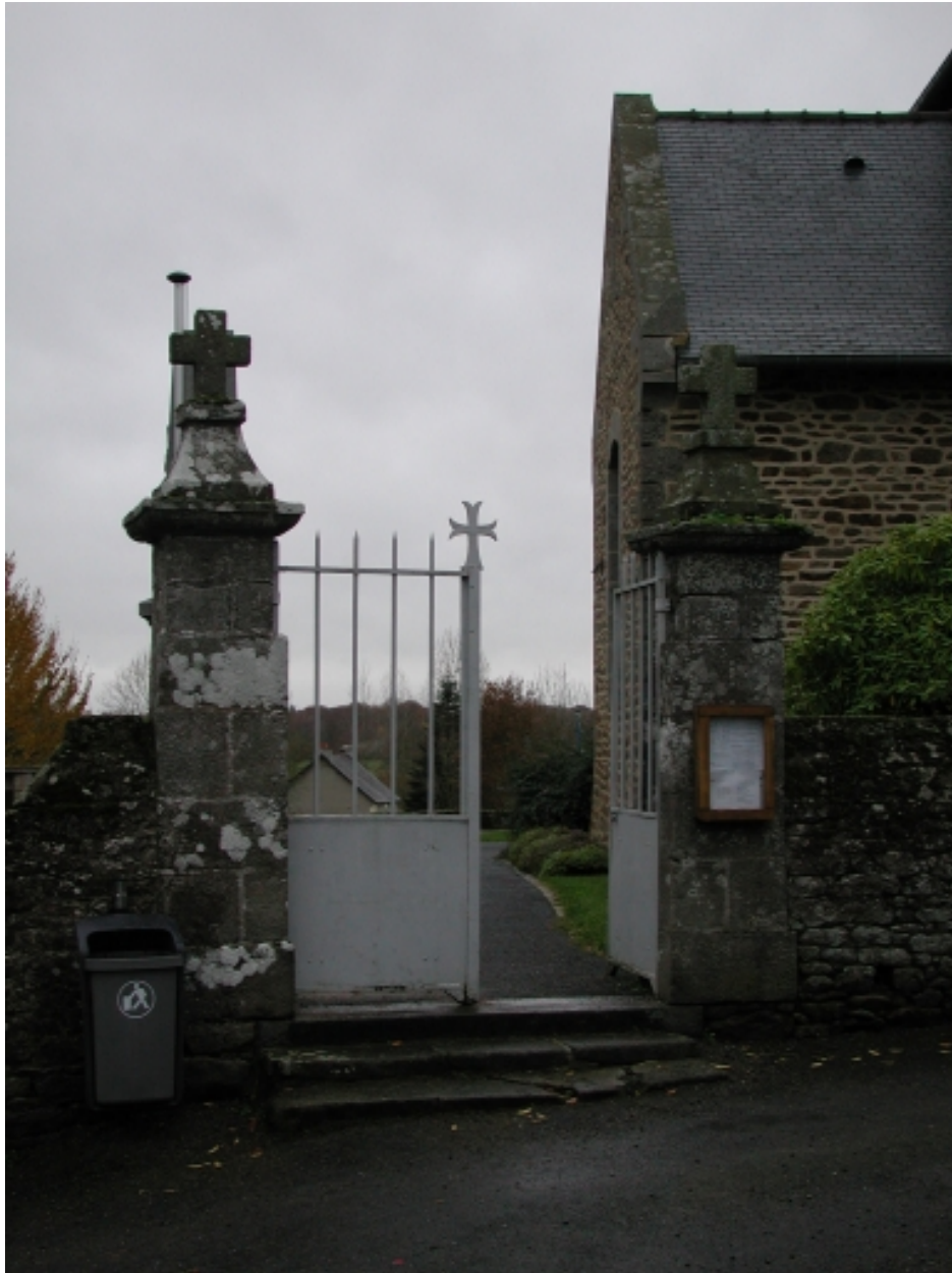
Portail de l'enclos : vue générale est
