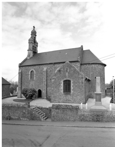
Vue générale sud Phot. Guy Artur, Phot. Norbert Lambart IVR53_19943500755XA
