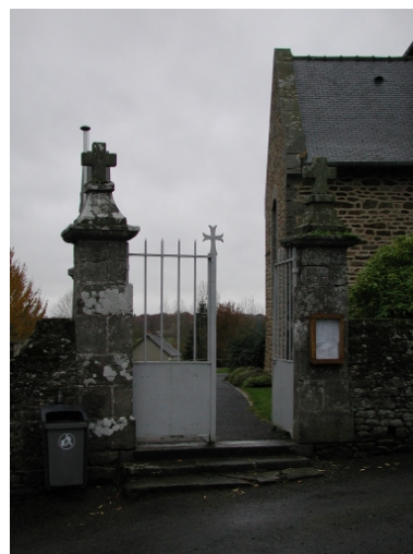
Portail de l'enclos : vue générale est
