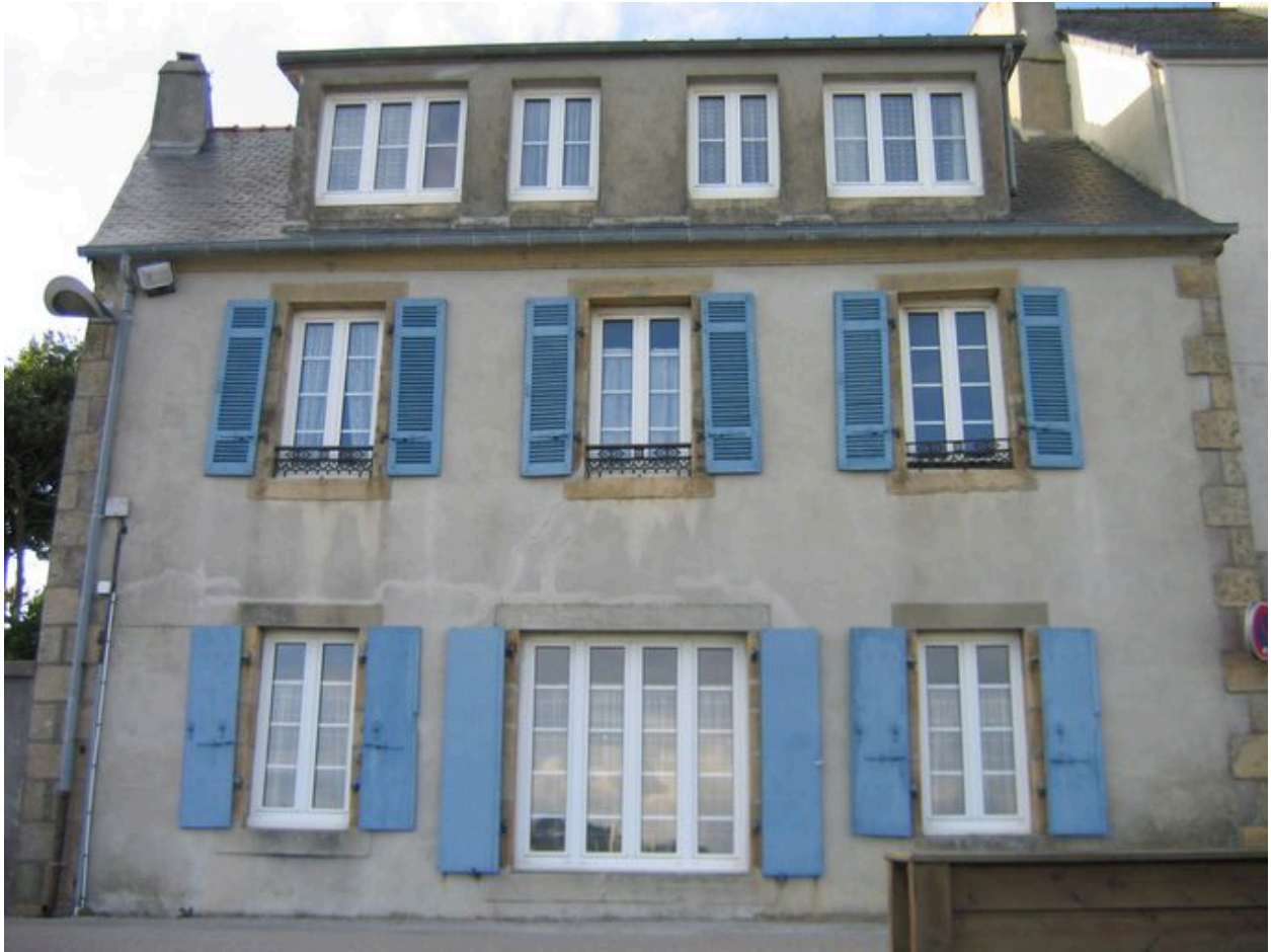
Vue générale de l'ancienne maison du gérant de l'Usine Rouge
