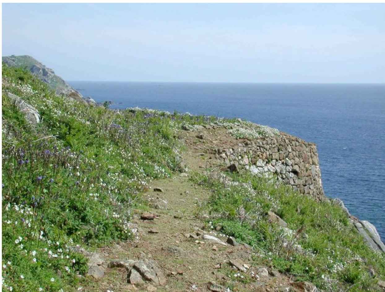
Vue de la face ouest de la batterie sud de l'île aux Moines
