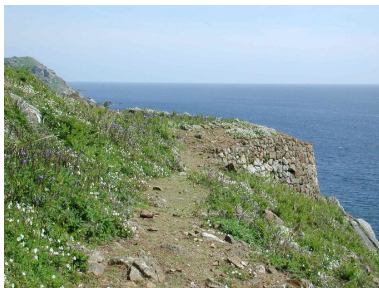
Vue de la face ouest de la batterie sud de l'île aux Moines Phot. Guillaume Lécueillier IVR53_20022202517NUCA
