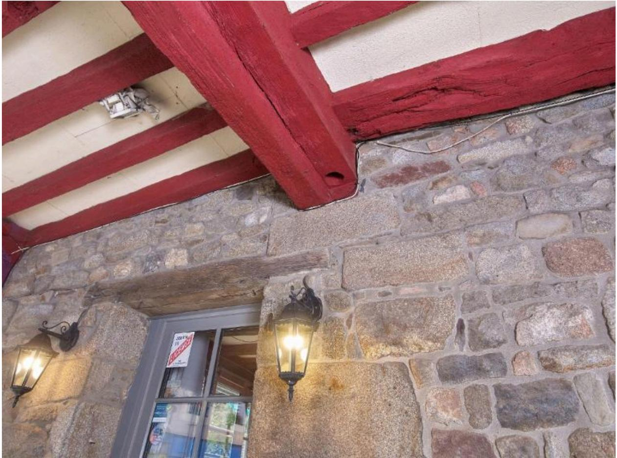
Cette poutre comporte une mortaise ronde et une feuillure qui signalent l'emplacement probable d'un portail.
