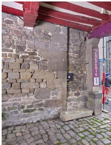
Nette rupture entre deux maçonneries au 7 rue Chateaubriand suggérant une reprise et un réalignement de la façade.
