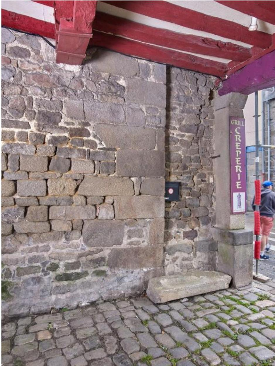
Nette rupture entre deux maçonneries au 7 rue Châteaubriand suggérant une reprise et un réalignement de la façade.
