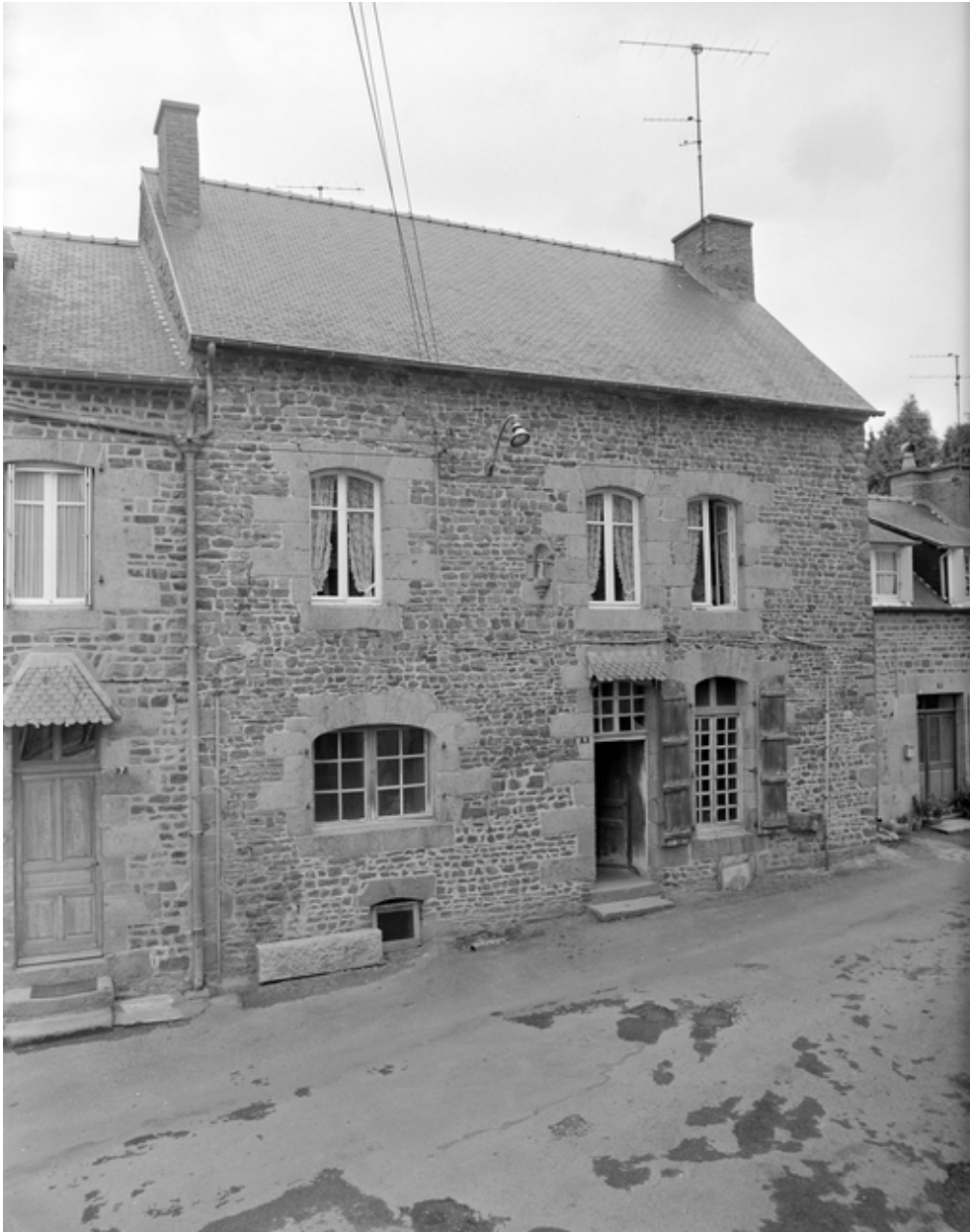
Vue générale de la façade antérieure.
