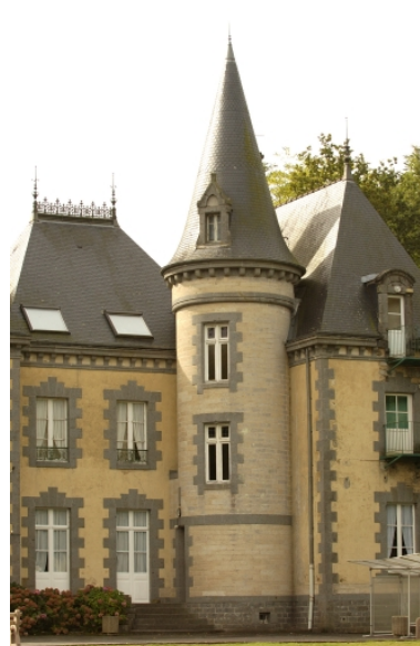
Détail de la tour d'escalier Phot. Norbert Lambart IVR53_20053502667NUCA
