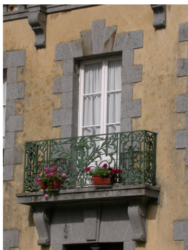
Détail de l'une des baies Phot. Stéphanie Ménard IVR53_20053518658NUCA
