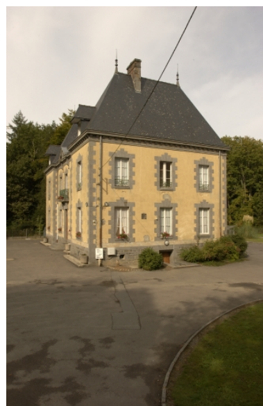
Vue sud-est Phot. Norbert Lambart IVR53_20053502660NUCA
