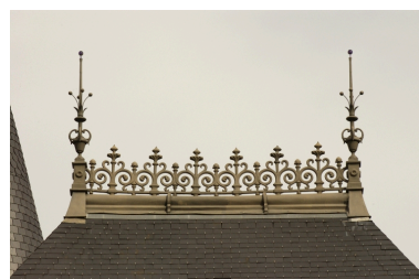
La crête de toit Phot. Norbert Lambart IVR53_20053502665NUCA
