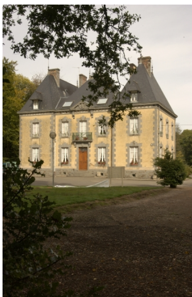
Vue d'ensemble sud-est Phot. Norbert Lambart IVR53_20053502662NUCA
