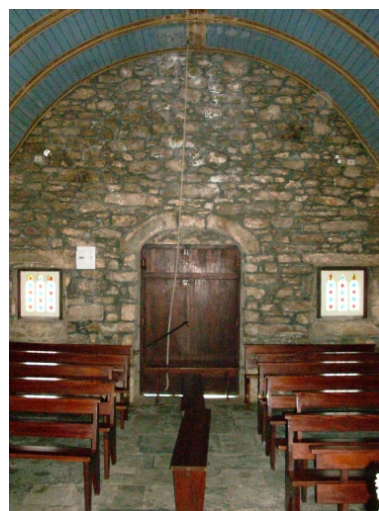
Kernouës, chapelle de la Clarté : vue axiale ouest Phot. Gwénaél Fauchille IVR53_20082906339NUCA
