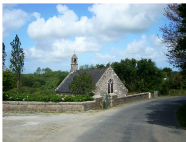
Kernouës, chapelle de la Clarté : vue générale sud-est Phot. Gwénaél Fauchille IVR53_20082906335NUCA
