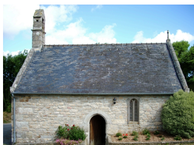
Kernouës, chapelle de la Clarté : élévation sud Phot. Gwénaél Fauchille IVR53_20082906337NUCA
