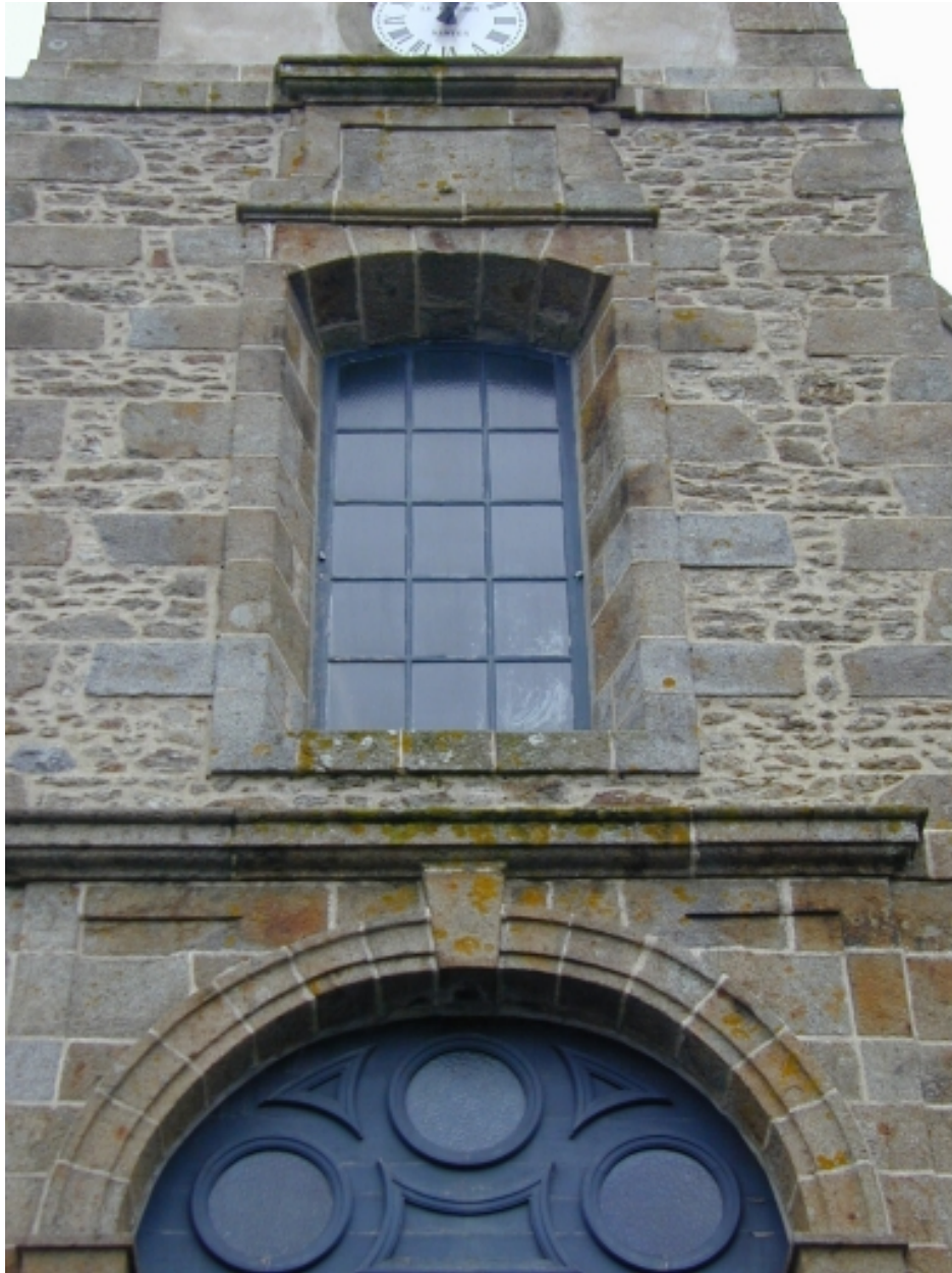
Verrière de la baie au deuxième niveau de la tour-porche
