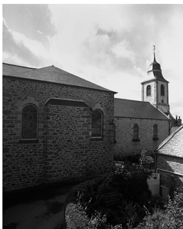
Elévation nord : vue générale Phot. Guy Artur, Phot. Norbert Lambart IVR53_19943501798X
