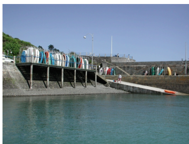
Vue de l'extrémité du quai Surcouf : remarquer le ponton aux annexes sur pilotis et la cale
