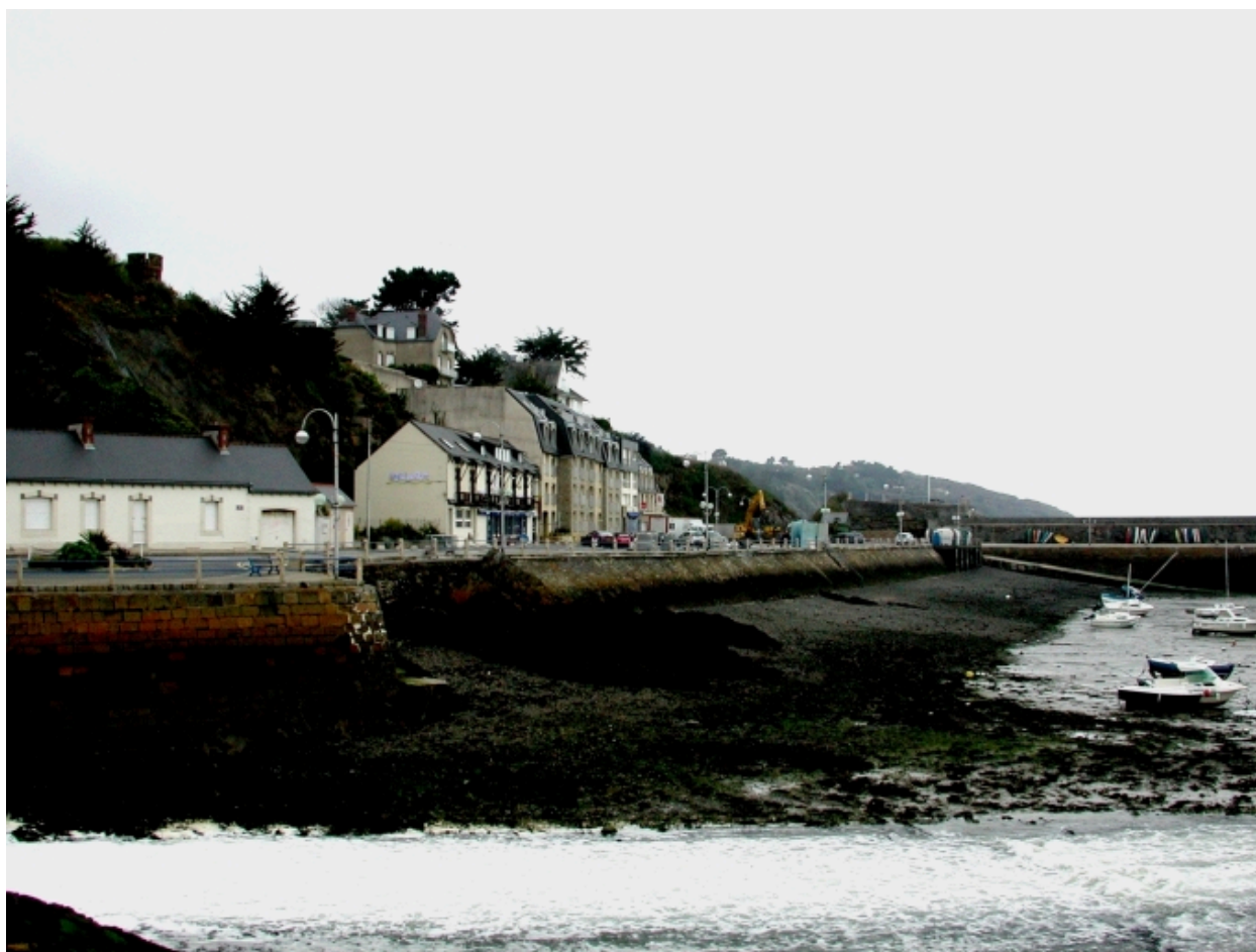
Vue générale des quais et murs de quai : remarquer le fruit de mur et sa forte inclinaison
