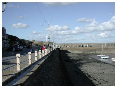
Vue du garde-corps et de la promenade devant le quai Surcouf Phot. Guy Prigent
