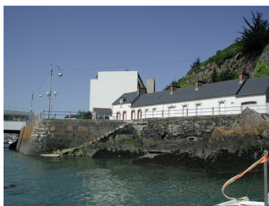
Vue du mur de quai devant l'ancien bâtiment des Ponts et Chaussées Phot. Guy Prigent IVR53_20072206403NUCA
