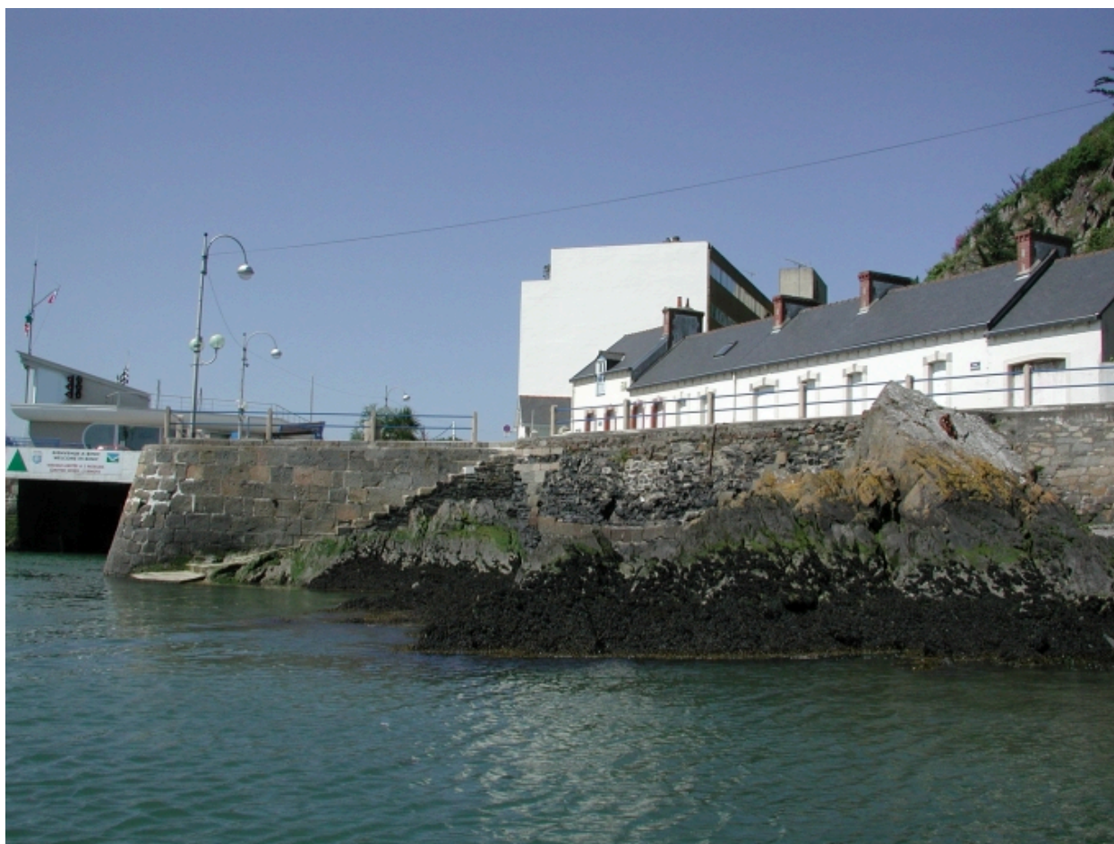
Vue du mur de quai : remarquer les escaliers et la partie du mur rejointoillé
