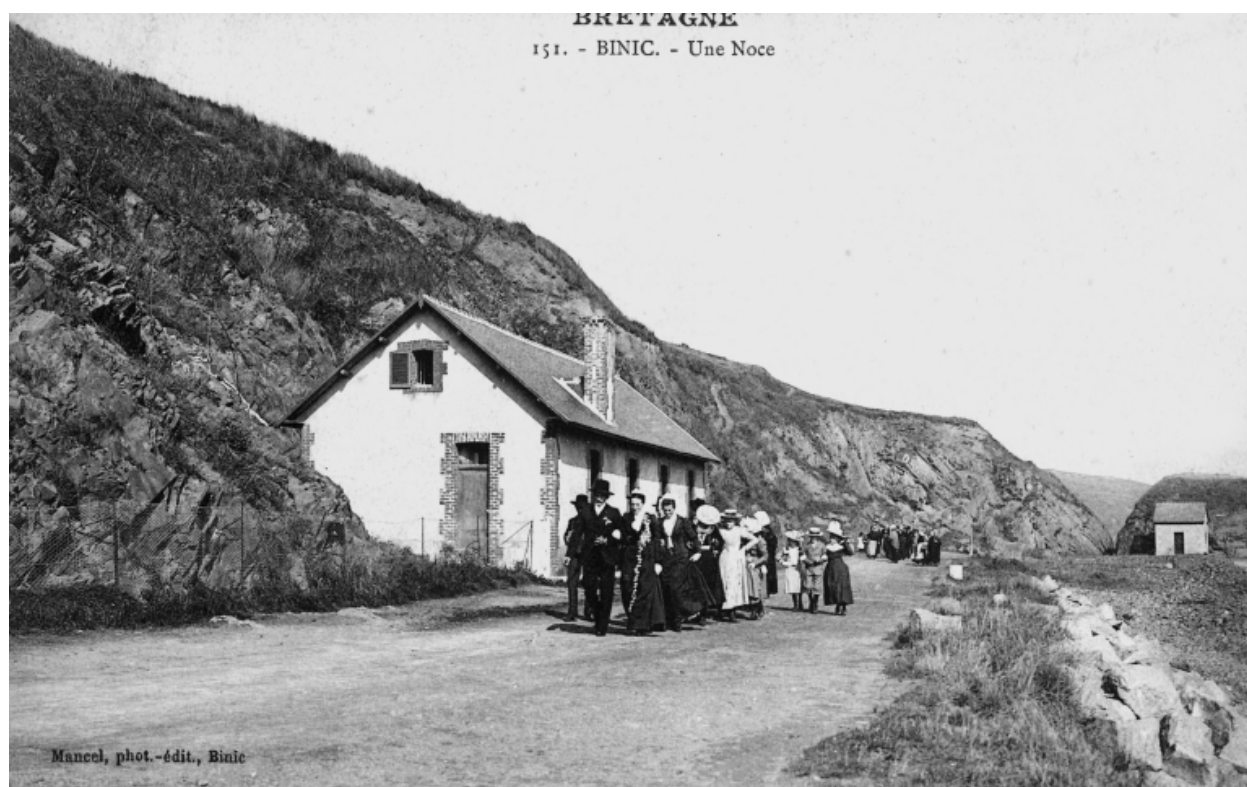
Vue du quai Surcouf au début du 20ème siècle : remarquer le bâtiment des Ponts et Chaussées et les enrochements de défense contre la mer, en l'absence de quai continu (collection particulière)
