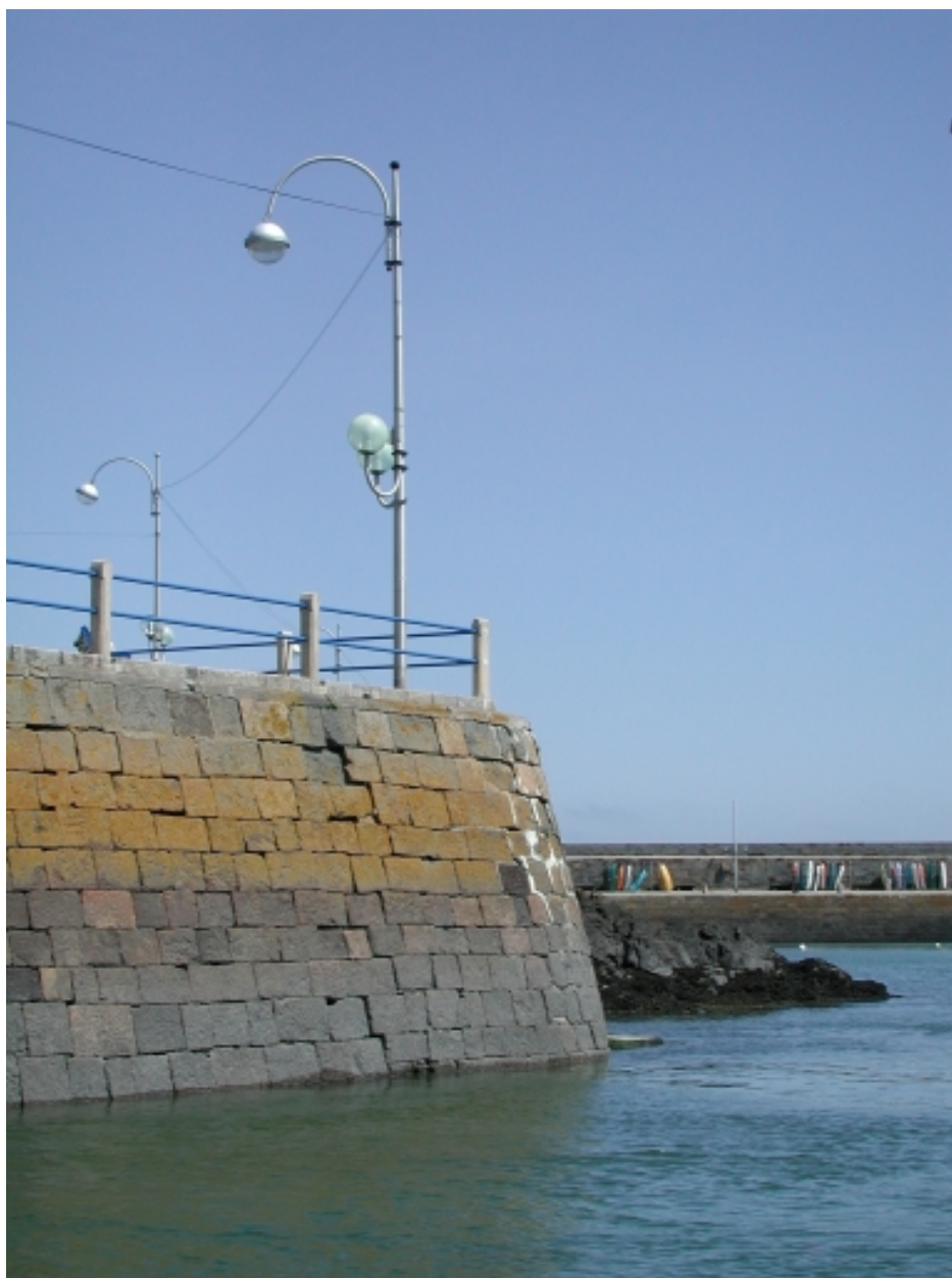
Vue de l'extrémité de la 1ère partie du quai dans le prolongement du quai Jean Bart
