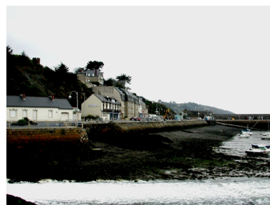
Vue générale des quais et murs de quai : remarquer le fruit de mur et sa forte inclinaison
