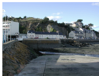
Vue du front de mer du quai Surcouf, investi par des immeubles et commerces et l'ancienne villa Galerne au-dessus de la falaise Phot. Guy Prigent IVR53_20072206408NUCA
