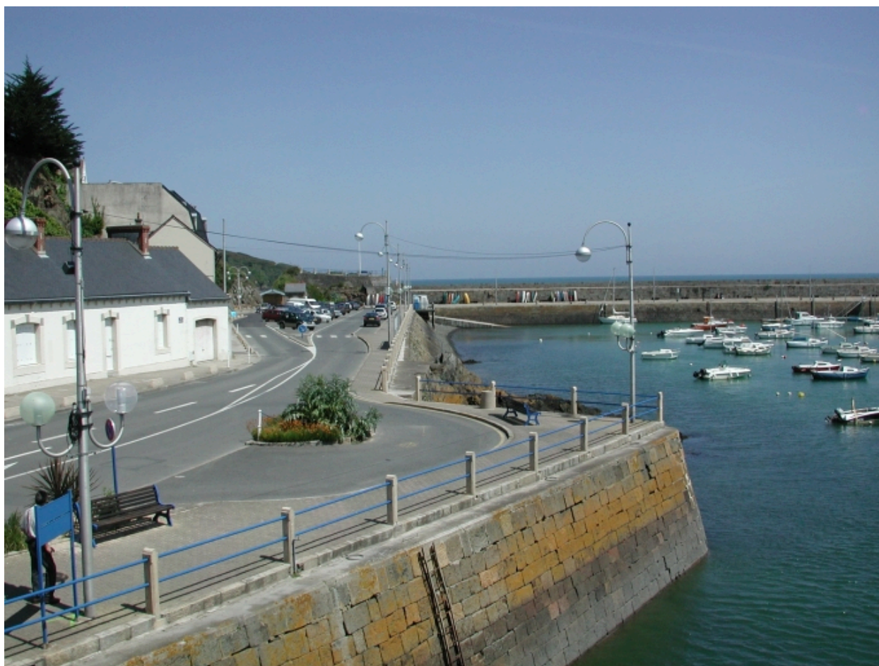
Vue générale et forme des quais
