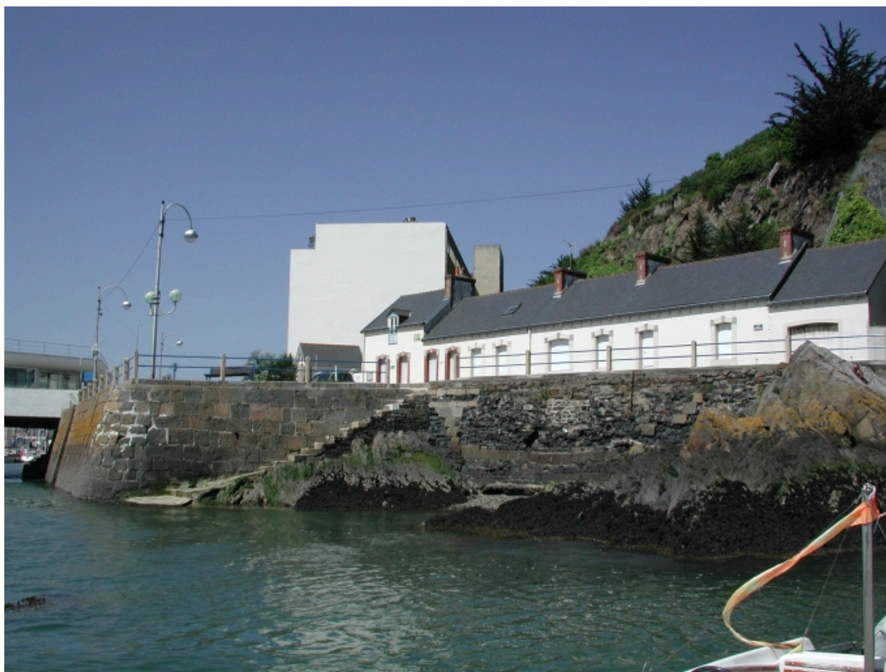
Vue du mur de quai devant l'ancien bâtiment des Ponts et Chaussées
