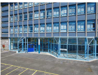
Externat : vue partielle de la façade ouest. Georges Tourry et Hervé Péron, architectes, 1963. Le préau a été fermé à la fin des années 1980 ou au début des années 1990. Phot. Bernard Bègne IVR53_20222900325NUCA
