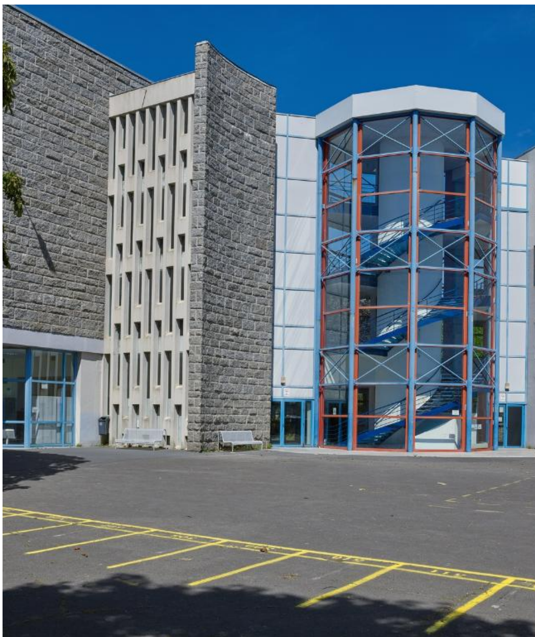
Escalier vitré de l'extension de 1988. Jean-Pierre Huéber, architecte.
