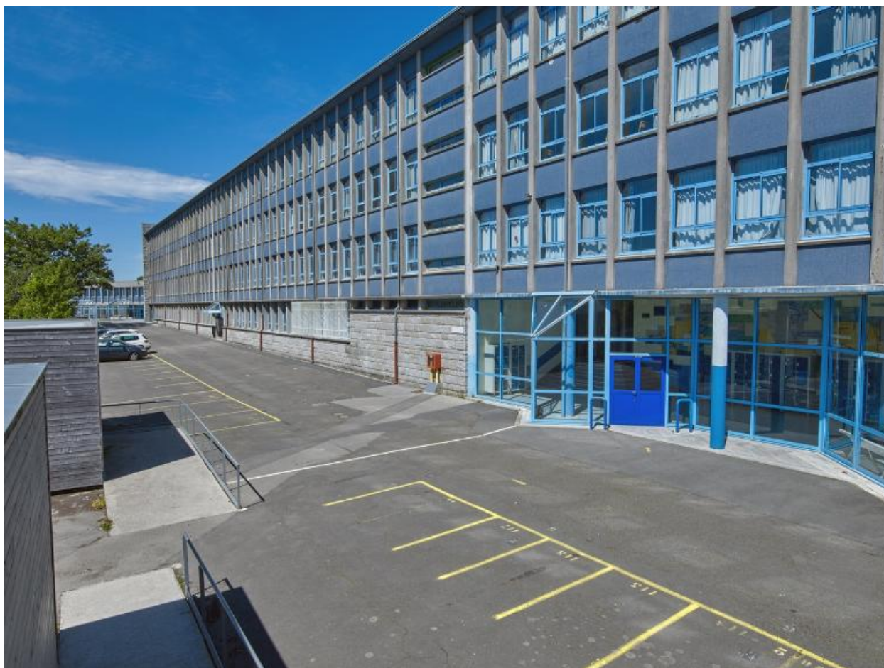
Externat - administration : vue d'ensemble prise du sud. A l'arrière plan, la restauration scolaire. Georges Tourry et Hervé Péron, architectes, 1963.
