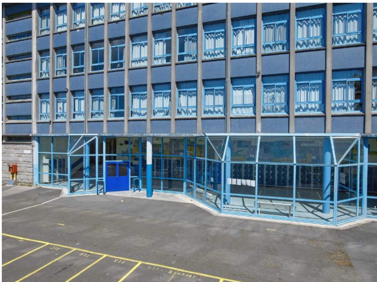
Externat : vue partielle de la façade ouest. Georges Tourry et Hervé Péron, architectes, 1963. Le préau a été fermé à la fin des années 1980 ou au début des années 1990.
