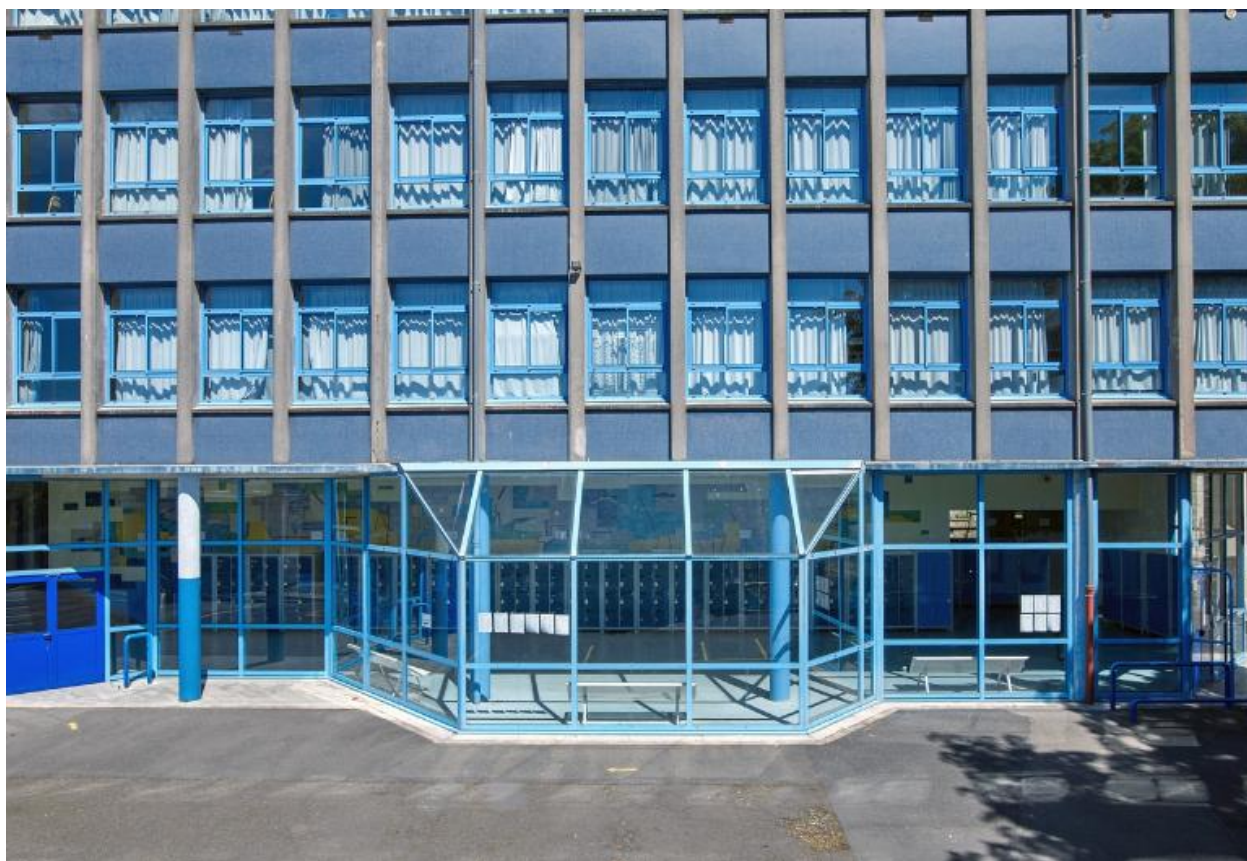
Externat : vue partielle de la façade ouest. Georges Tourry et Hervé Péron, architectes, 1963. Le préau a été fermé à la fin des années 1980 ou au début des années 1990.
