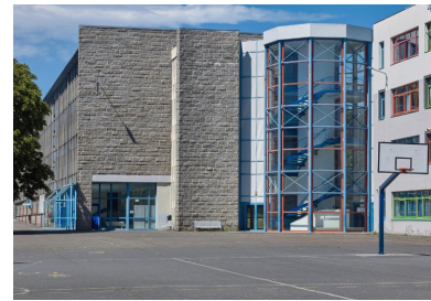
Jonction entre l'externat - administration de 1963 et l'extension de 1988-1996. Vue prise du sud-ouest. Phot. Bernard Bègne IVR53_20222900322NUCA
