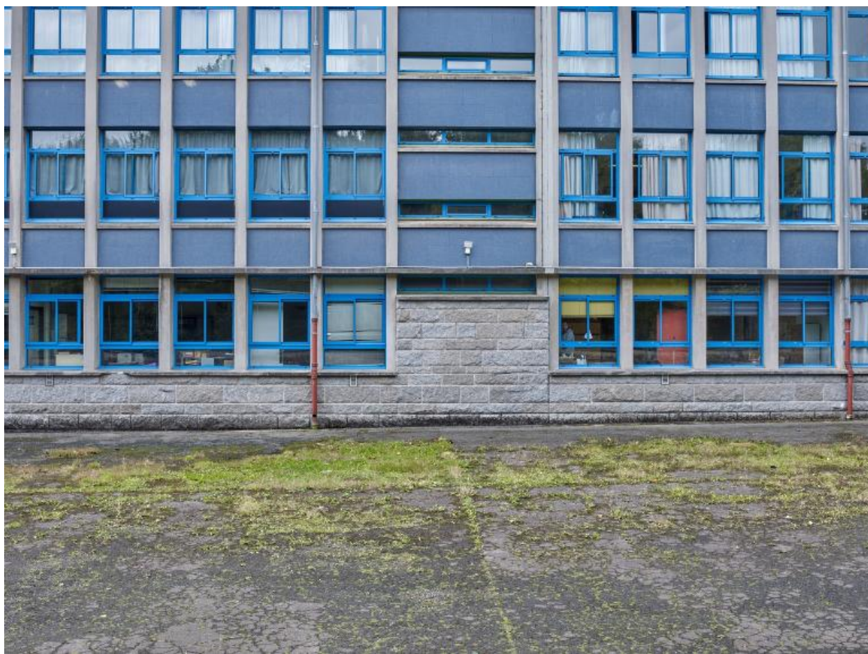
Façade nord du bâtiment
