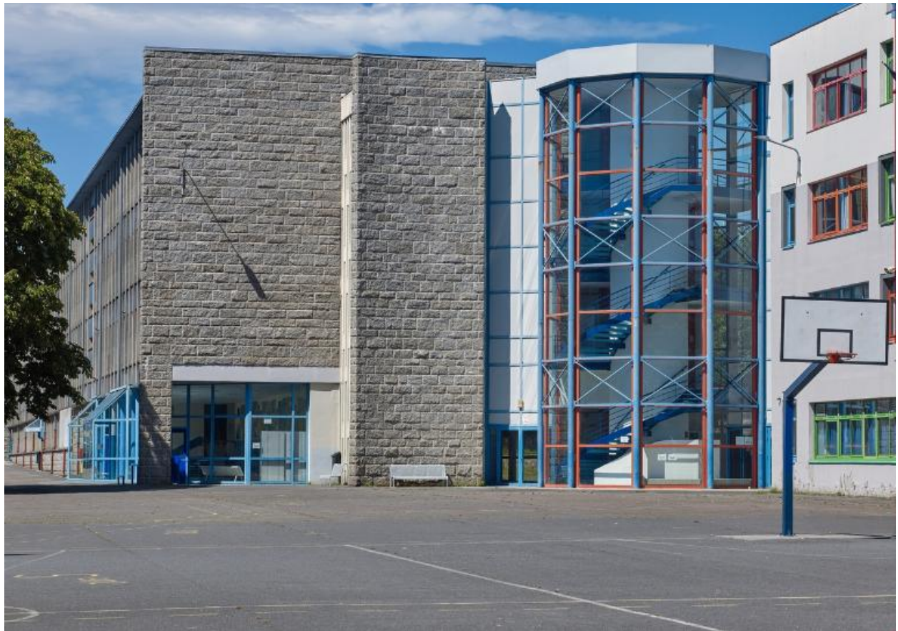
Jonction entre l'externat - administration de 1963 et l'extension de 1988-1996. Vue prise du sud-ouest.
