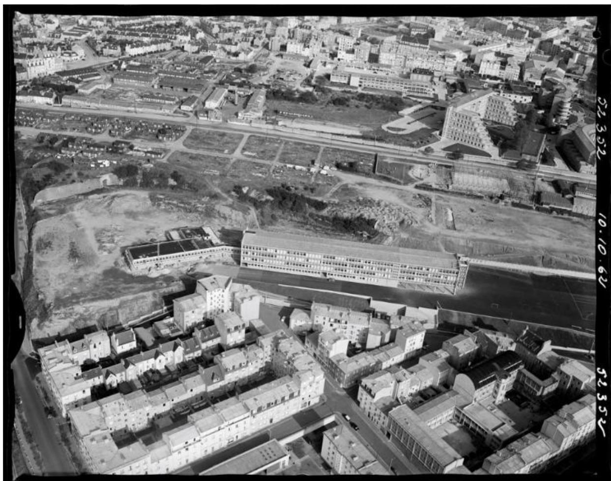
Georges Tourry, architecte. Vue aérienne prise de l'ouest, le 10 octobre 1962. Le gymnase est en cours de construction.
