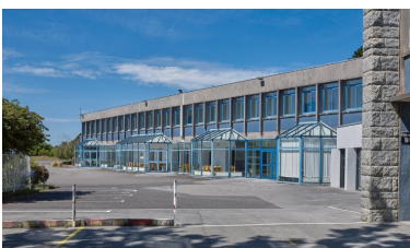
Restauration scolaire et externat. Georges Tourry et Hervé Péron, architectes, 1963. En partie restructuré en 1988 et vers 2016. Phot. Bernard Bègne IVR53_20222900327NUCA
