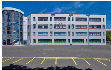
Façade ouest de l'extension de 1988, surélevée en 1996. Jean-Pierre Huéber, architecte. La couleur, utilisée en façade sur les huisseries, les encadrements ou les conduits de gouttières, adoucit la rigoureuse simplicité du parti constructif. Phot. Bernard Bègne IVR53_20222900321NUCA
