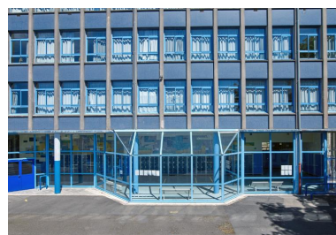
Externat : vue partielle de la façade ouest. Georges Tourry et Hervé Péron, architectes, 1963. Le préau a été fermé à la fin des années 1980 ou au début des années 1990. Phot. Bernard Bègne IVR53_20222900326NUCA
