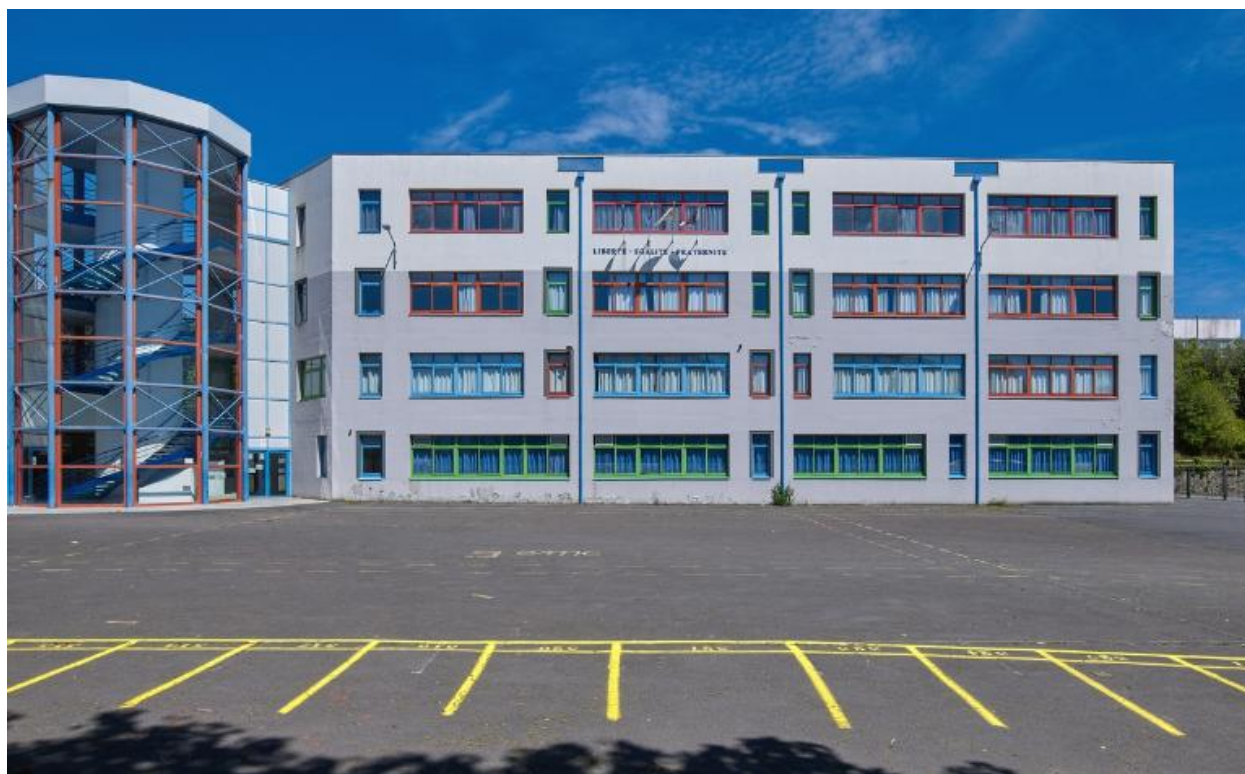
Façade ouest de l'extension de 1988, surélevé en 1996. Jean-Pierre Huéber, architecte. La couleur, utilisée en façade sur les huisseries, les encadrements ou les conduits de gouttières, adoucit la rigoureuse simplicité du parti constructif.
