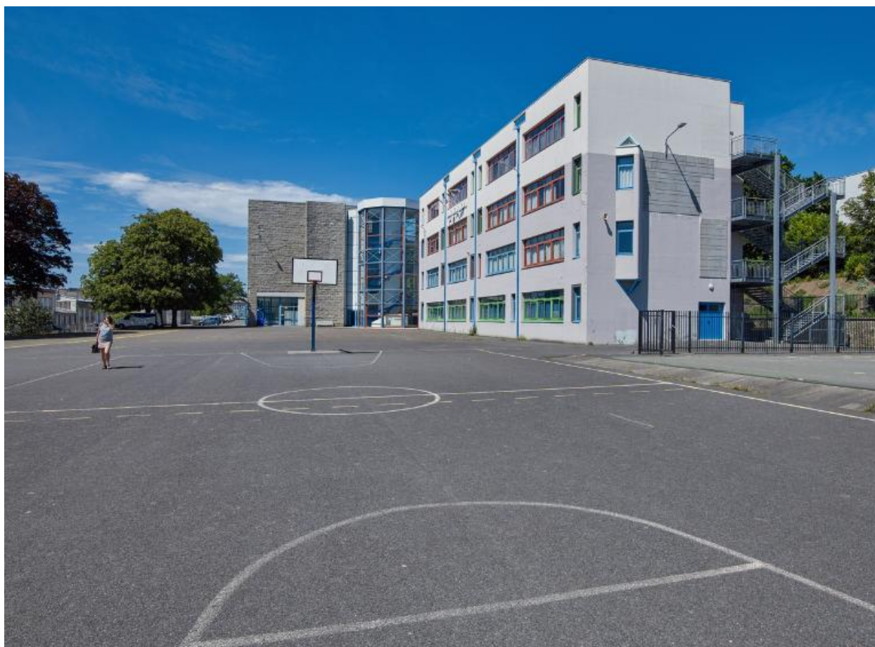
Vue d'ensemble prise du sud. De gauche à droite : pignon sud de l'externat-administration de 1963, escalier et extension de 1988, surélevée en 1996.
