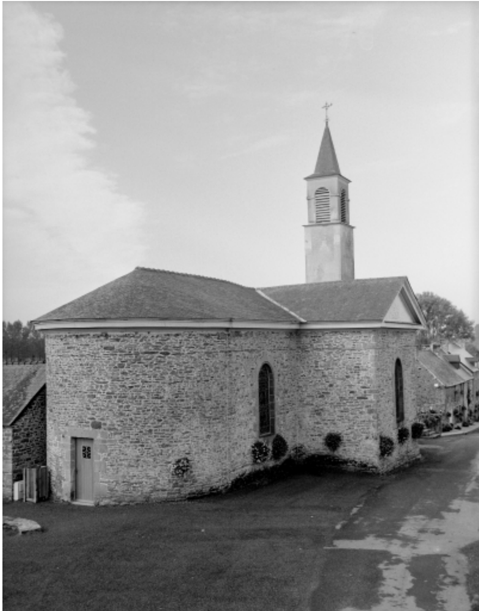
Elévation Nord-Est : vue générale
