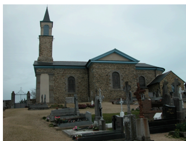
Elévation Sud : vue générale Phot. Véronique Orain, Phot. Erwana L'Haridon IVR53_20073505117NUCA
