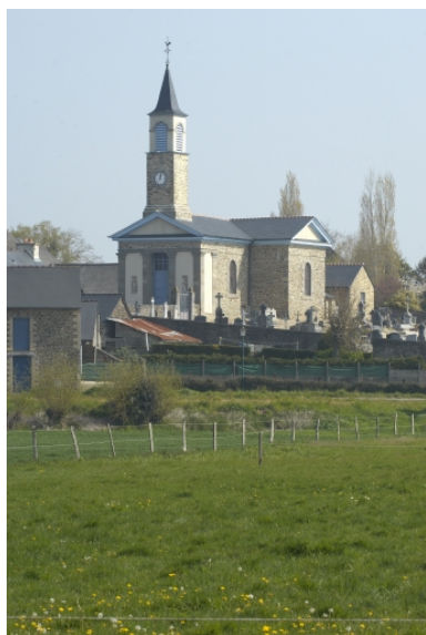
Vue générale Phot. Norbert Lambart IVR53_20073500538NUCA
