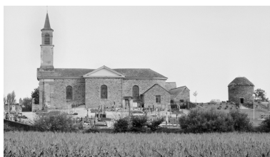
Elévation Sud : vue générale Phot. Guy Artur, Phot. Norbert Lambart IVR53_19943501787X
