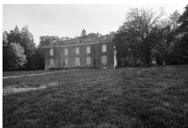
Vue générale de la façade nord Phot. Guy Artur IVR53_19703501410V
