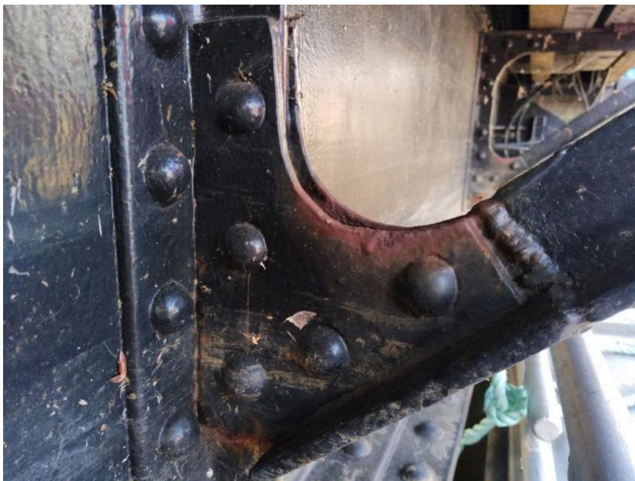
Le pont tournant du port du Légué : détail des rivets de la structure métallique
