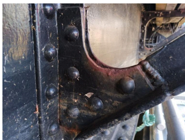
Le pont tournant du port du Légué : détail des rivets de la structure métallique Phot. Auteur inconnu IVR53_20262210003NUCA
