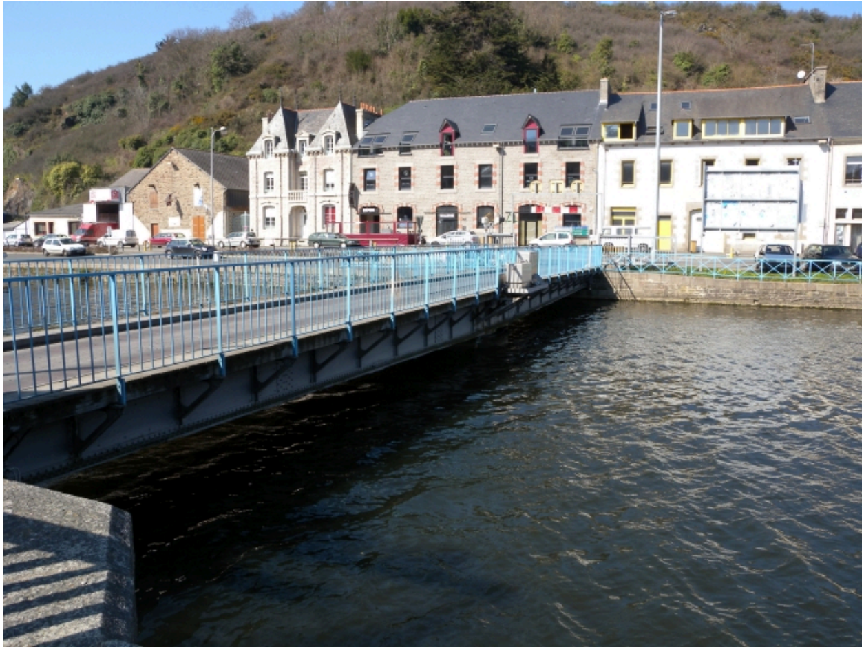
Vue générale du pont tournant depuis rive droite
