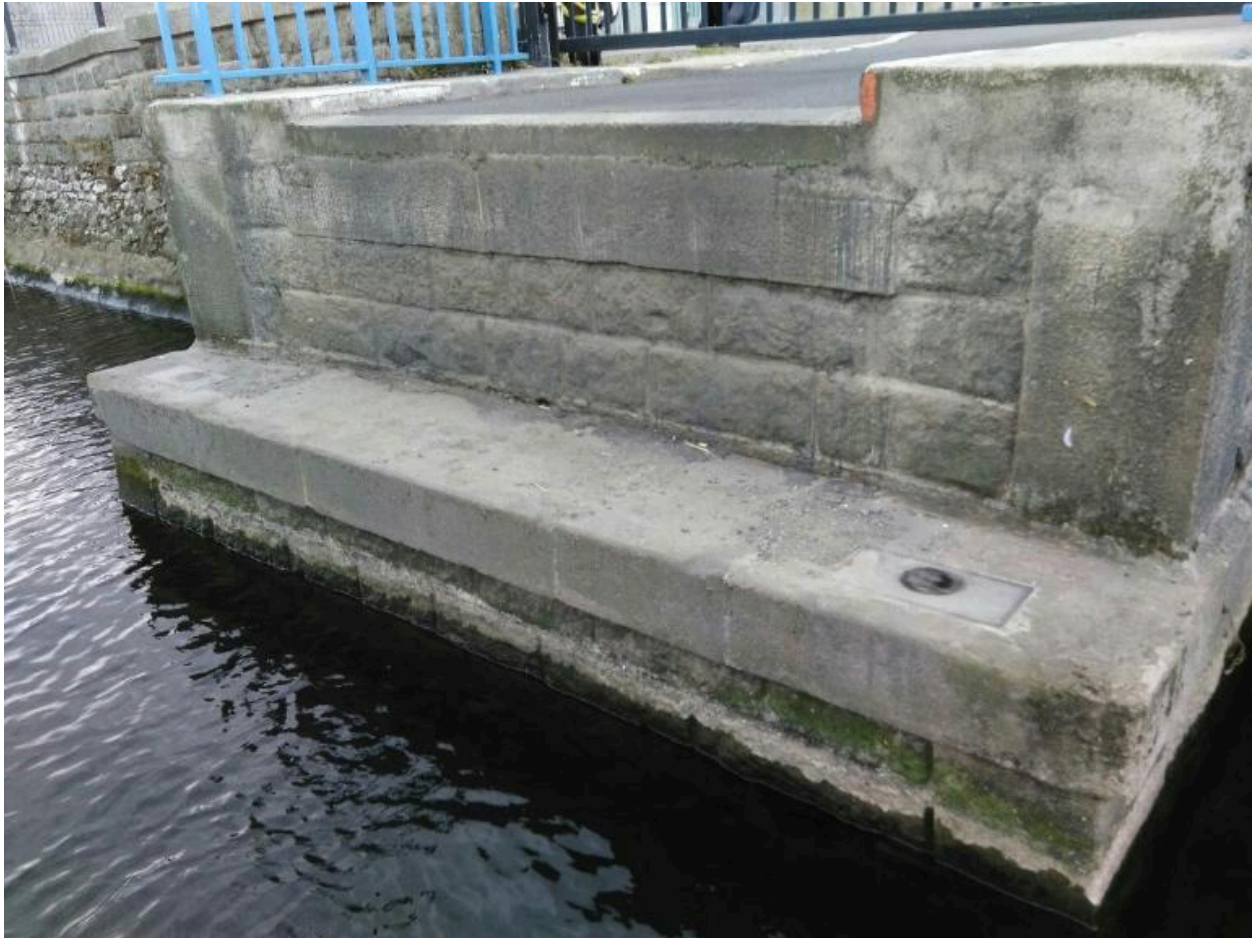
Le pont tournant du port du Légué : culée maçonnée côté quai de Rohannec'h
