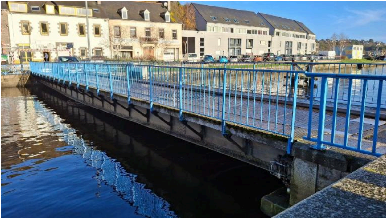
Le pont tournant dans son environnement portuaire et urbain : tablier
