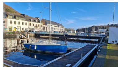
Le pont tournant dans son environnement portuaire et urbain Phot. Erwana L'Haridon IVR53_20262210171NUCA
