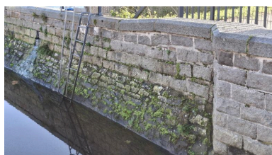
Maçonneries rive droite Phot. Erwana L'Haridon IVR53_20262210179NUCA
