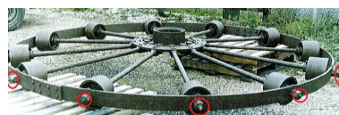
Mécanisme de rotation du pont : pivot central, galets, crémaillère courbe (document de suivi de travaux) Phot. Auteur inconnu IVR53_20262210001NUCA
