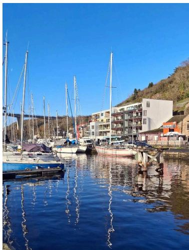
Duc d'albe amont dans son environnement portuaire Phot. Erwana L'Haridon IVR53_20262210177NUCA
