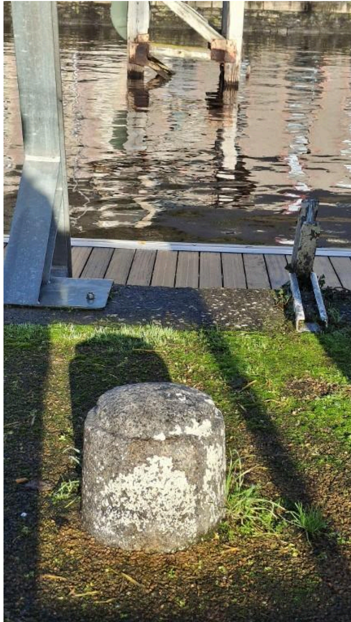
Bitte d'amarage, ponton et duc d'albe amont
