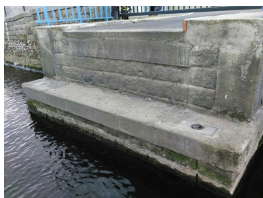
Le pont tournant du port du Légué : culée maçonnée côté quai de Rohannec'h Phot. Auteur inconnu IVR53_20262210002NUCA
