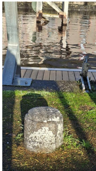
Bitte d'amorage, ponton et duc d'albe amont Phot. Erwana L'Haridon IVR53_20262210173NUCA
