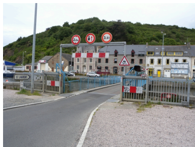
Vue du pont tournant depuis la rive droite du Légué Phot. Guy Prigent IVR53_20082213115NUCA
