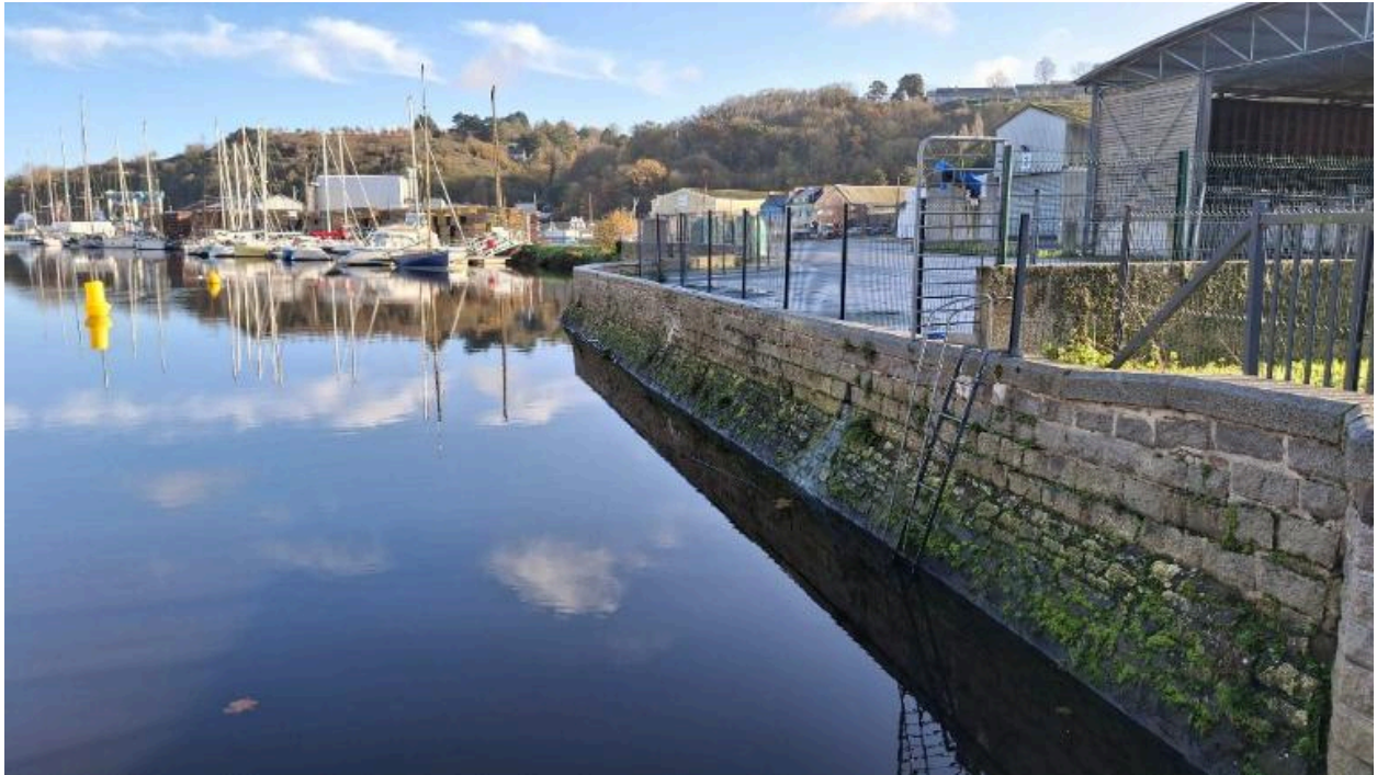
Terre-plein et quai maçonné entre culée du pont et pont du Gouëdic
