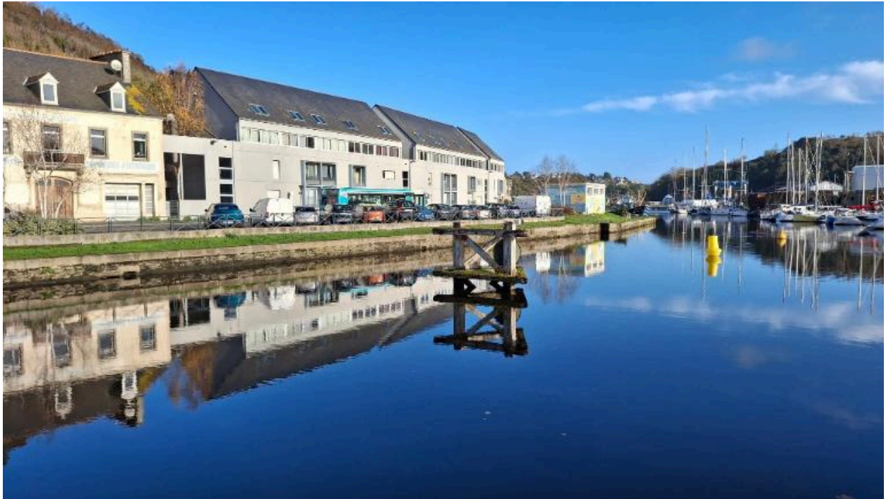
Duc d'albe aval aval et environnement urbain et portuaire
