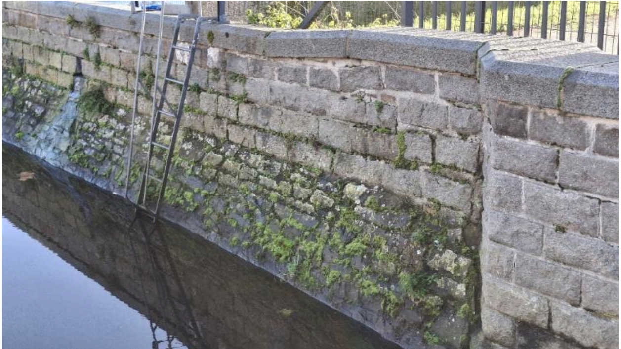
Maçonneries rive droite
