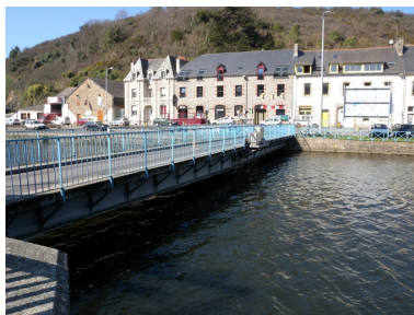
Vue générale du pont tournant depuis rive droite Phot. Guy Prigent IVR53_20082212981NUCA
