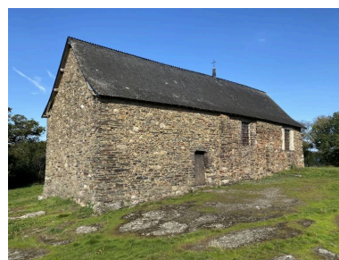
Façade sud, vue générale Phot. Baptiste Oligo IVR53_20265610124NUCA
