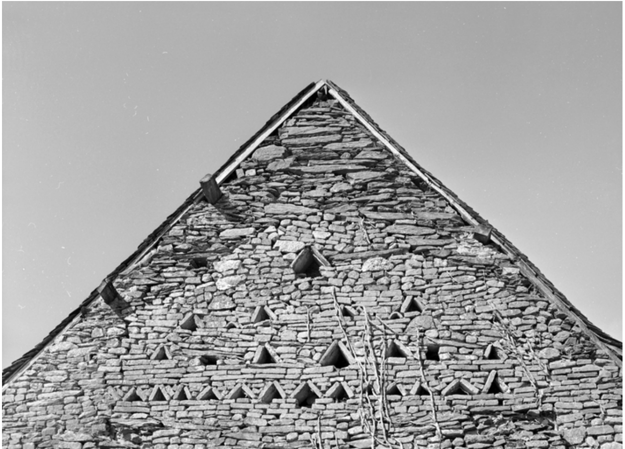
Détail du pignon est.
