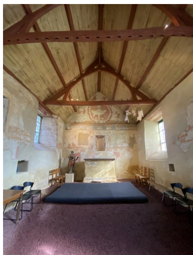
Vue générale de l'intérieur Phot. Baptiste Oligo IVR53_20265610114NUCA
