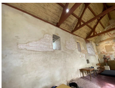
Élévation nord Phot. Baptiste Oligo IVR53_20265610123NUCA
