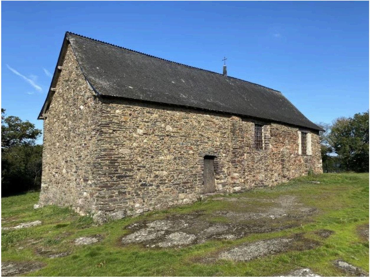
Façade sud, vue générale
