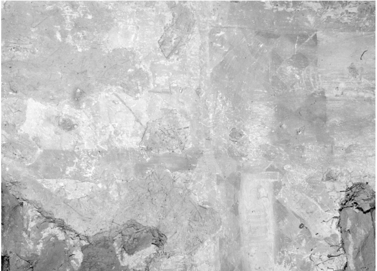
Nef, mur nord, à gauche de la fenêtre est
