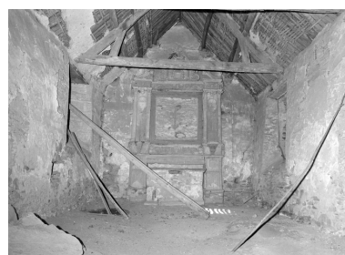
Vue intérieure vers sud-ouest. Phot. François Dagorn IVR53_19775600915X
