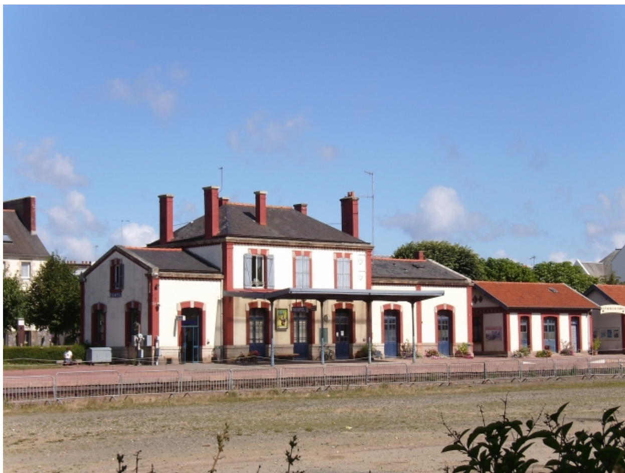
Vue générale de la gare
