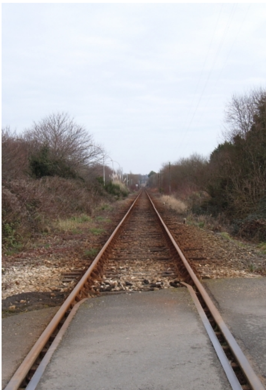
Vue générale de la voie ferrée à hauteur du lieu-dit Goasmeur en direction du centre-ville de Paimpol
