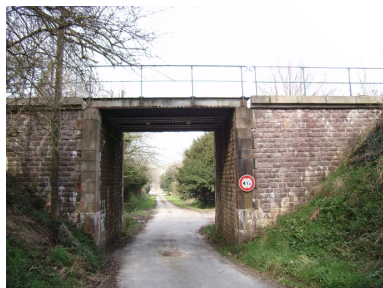
Vue générale sud du passage inférieur de Pont-Dervan : ouvrage à tablier métallique construit en pierre de taille de granite à ton clair et moellons de grès rose équarris polygonaux Phot. Patrick Pichouron IVR53_20102209606NUCA
