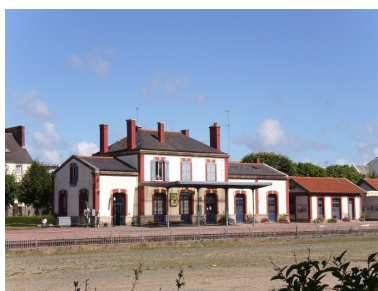
Vue générale de la gare
