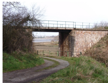
Vue générale sud-ouest du passage inférieur de Traou-Du : ouvrage à tablier métallique construit en pierre de taille de granite à ton clair et moellons de grès rose équarris polygonaux Phot. Patrick Pichouron IVR53_20102209578NUCA
