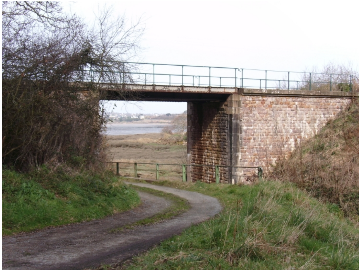
Vue générale sud-ouest du passage inférieur de Traou-Du : ouvrage à tablier métallique contruit en pierre de taille de granite à ton clair et moellons de grès rose équarris polygonaux
