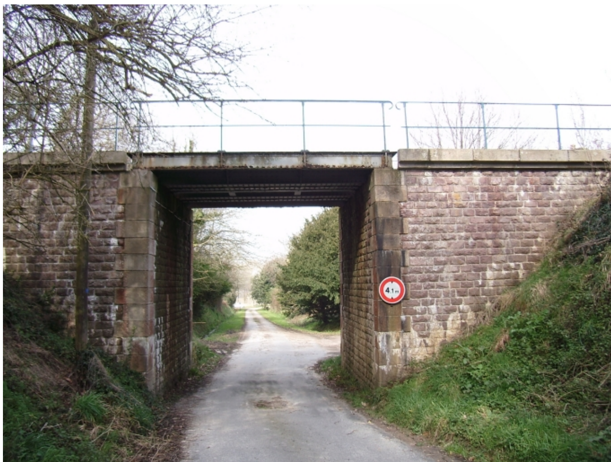
Vue générale sud du passage inférieur de Pont-Dervan : ouvrage à tablier métallique construit en pierre de taille de granite à ton clair et moellons de grès rose équarris polygonaux
