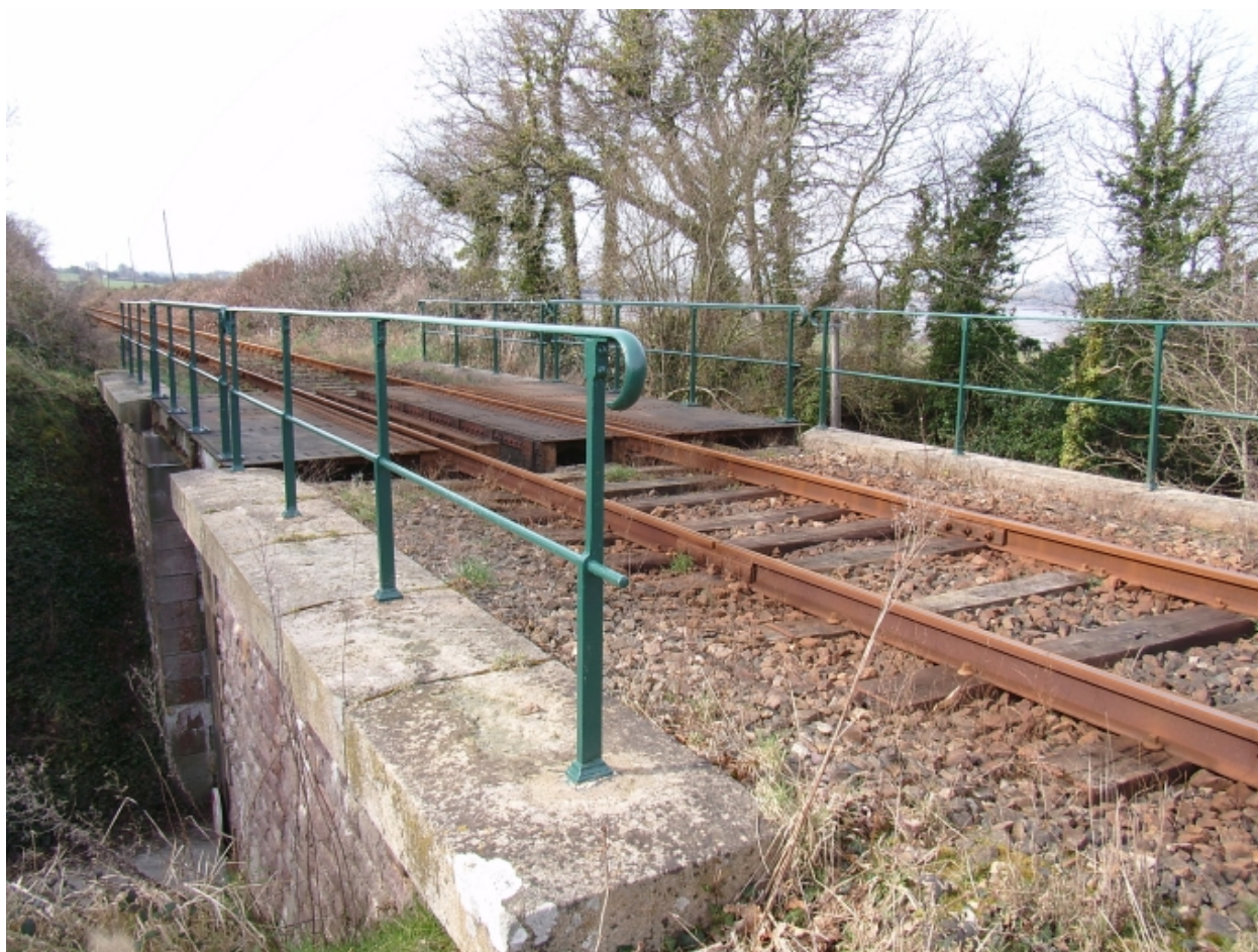
Vue générale de la voie ferrée à hauteur du lieu-dit Pont-Dervan en direction de Pontrieux
