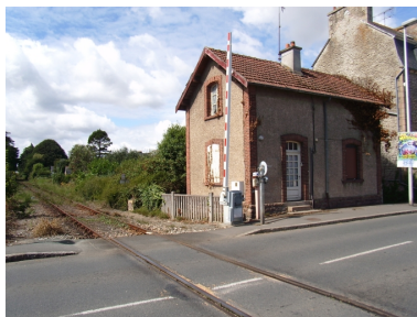
Maison du garde-barrière et passage à niveau à l'entrée du secteur urbain Phot. Patrick Pichouron IVR53_20102209566NUCA
