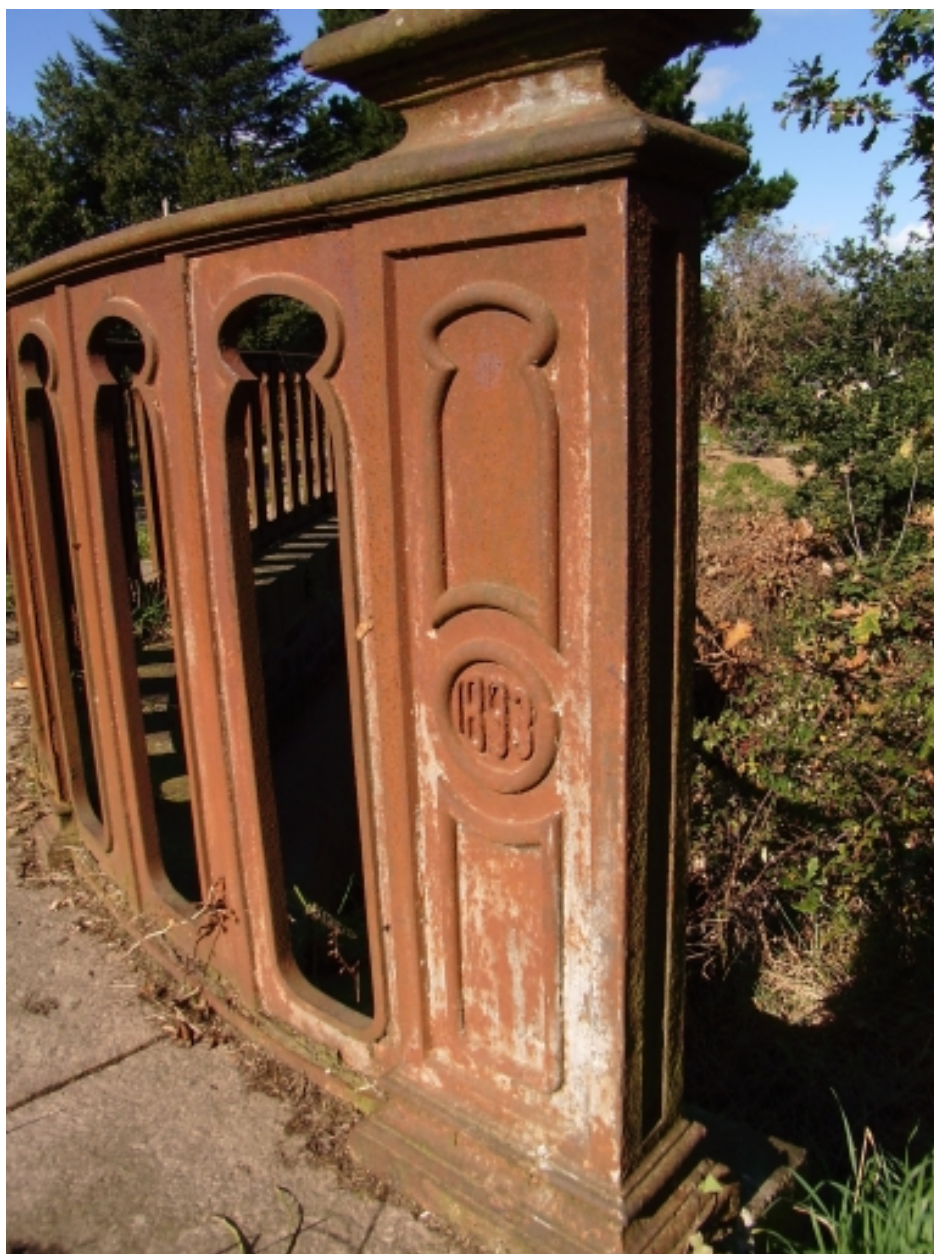
Vue détaillée du pont enjambant la voie ferrée à hauteur du lieu-dit Lostang : garde-corps en fonte moulée présentant le chronogramme 1893
