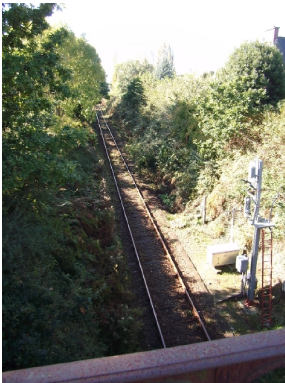
Vue générale de la voie ferrée à hauteur du lieu-dit Lostang en direction du centre-ville de Guingamp
