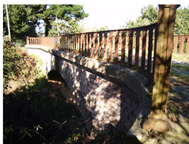
Vue générale du pont enjambant la voie ferrée à hauteur du lieu-dit Lostang
