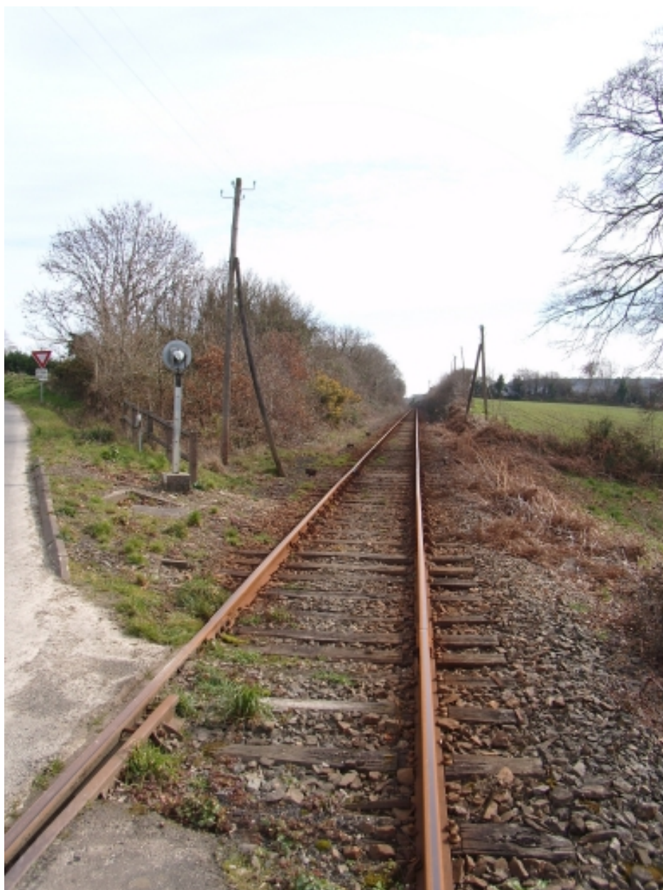
Vue générale de la voie ferrée à hauteur du lieu-dit Kerbiquet en direction du centre-ville de Paimpol
