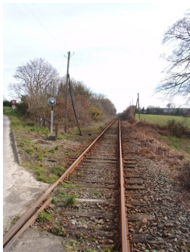
Vue générale de la voie ferrée à hauteur du lieu-dit Kerbiquet en direction du centre-ville de Paimpol Phot. Patrick Pichouron IVR53_20102209604NUCA
