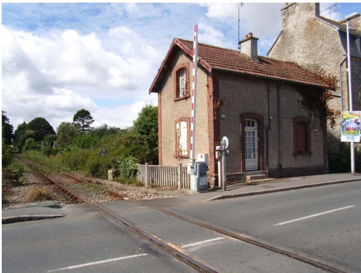
Maison du garde-barrière et passage à niveau à l'entrée du secteur urbain
