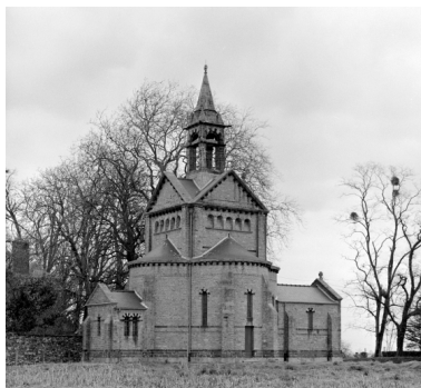
Elévation ouest : vue de situation Phot. Bernard Bègne, Phot. M. Loyon IVR53_19933500130X
