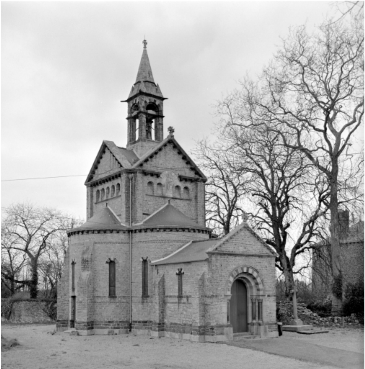
Elévation sud-est : vue générale
