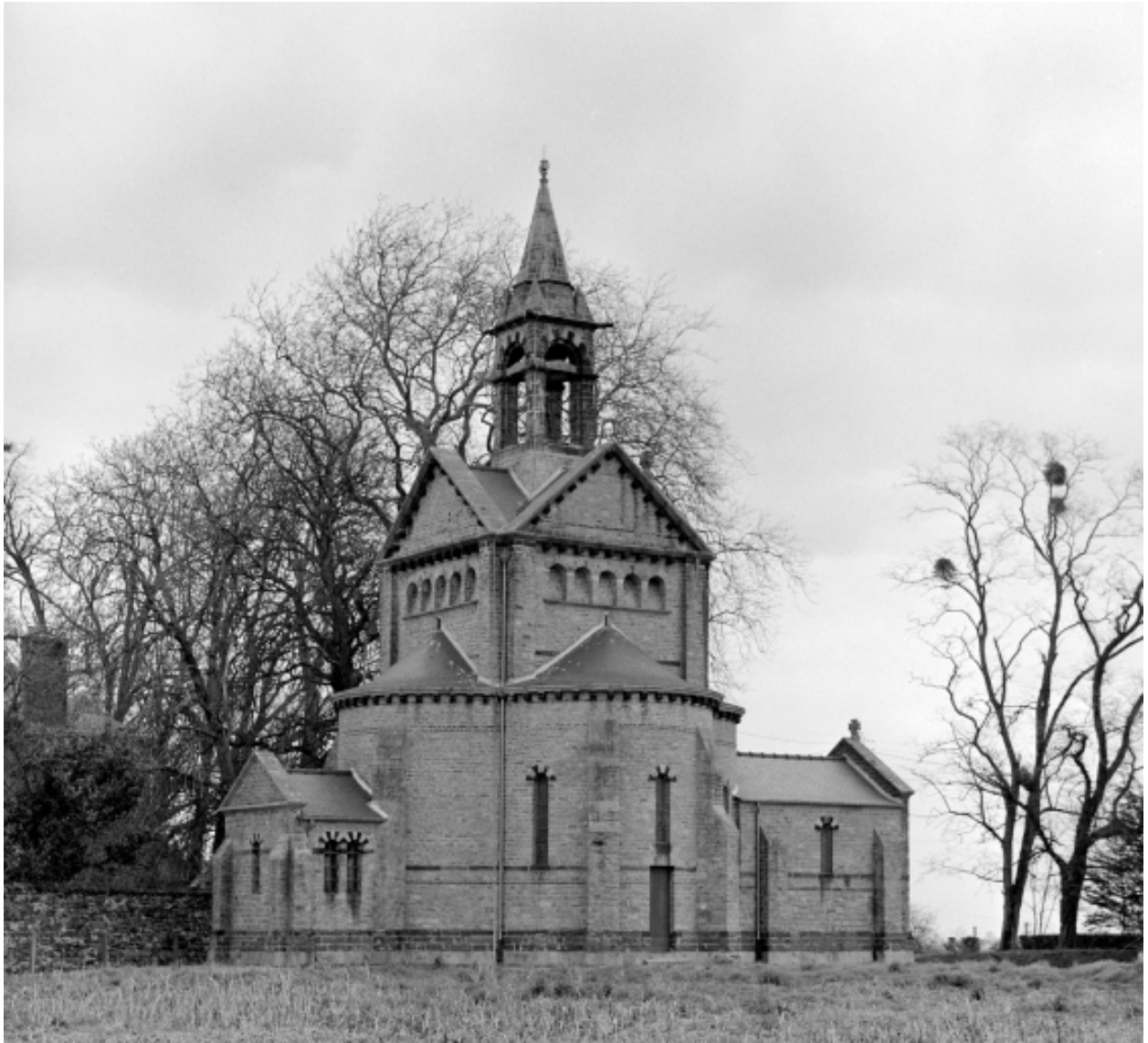
Elévation ouest : vue de situation
