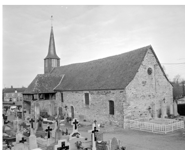
Vue générale sud est Phot. Guy Artur, Phot. Norbert Lambart IVR53_19943500674X
