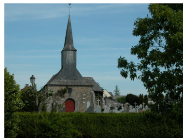
Vue générale ouest Phot. Claude Quillivic IVR53_20043504569NUCA
