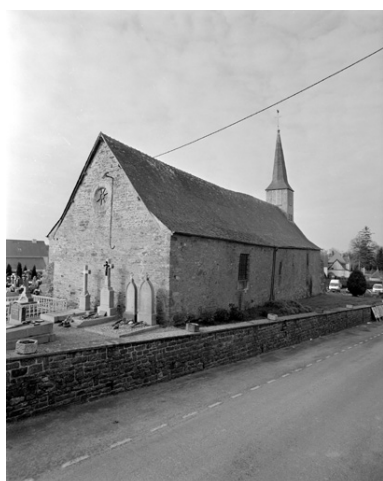
Vue générale nord est Phot. Guy Artur, Phot. Norbert Lambart IVR53_19943500677X
