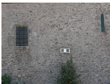
Détail ; mur nord Phot. Claude Quillivic IVR53_20043504565NUCA
