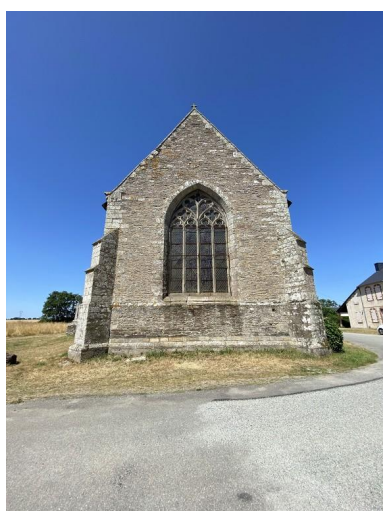
Vue est Phot. Baptiste Oligo IVR53_20255611004NUCA
