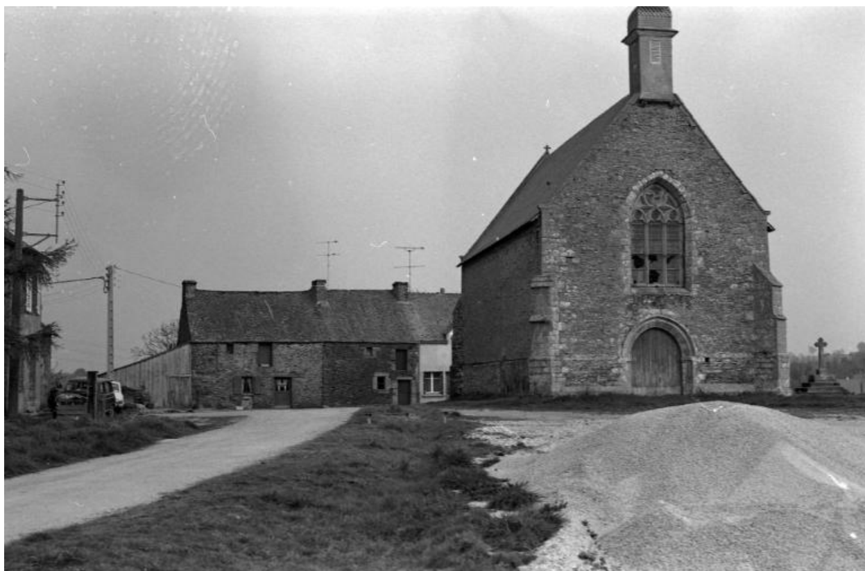
Vue générale de la façade ouest
