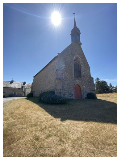
Vue nord-ouest Phot. Baptiste Oligo IVR53_20255610997NUCA
