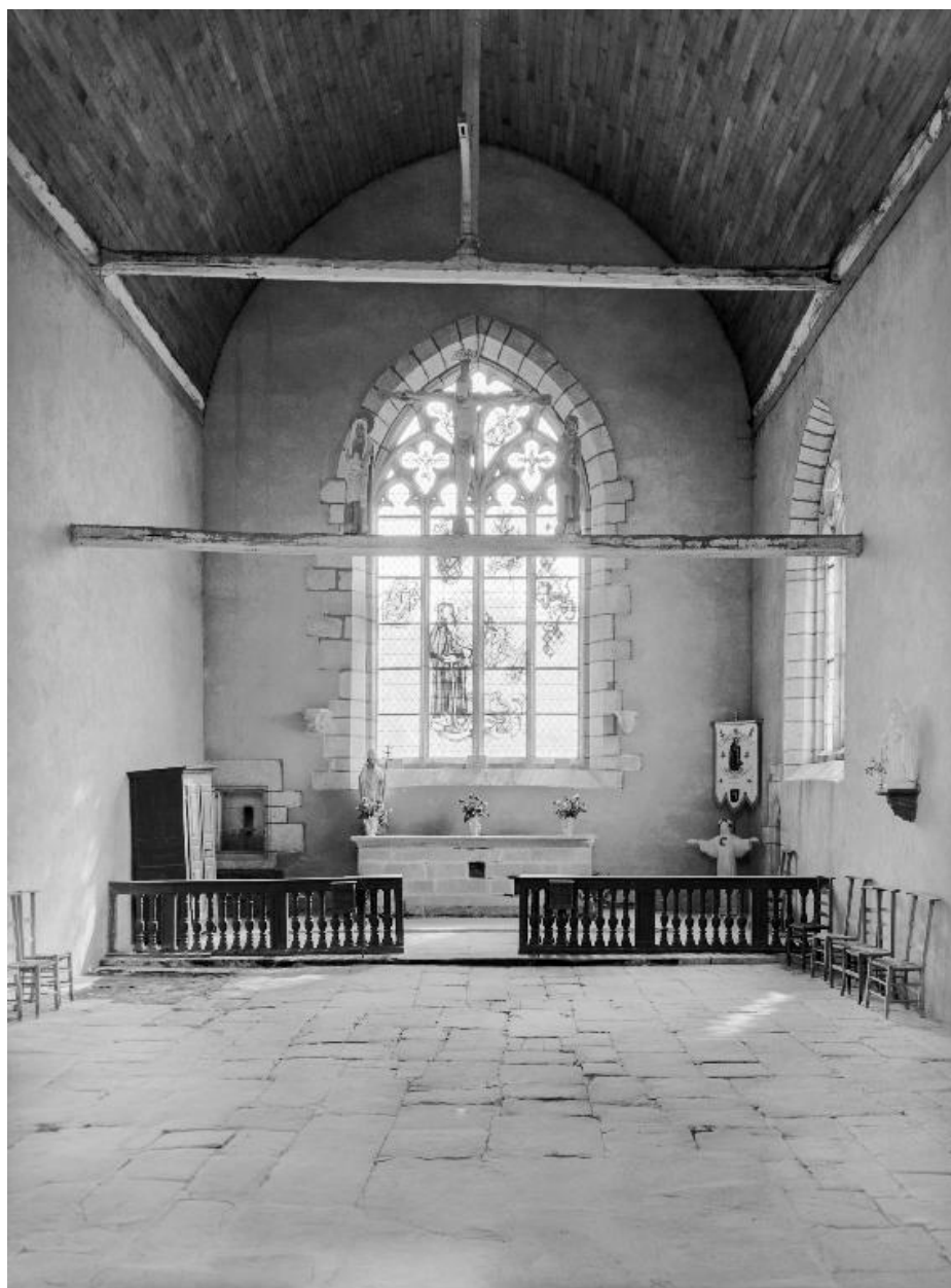
Chapelle : vue générale vers le choeur, vers l'est (état en 1984)
