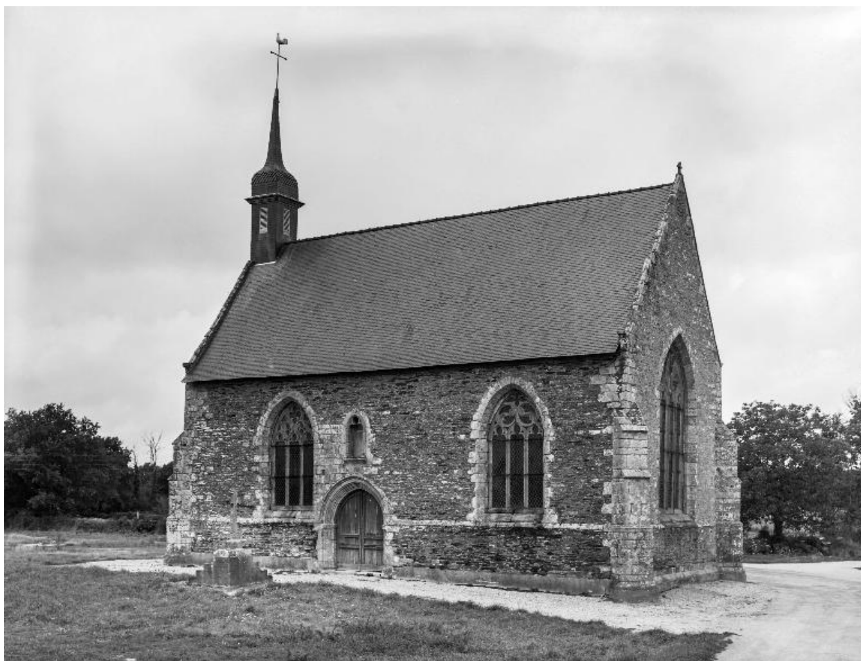
Chapelle vue depuis le sud (état en 1984)
