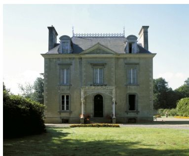
Vue nord du logis Phot. Guy Artur, Phot. Norbert Lambart IVR53_19992200484XA
