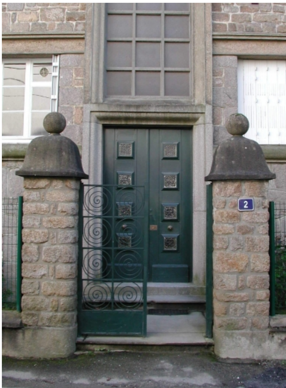
Vue de détail sur la porte d'entrée.
