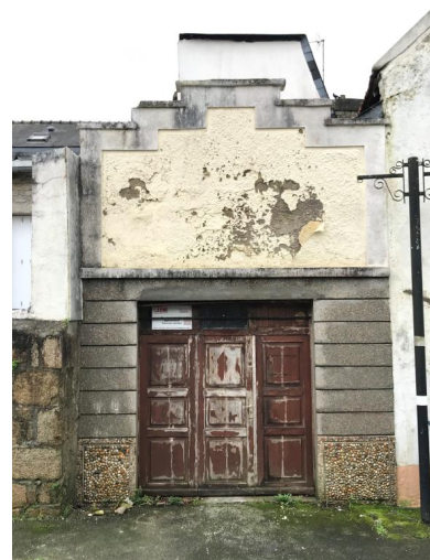
Vue arrière, garage avec pignon à redents Phot. Pierre Laurent Constantin IVR53_20225605124NUCA
