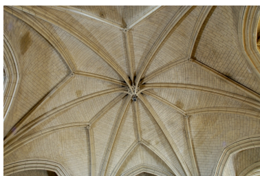
Détail des nervures Phot. Bernard Bègne IVR53_20043501902NUCA
