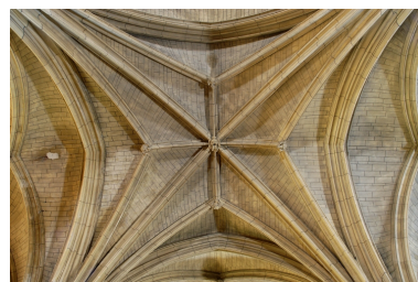
Détail des nervures Phot. Bernard Bègne IVR53_20043501904NUCA
