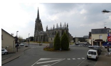
Le chevet Phot. Bernard Bègne IVR53_20043500820NUCA
