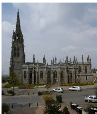
Vue sud Phot. Bernard Bègne IVR53_20043500818NUCA
